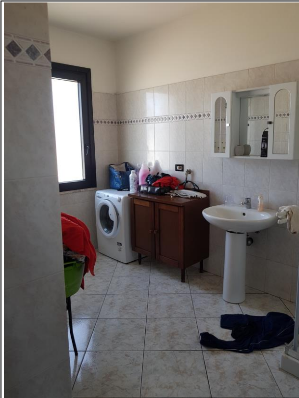
Immagine 33: Vista del bagno dell'appartamento al piano secondo.
