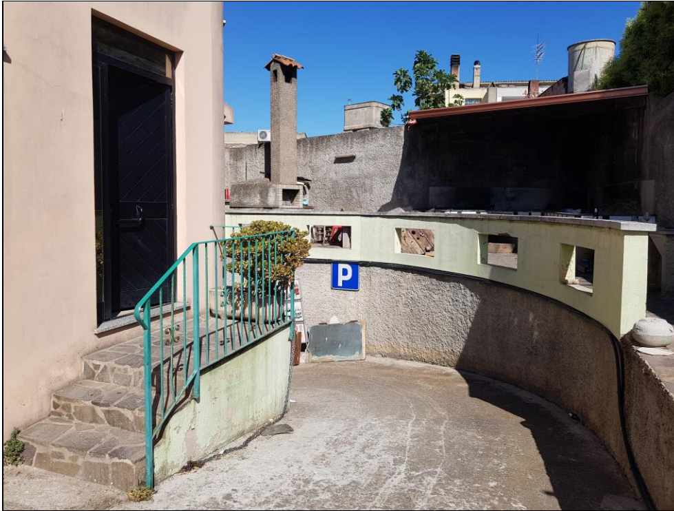
Immagine 11: Vista dell'ingresso al deposito - seminterrato.
