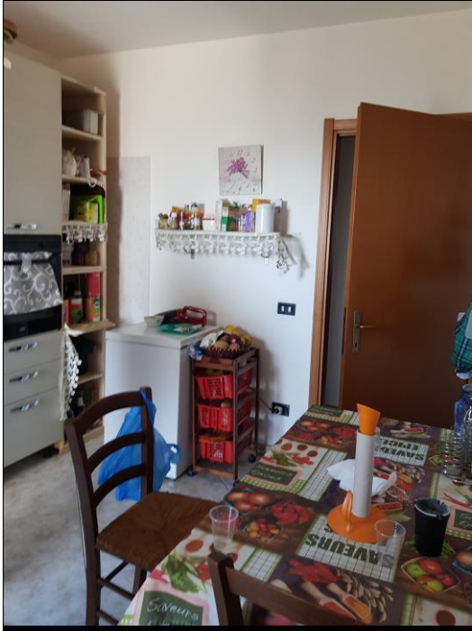
Immagine 19: Particolare del soffitto del bagno dell'appartamento al primo piano.
