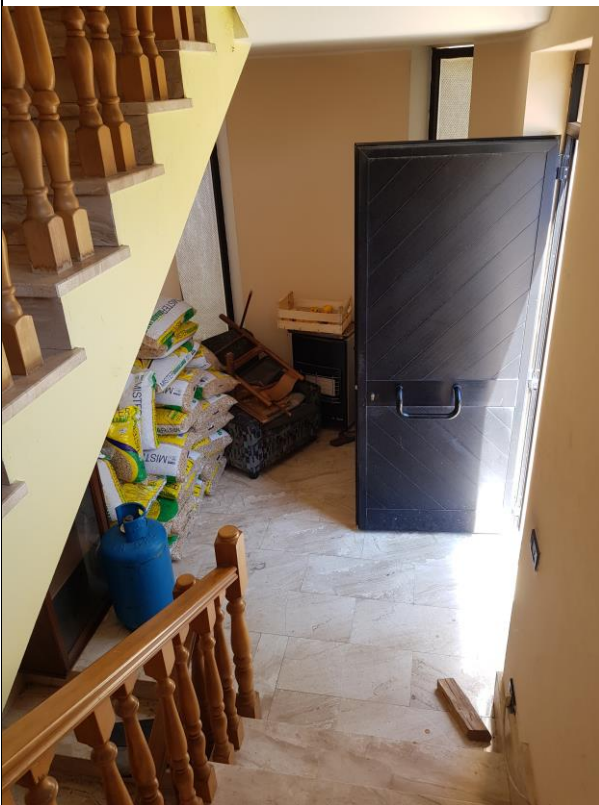
Immagine 16: Vista dell'ingresso verso le scale che portano alle abitazioni.
