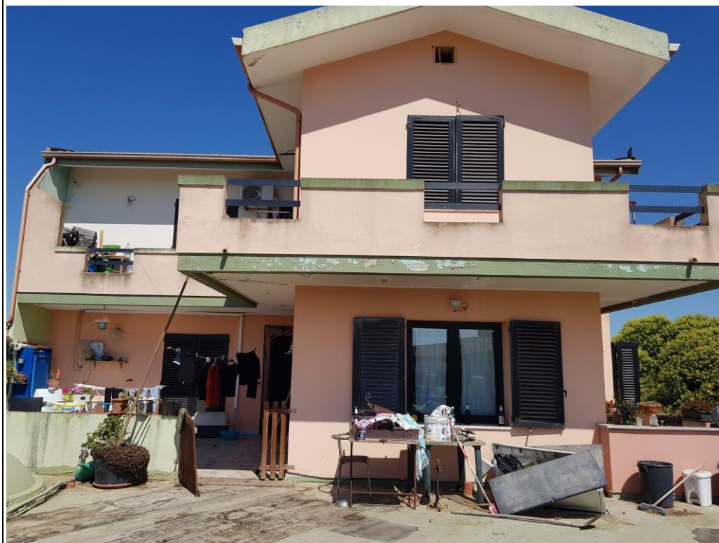
Immagine 20: Vista degli appartamenti dalla terrazza a livello sita al primo piano.
