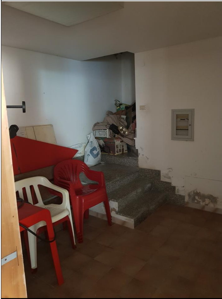
Immagine 13: Vista del deposito seminterrato
