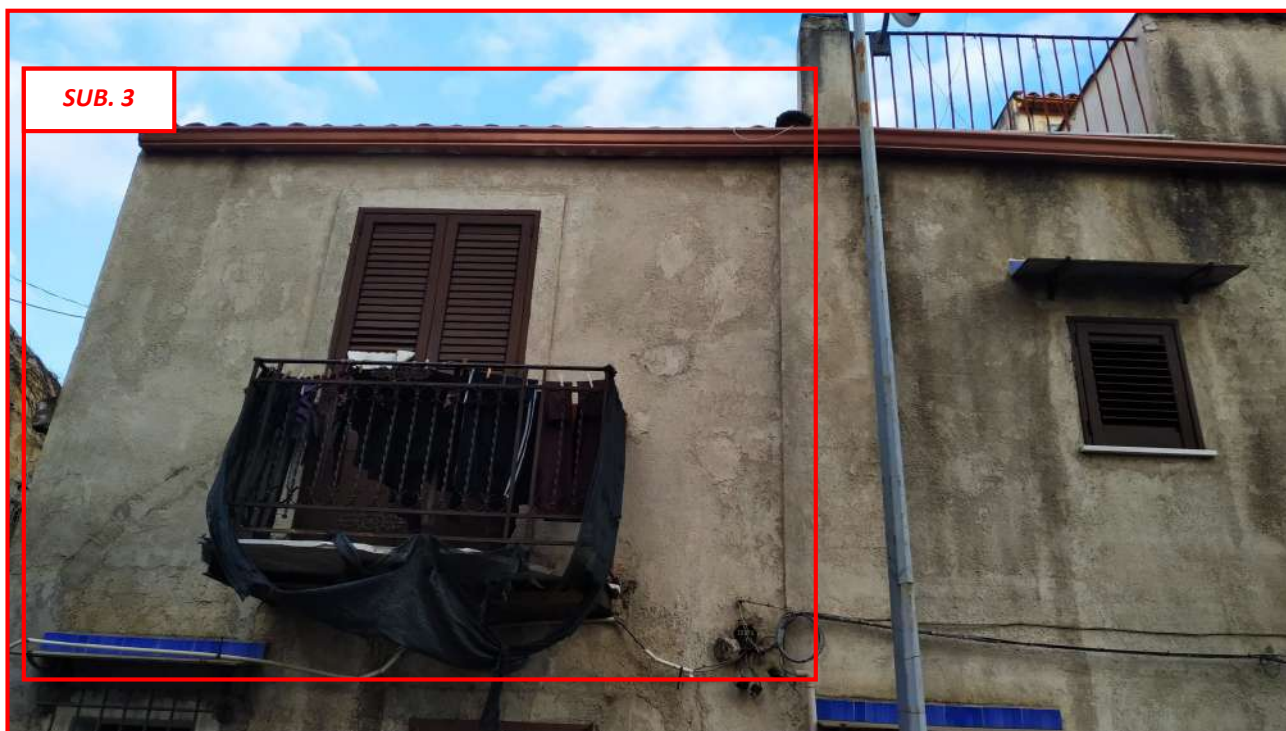
Foto n. 3 - Esterni del complesso immobiliare - prospetto su via Casalino - Individuazione delle particelle.
