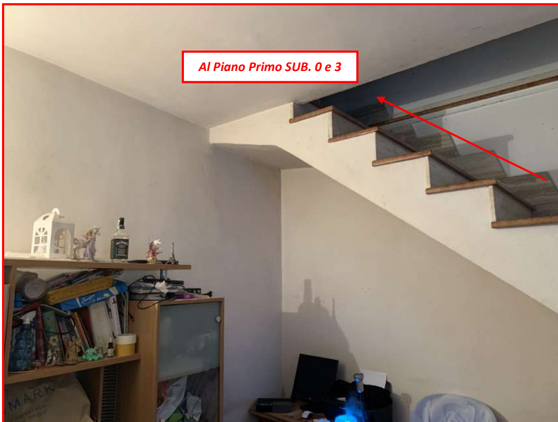
Foto n. 9 - Interni dell'unità immobiliare SUB. 0 - Piano Terra -
