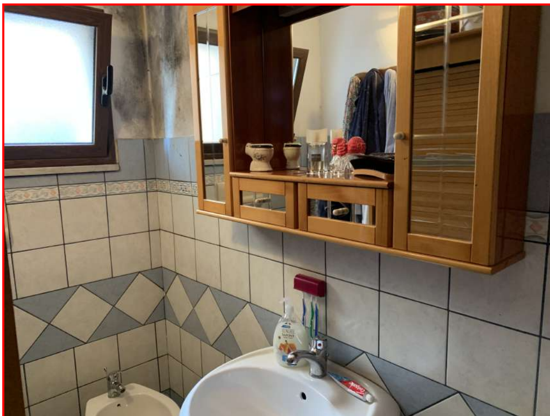
Foto n. 7 - Interni dell'unità immobiliare SUB. 1 - Piano Terra - vano destinato al servizio igienico.
