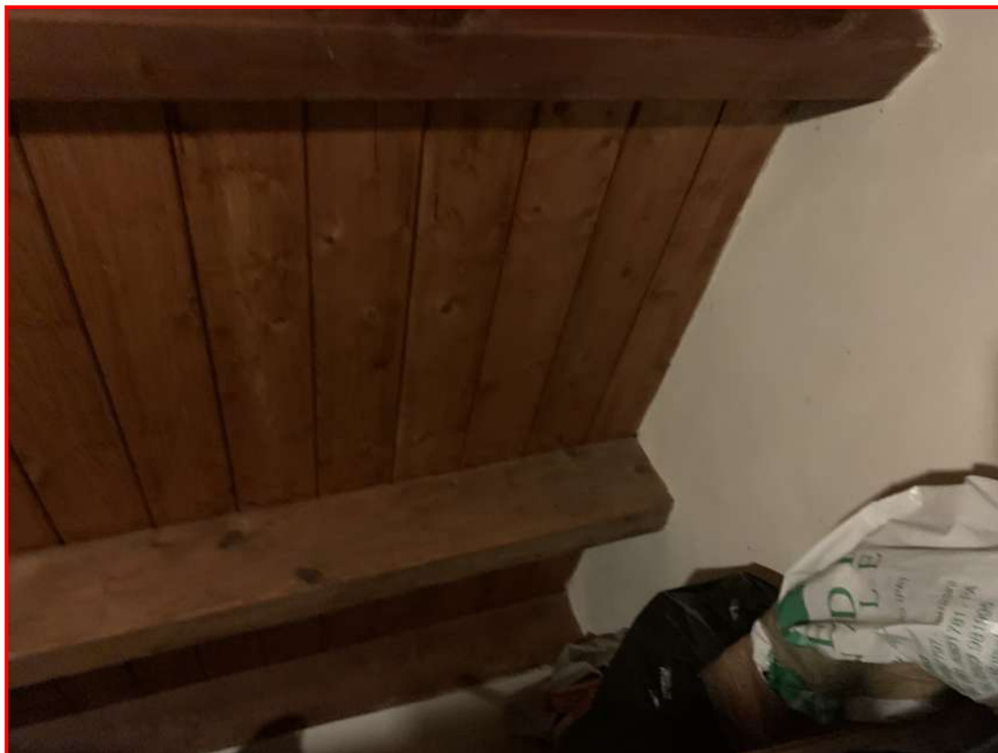
Foto n. 16 - Interni dell'unità immobiliare SUB. 3 - Piano Primo - Sottotetto
