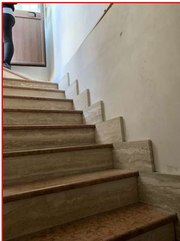
Foto n. 17 - Interni dell'unità immobiliare SUB. 0 - Piano Primo - Scala per il secondo piano (Terrazzo).
