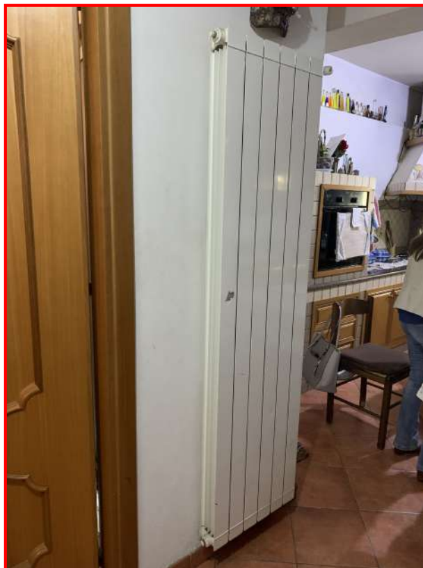
Foto n. 6 - Interni dell'unità Immobiliare SUB: 1 - Piano Terra
