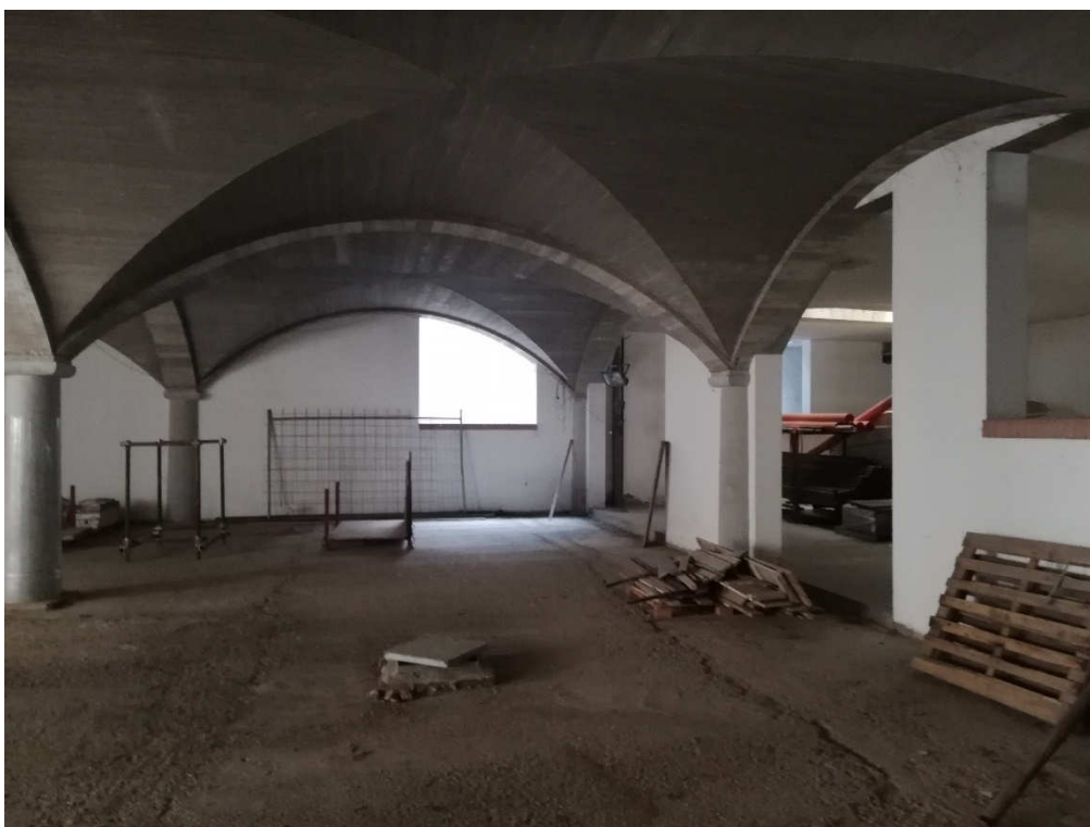
VISTA 23 – interrato capannone
