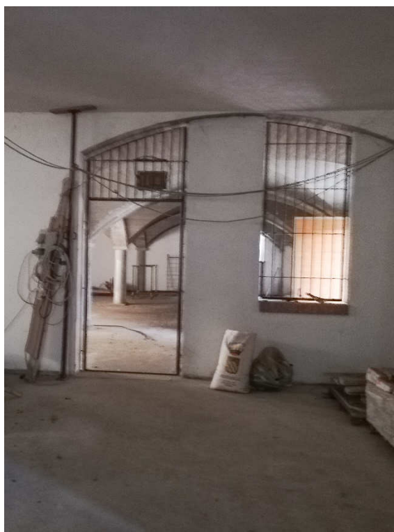
VISTA 32 – interrato appartamento
