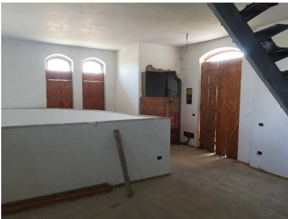
VISTA 47 – appartamento piano 1°
