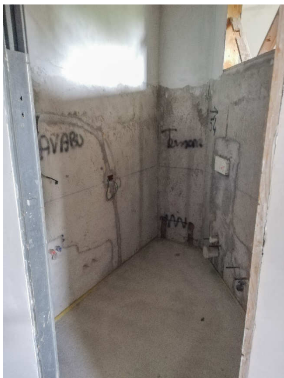
VISTA 55 – appartamento piano 1°
