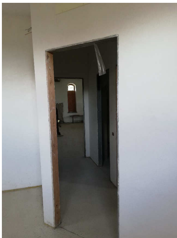
VISTA 50 – appartamento piano 1°
