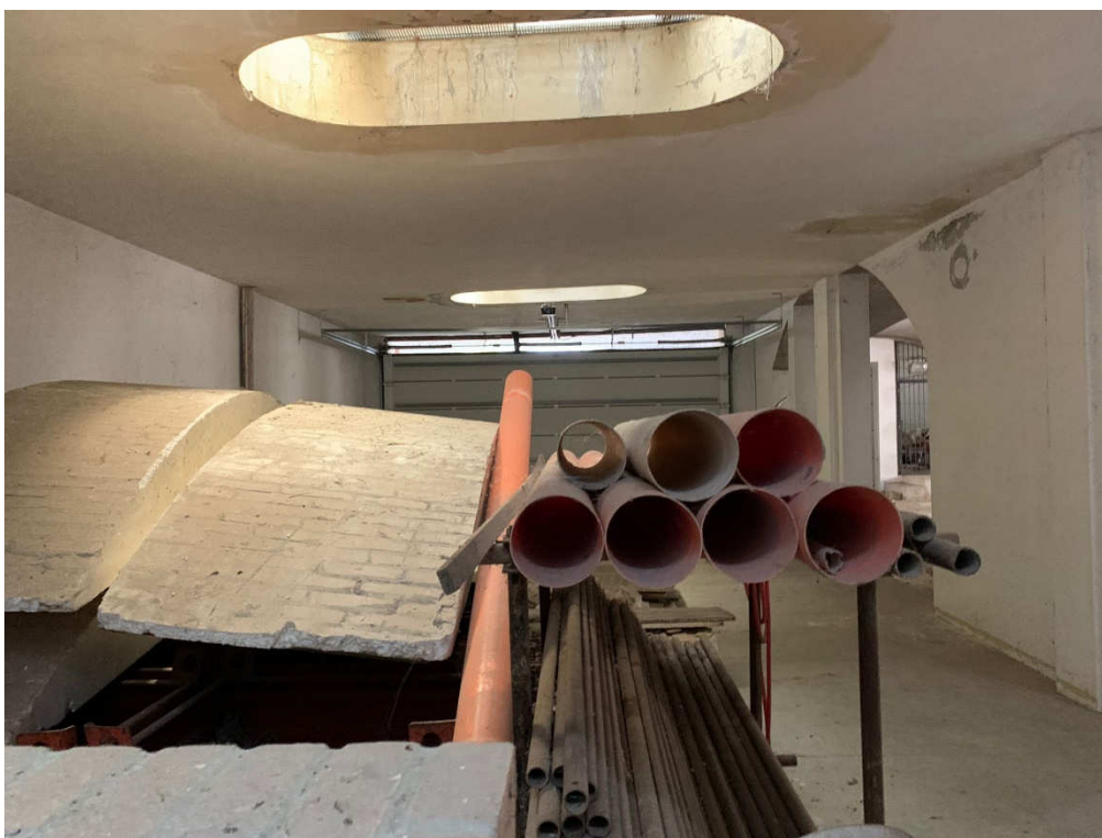
VISTA 24 – interrato capannone
