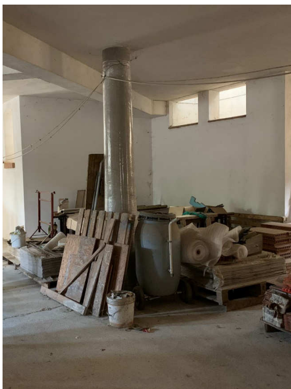
VISTA 29 – interrato appartamento
