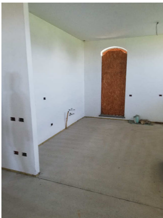
VISTA 49 – appartamento piano 1°
