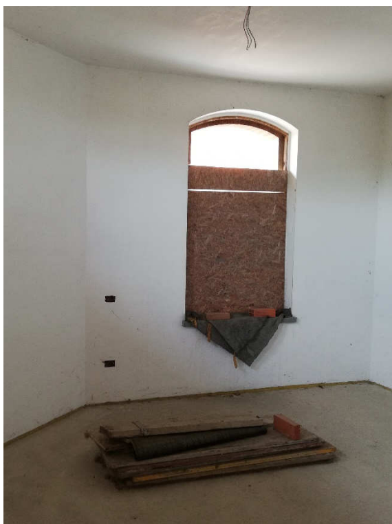
VISTA 51 – appartamento piano 1°
