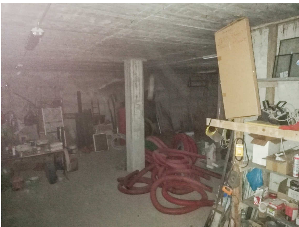
VISTA 33 – magazzino interrato
