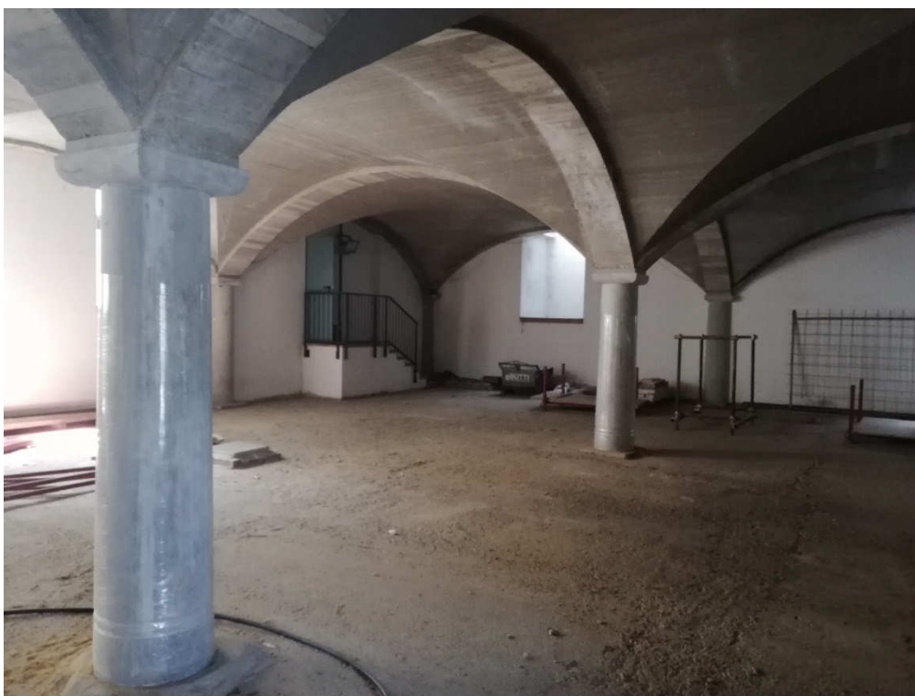
VISTA 22 – interrato capannone
