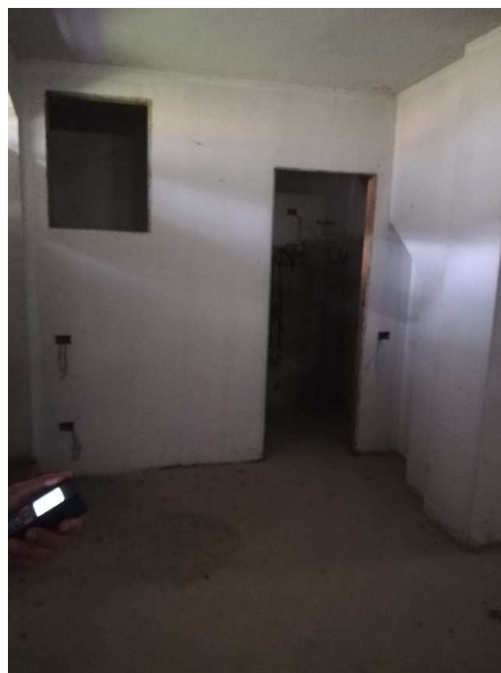
VISTA 15 – interrato uffici
