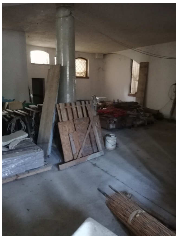
VISTA 30 – interrato appartamento
