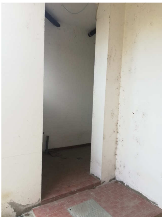
VISTA 27 – interrato appartamento
