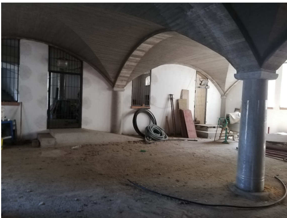
VISTA 20 – interrato capannone
