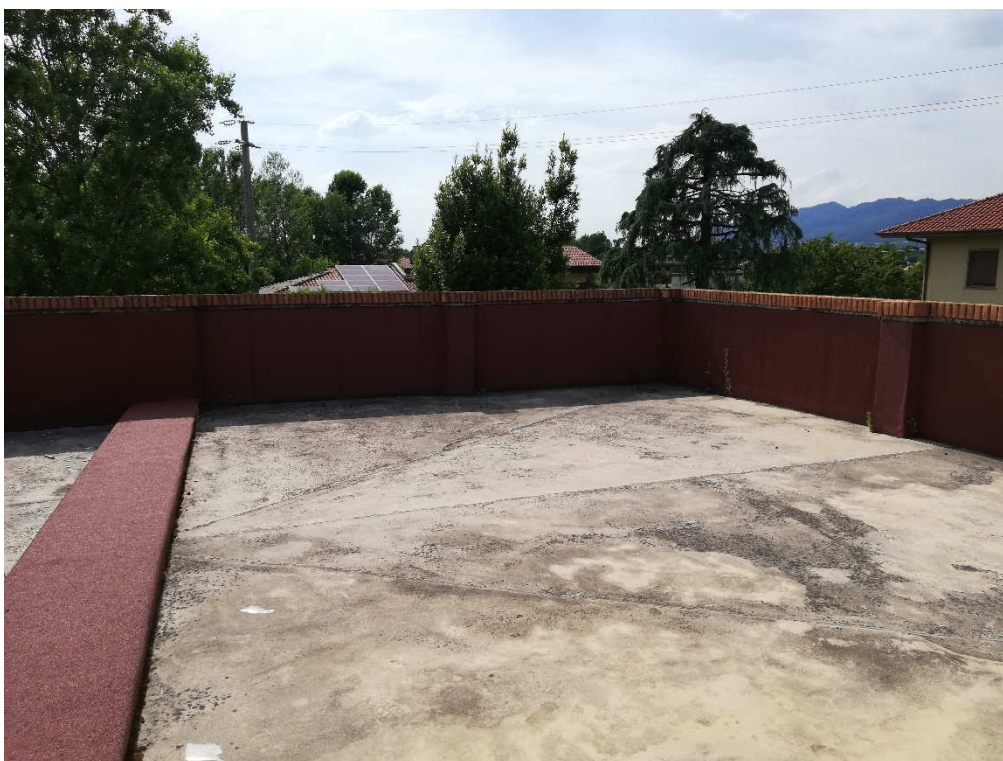
VISTA 65 – copertura uffici
