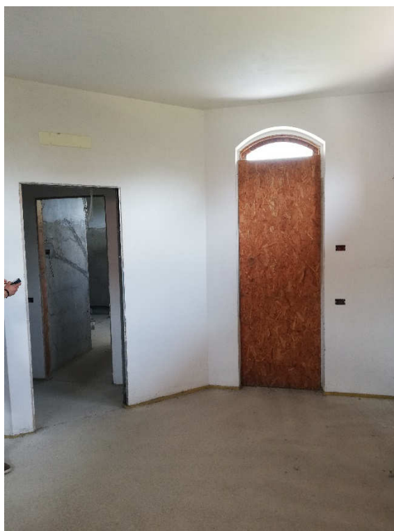
VISTA 52 – appartamento piano 1°
