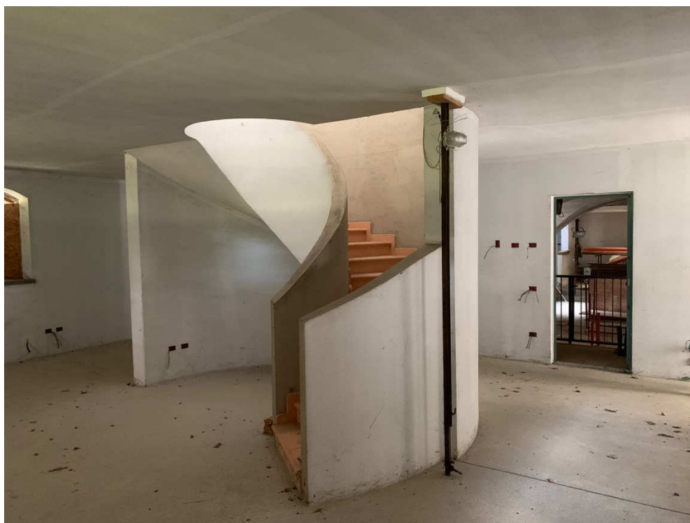
VISTA 13 – interrato uffici
