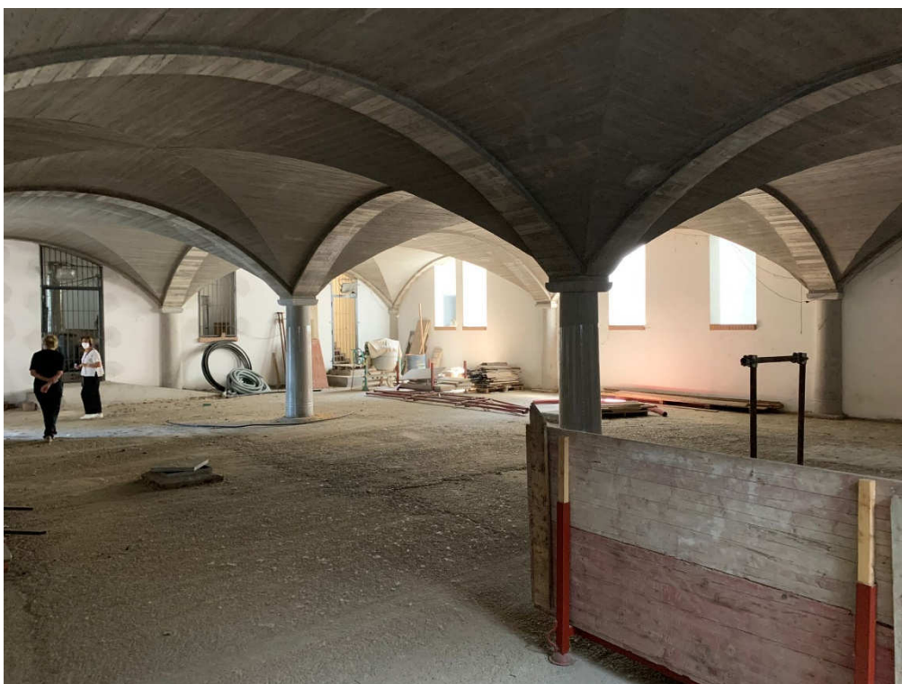
VISTA 19 – interrato capannone
