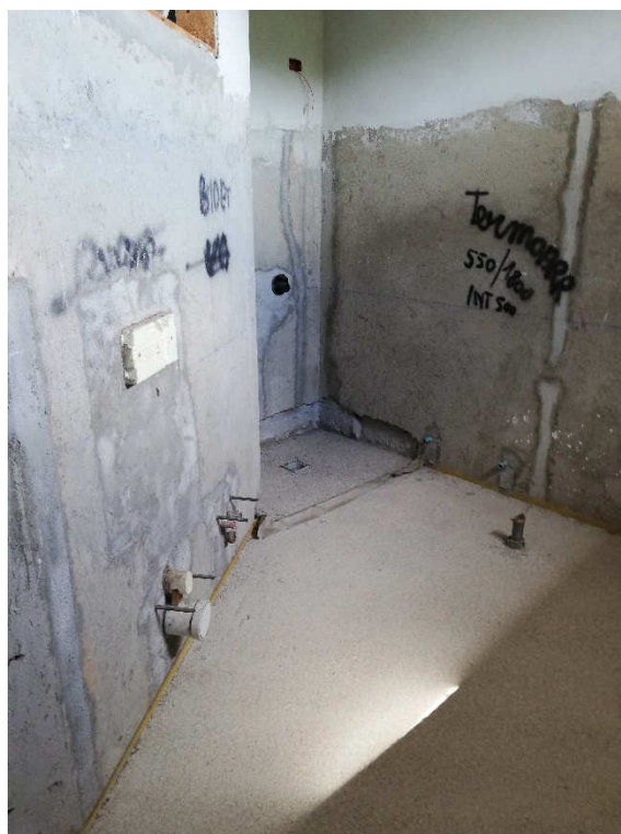
VISTA 54 – appartamento piano 1°
