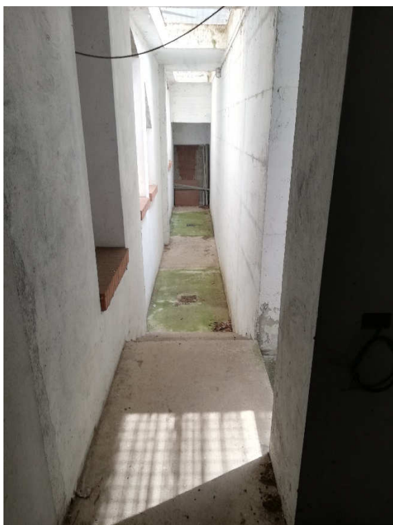
VISTA 16 – interrato uffici
