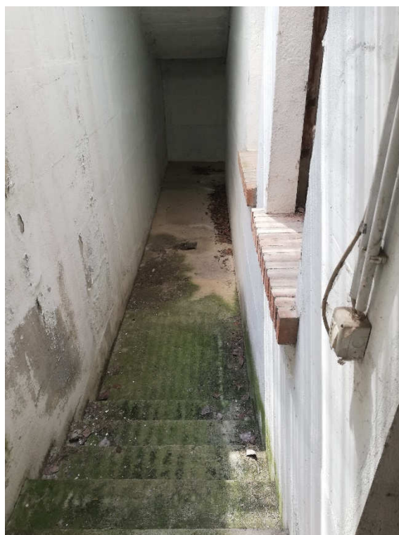
VISTA 17 – interrato uffici
