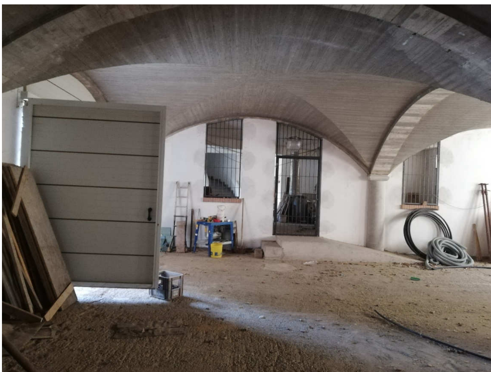
VISTA 21 – interrato capannone
