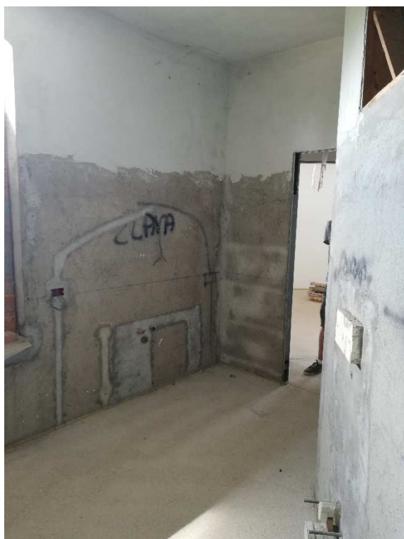
VISTA 53 – appartamento piano 1°
