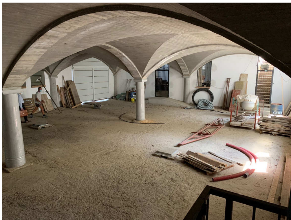
VISTA 18 – interrato capannone
