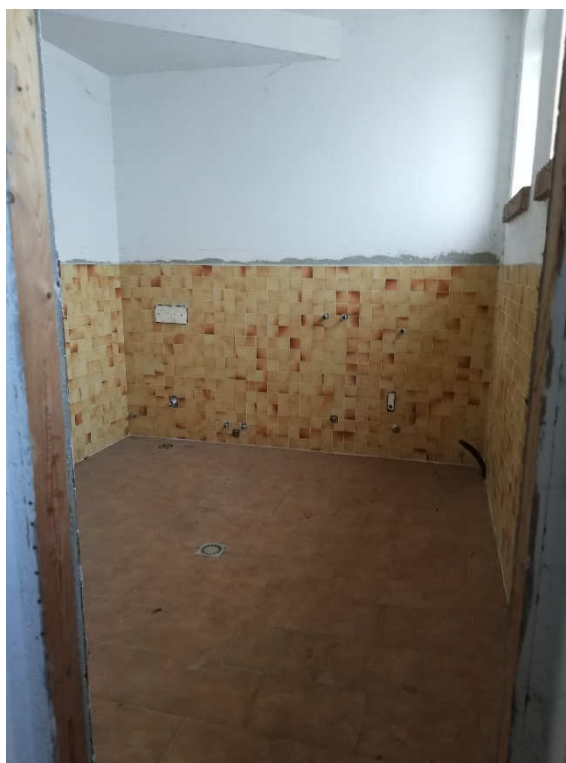
VISTA 28 – interrato appartamento
