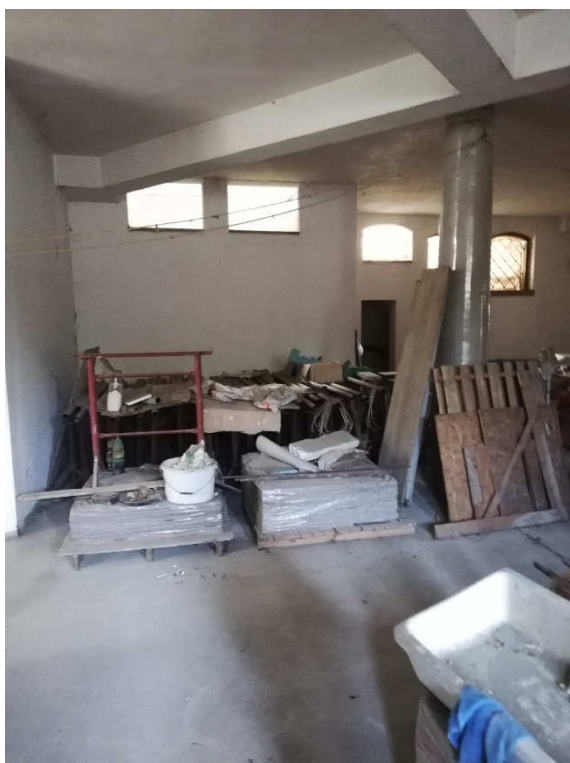
VISTA 31 – interrato appartamento
