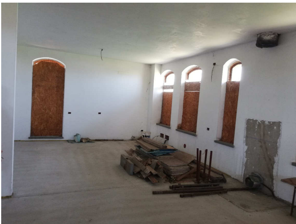
VISTA 48 – appartamento piano 1°
