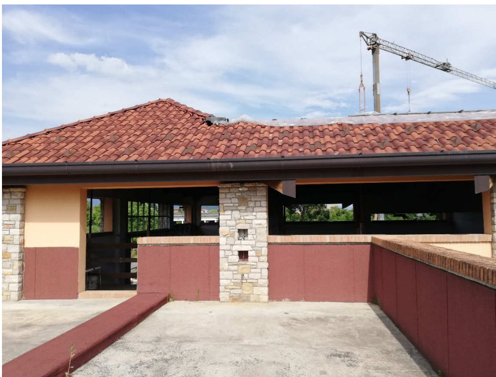
VISTA 66 – copertura uffici
