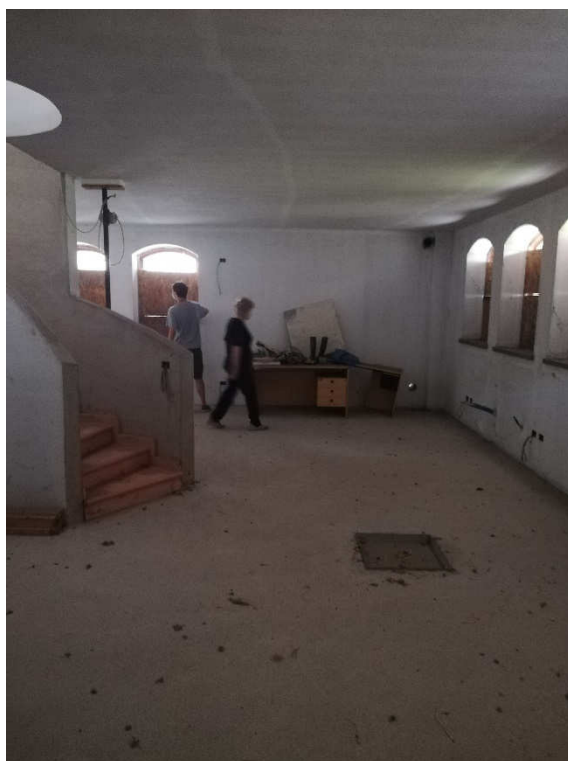
VISTA 14 – interrato uffici
