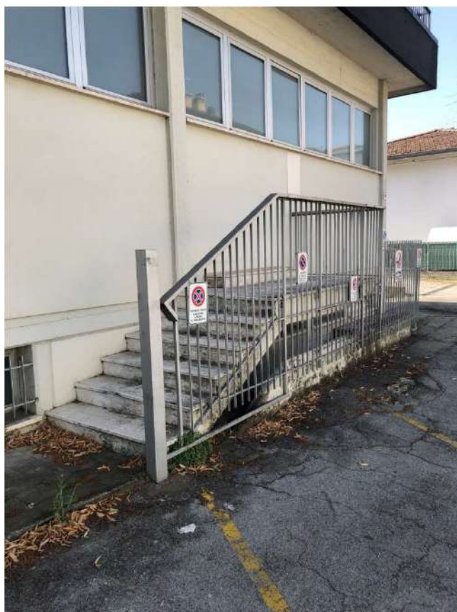
Foto 18 - Prospetto Nord-Ovest – Viale Roma
