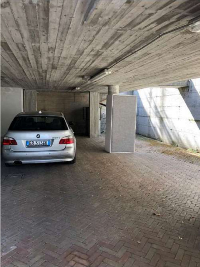
Foto 7 – Piano interrato – area esterna
