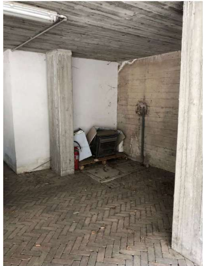
Foto 8 - Piano interrato – area esterna
