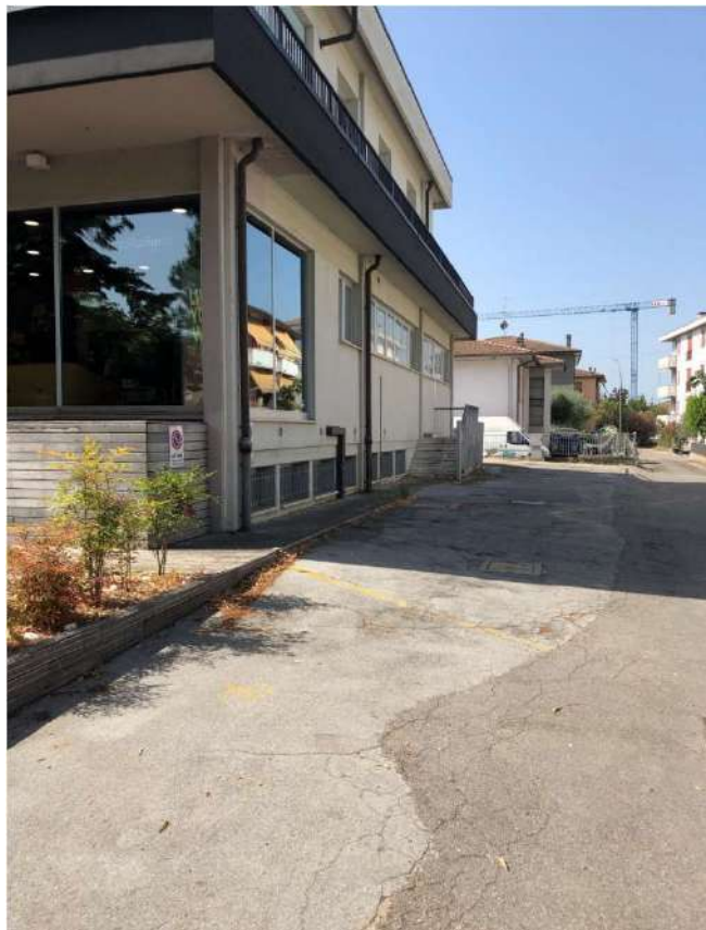
Foto 26 - corte lato ovest– Viale Roma
