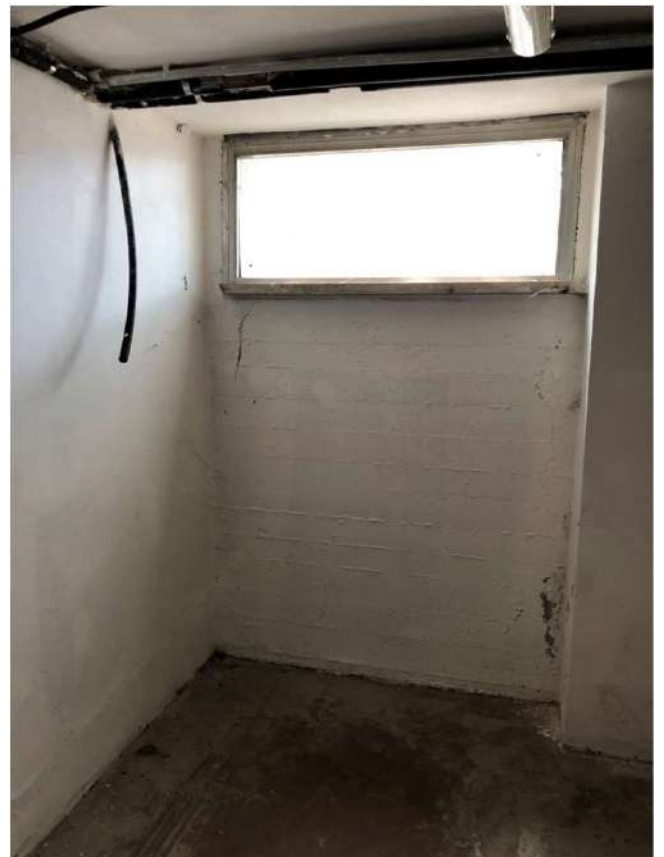
Foto 16 - Piano interrato – vano tecnico
