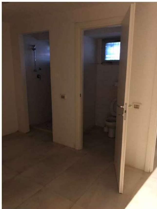
Foto 22 - Piano interrato –zona servizi
