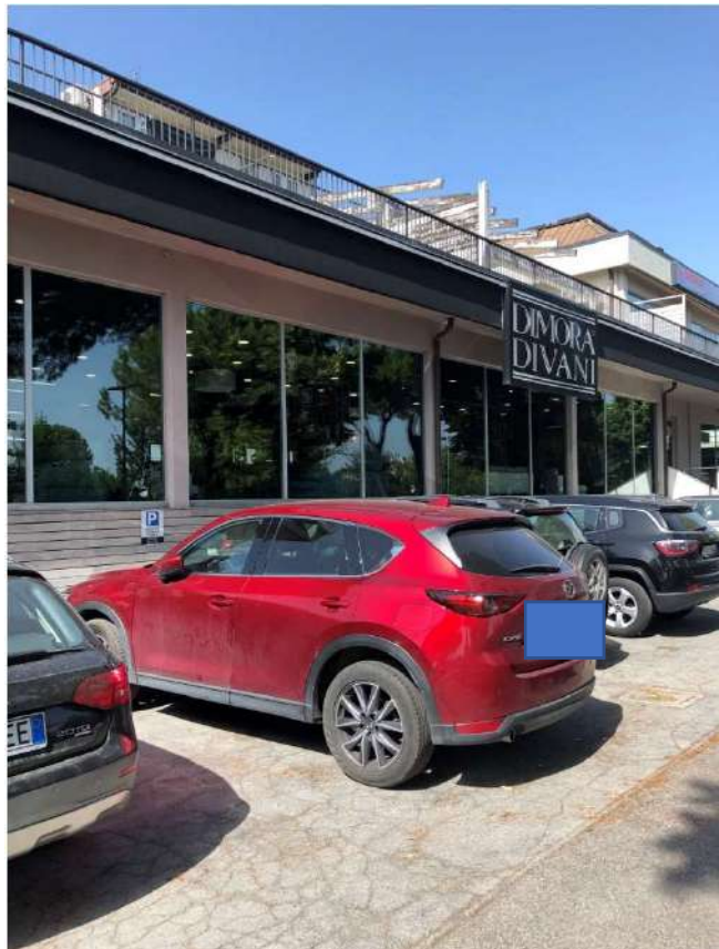
Foto 24 – corte lato nord– Viale Roma
