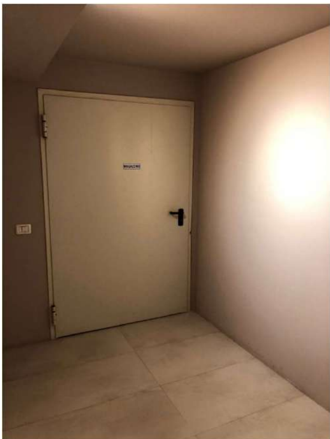
Foto 21 - Piano interrato – accesso alla zona servizi
