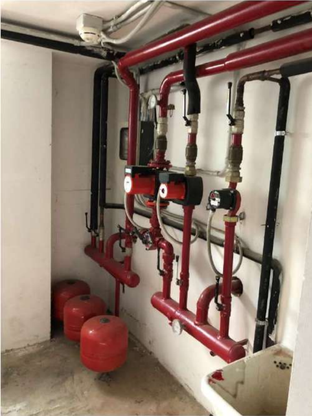
Foto 15 - Piano interrato – vano tecnico
