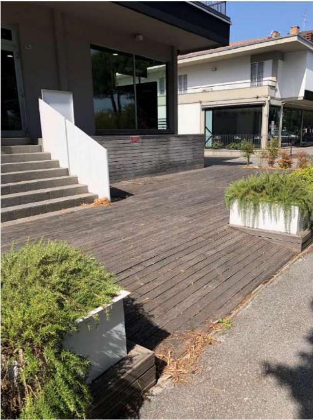
Foto 25 - corte lato nord– Viale Roma
