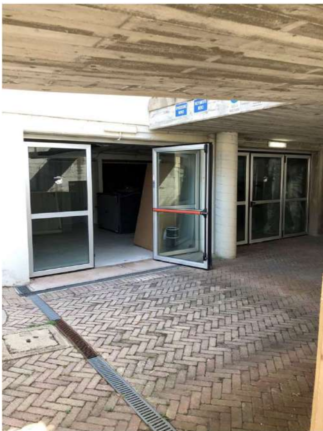
Foto 9 - Piano interrato – area esterna
