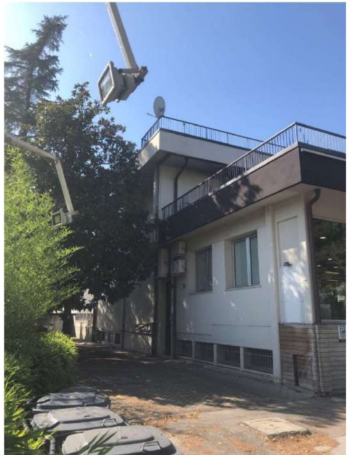
Foto 4 - Prospetto Sud-Ovest – Viale Roma
