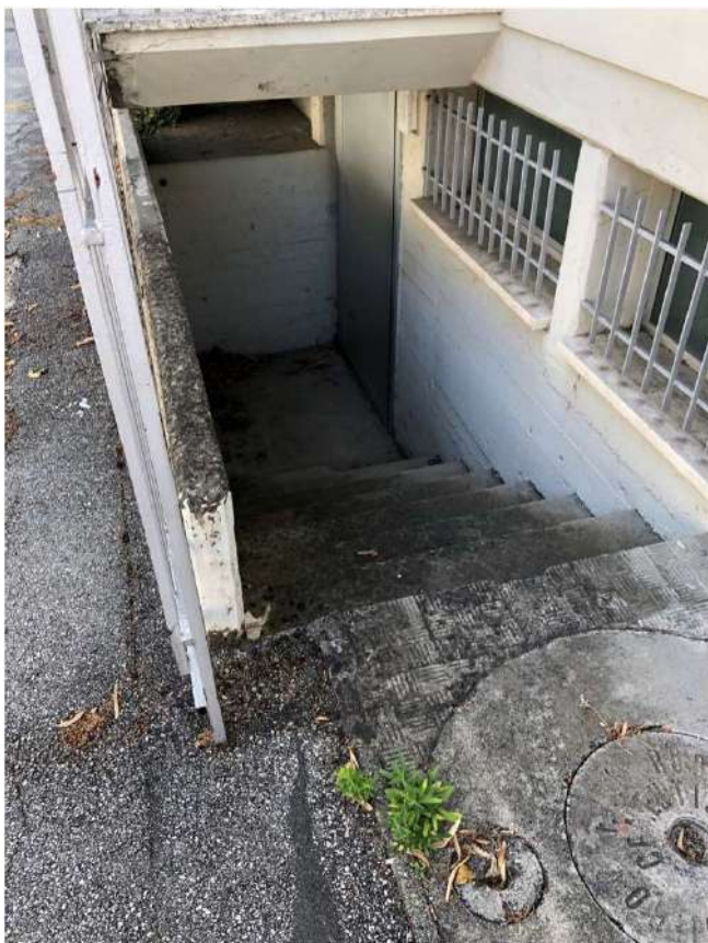
Foto 17 - Piano interrato – accesso alla CT
