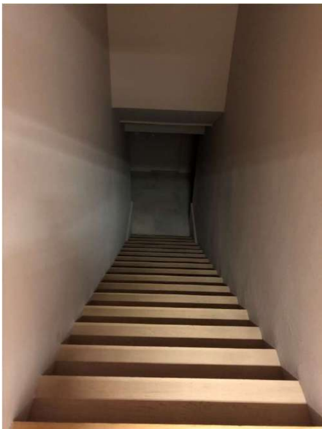
Foto 35 - Piano terra – accesso dal piano S1
