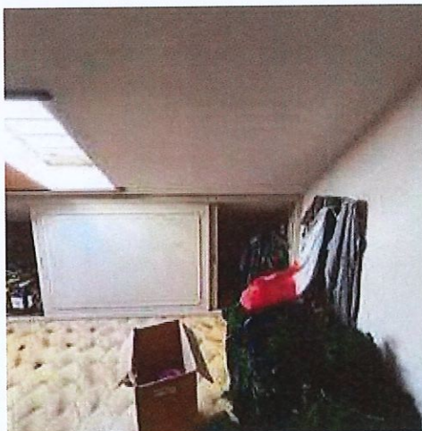
Particolare del piano sottotetto
