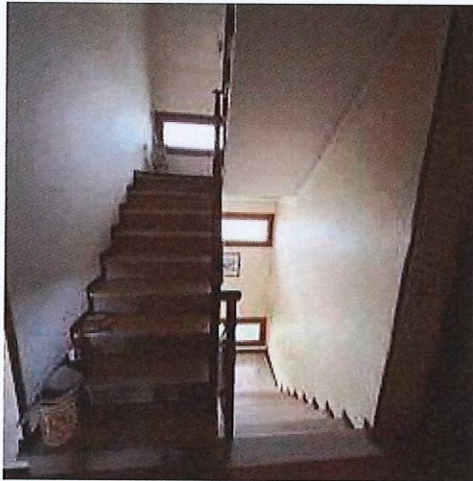
Particolare della scala di collegamento tra i piani
