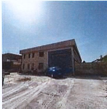
Veduta esterna del capannone con il piazzale a corredo
