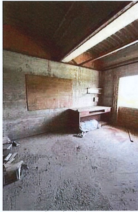
Particolare di un vano
