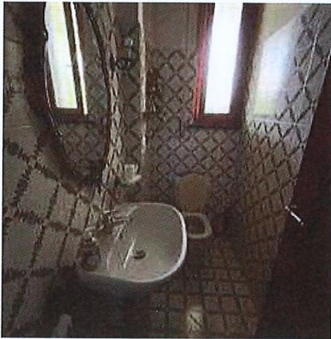
Bagno al piano terra
