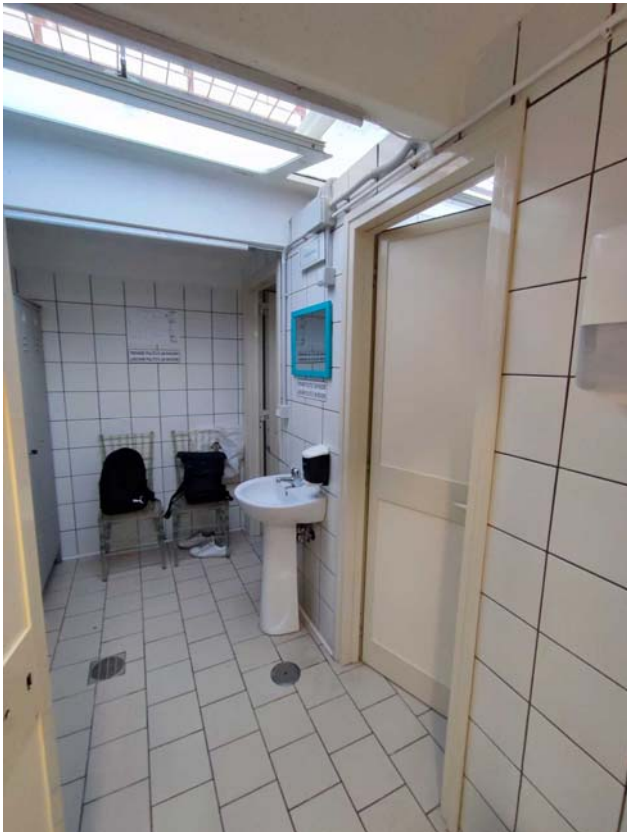
Foto 17. Spogliatoi e bagni (Sub.3)
