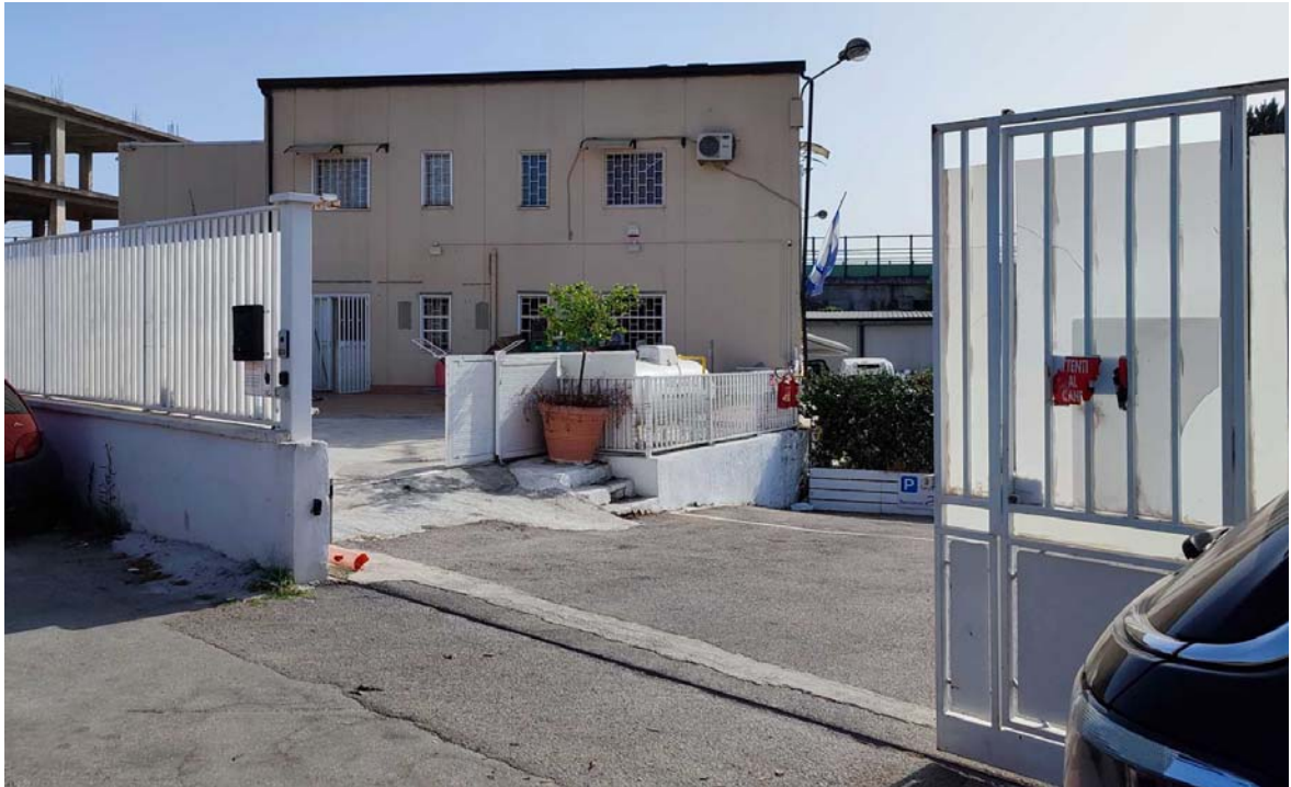
Foto 01. Immobile visto da Trav. I di via Ponteselice
