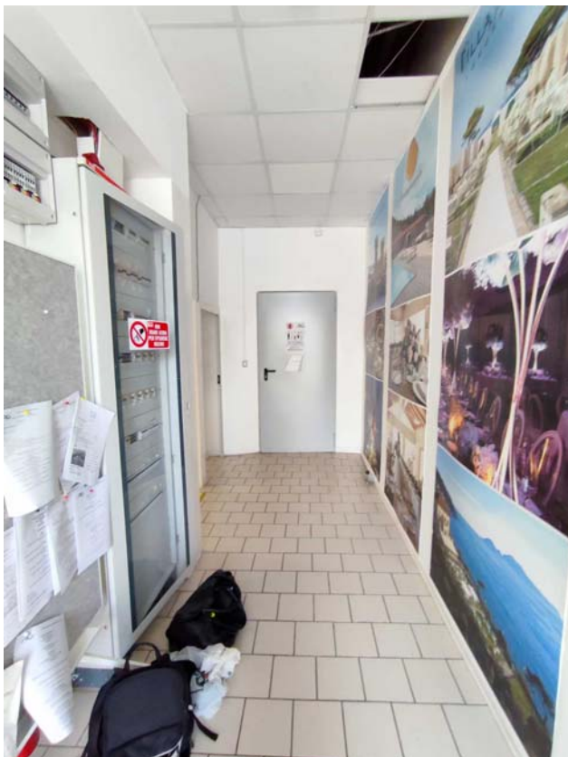
Foto 08. Ingresso Disimpegno (Sub.3)
