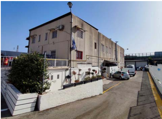
Foto 19. Spazio esterno fronte Nord (Sub.1)
