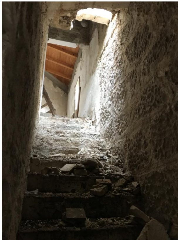
VISTA 8_ rampa scala per accesso sottotetto
