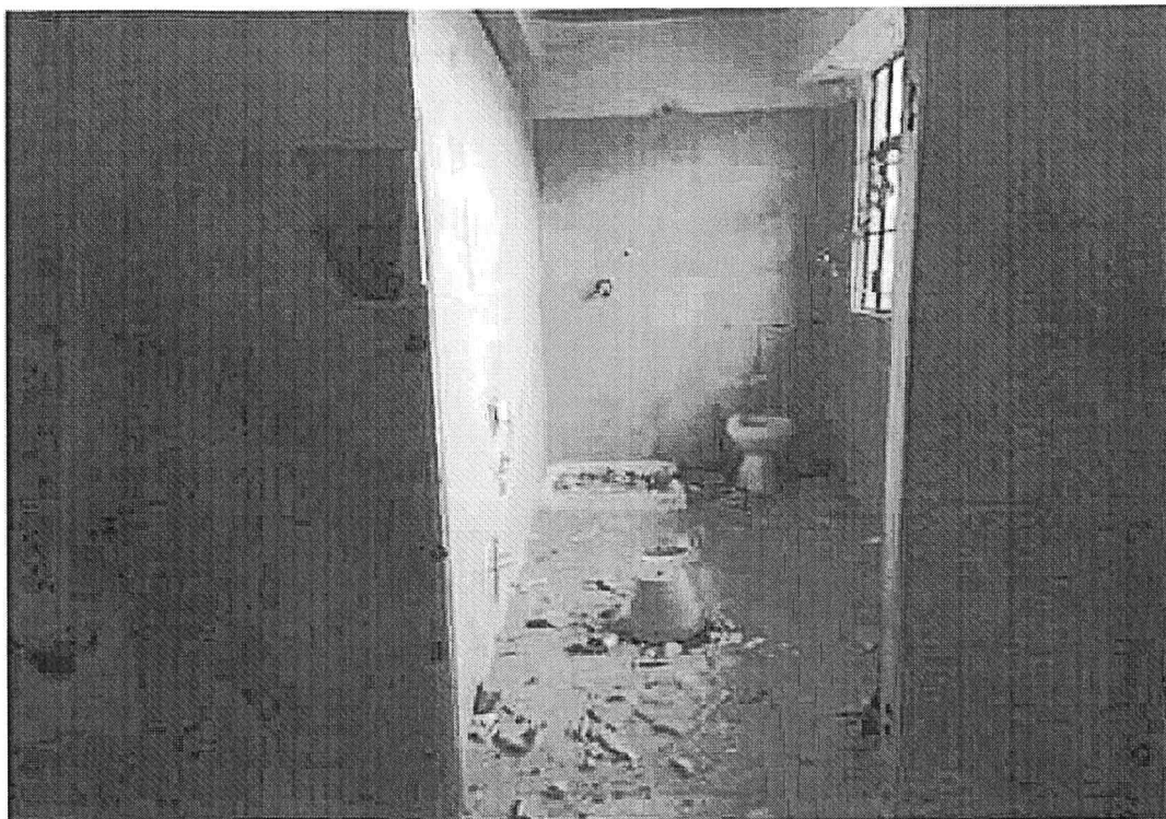
FOTO 21 -Piano Secondo sottostrada
