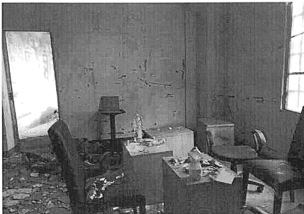
FOTO 20 -Piano Secondo sottostrada
