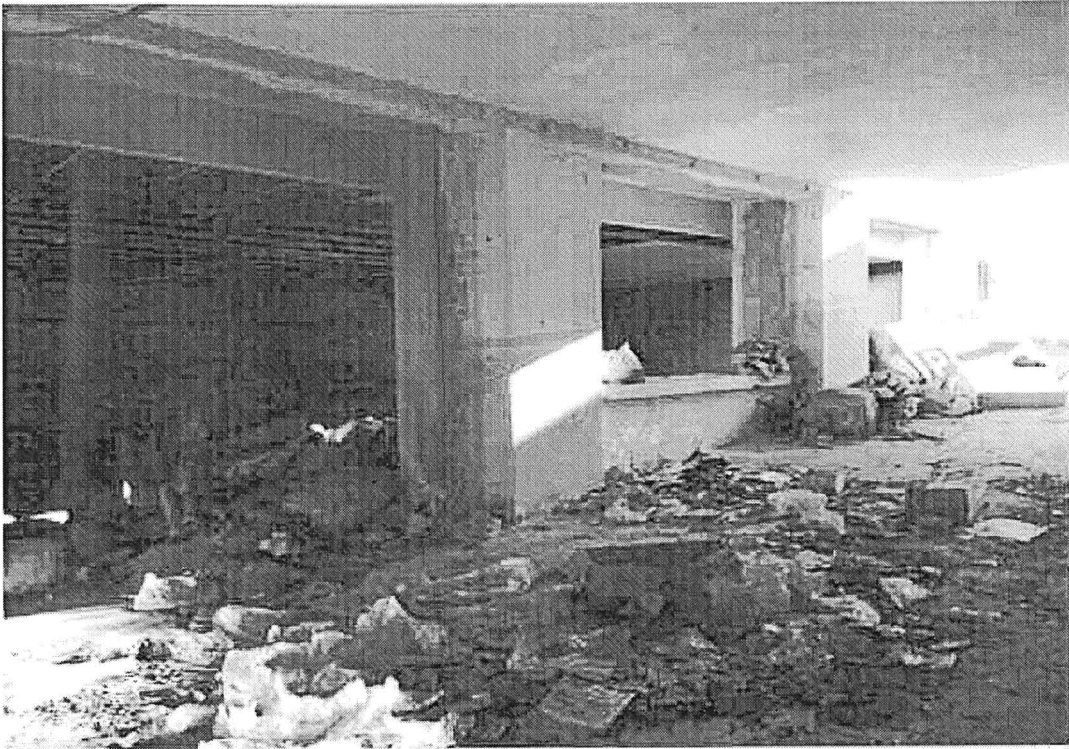
FOTO 13- Piano Primo sottostrada
