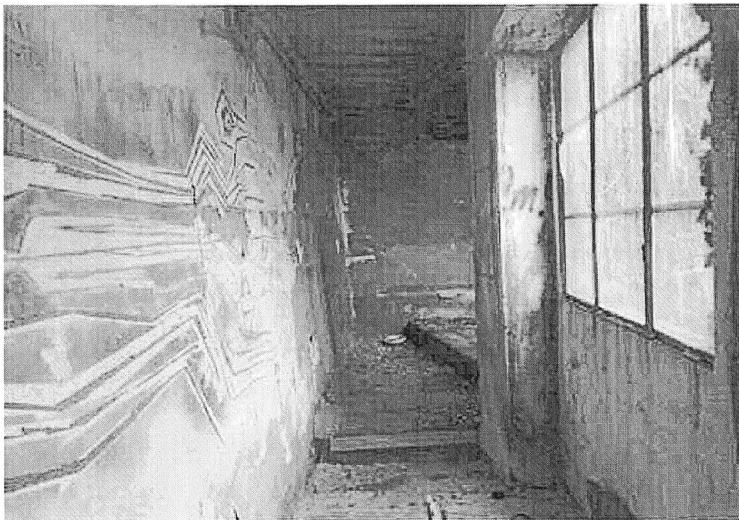
FOTO 19 -Piano Secondo sottostrada
