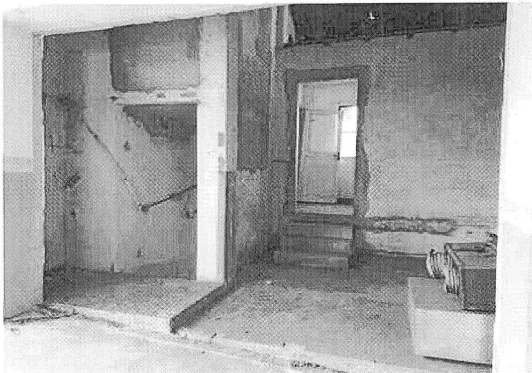
FOTO 14 - Piano Primo sottostrada
