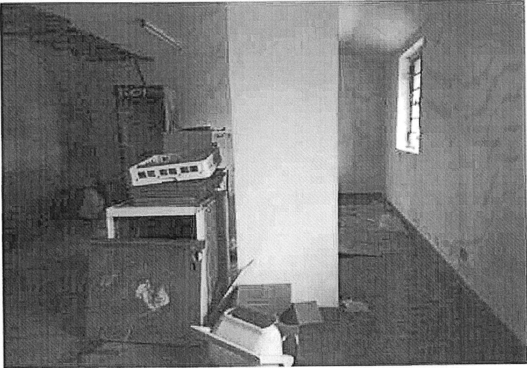
FOTO 18 Piano Primo sottostrada
