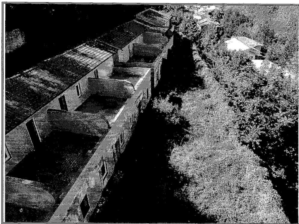
Foto n. 10 Vista dell'area antistante i fabbricati, ricoperta da abbondante vegetazione spontanea.
