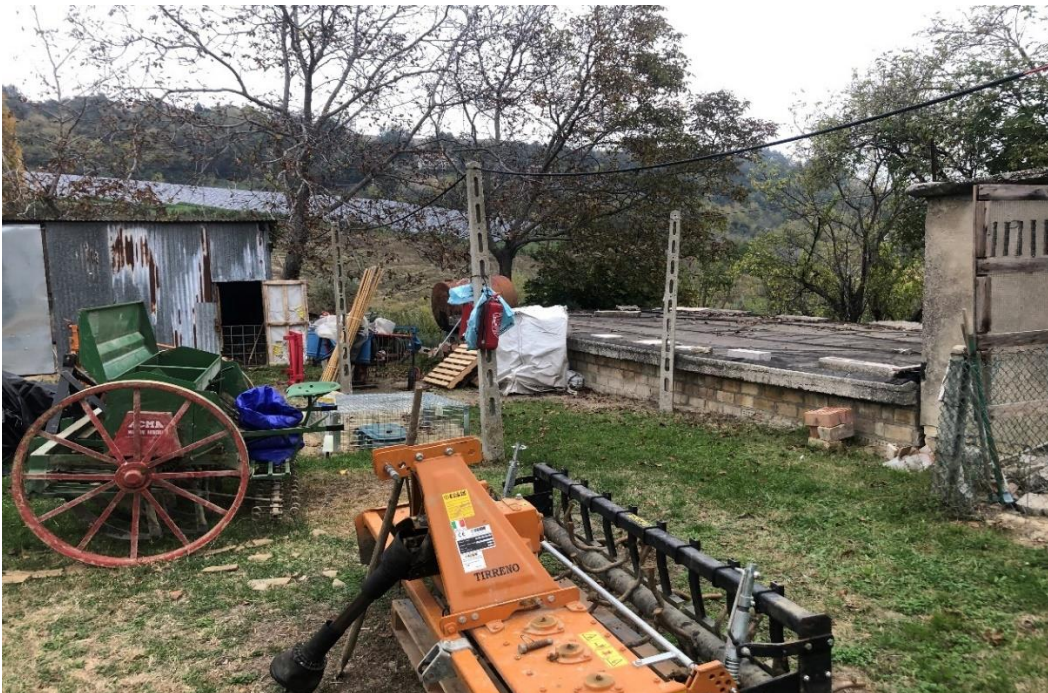
FOTO- 3-LOTTO 1: ESTERNO DEL L'EDIFICIO "MAGAZZINO"
