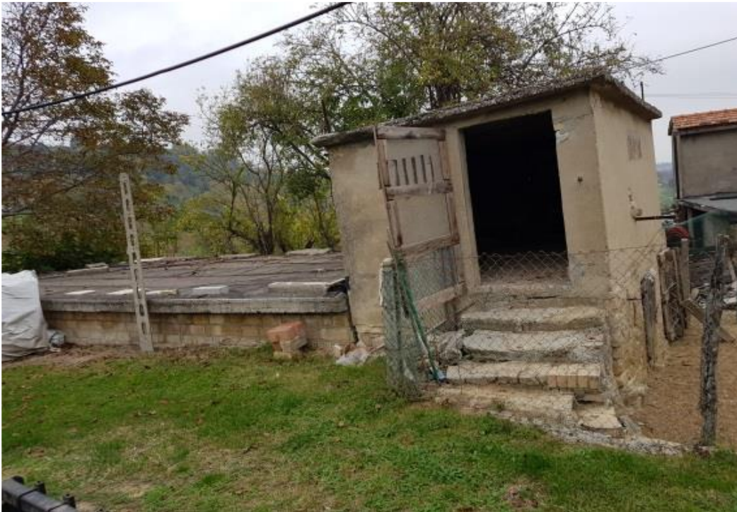
FOTO- 2-LOTTO 1: ESTERNO DEL L'EDIFICIO "RIMESSA"
