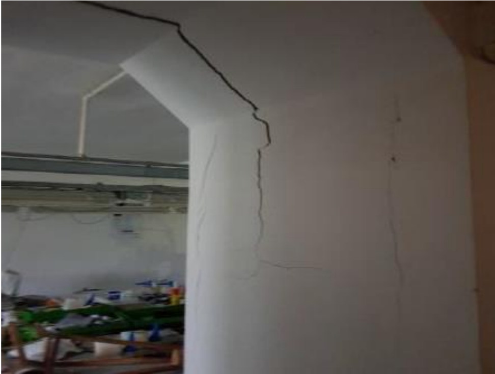
FOTO -4-LOTTO 1: INTERNO DEL LABORATORIO
