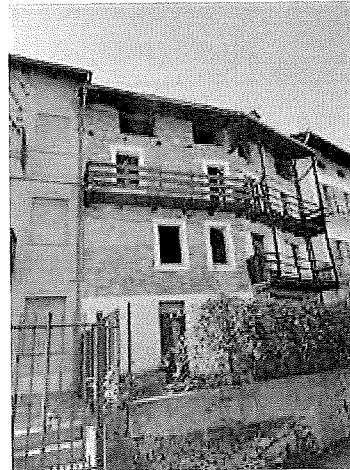
vista da via Pilasco
