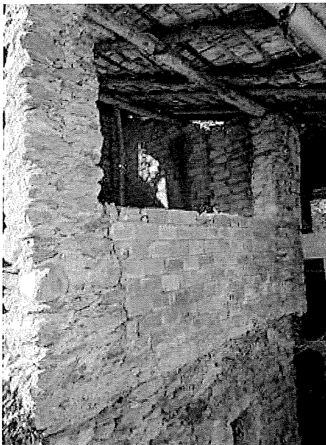
vista esterna lato EST mappale 516
