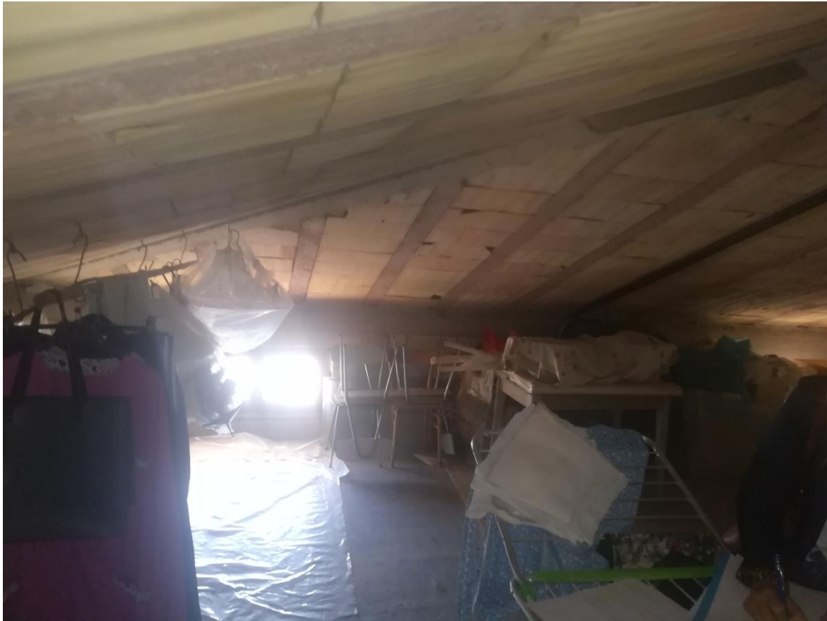
Sub. 21 - PIANO TERZO SOTTOTETTO : PORZIONE DI SOFFITTA
