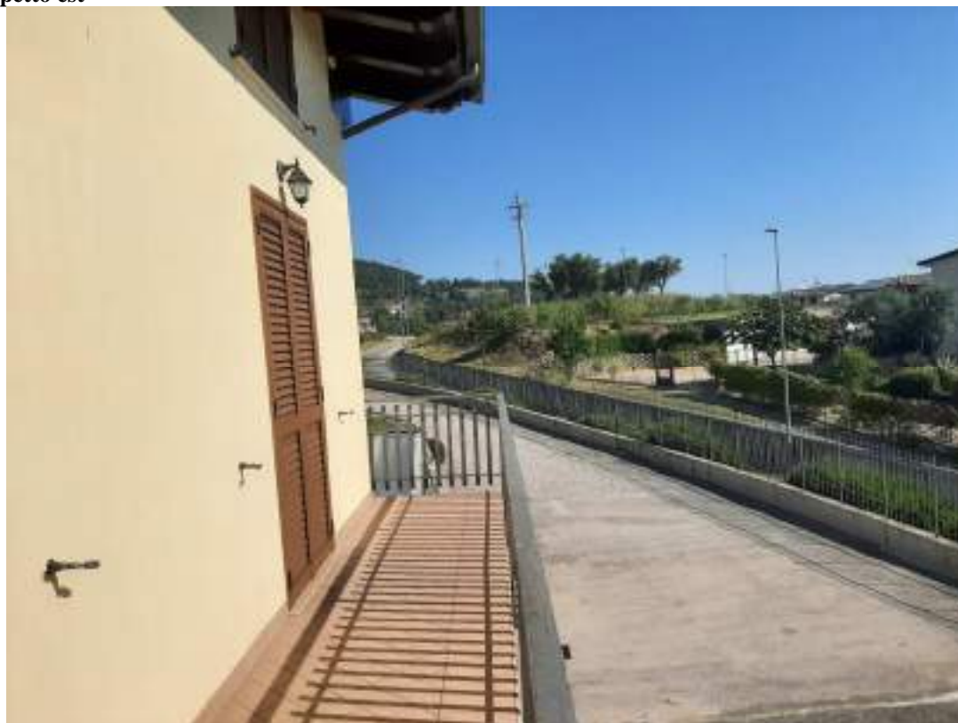
Foto n. 24. Vista esterno unità immobiliare B, C, D (Lotto n. 1), Comune di Perugia, Foglio n. 174, Part. n. 122 Sub 6: Terrazzo appartamento catastalmente individuato al piano terra e primo e vista di parte della corte (Sub 4) al piano terra. È visibile la recinzione della corte realizzata in parte mediante muretto in c.a. e sovrastante ringhiera in metallo. Prospetto est
