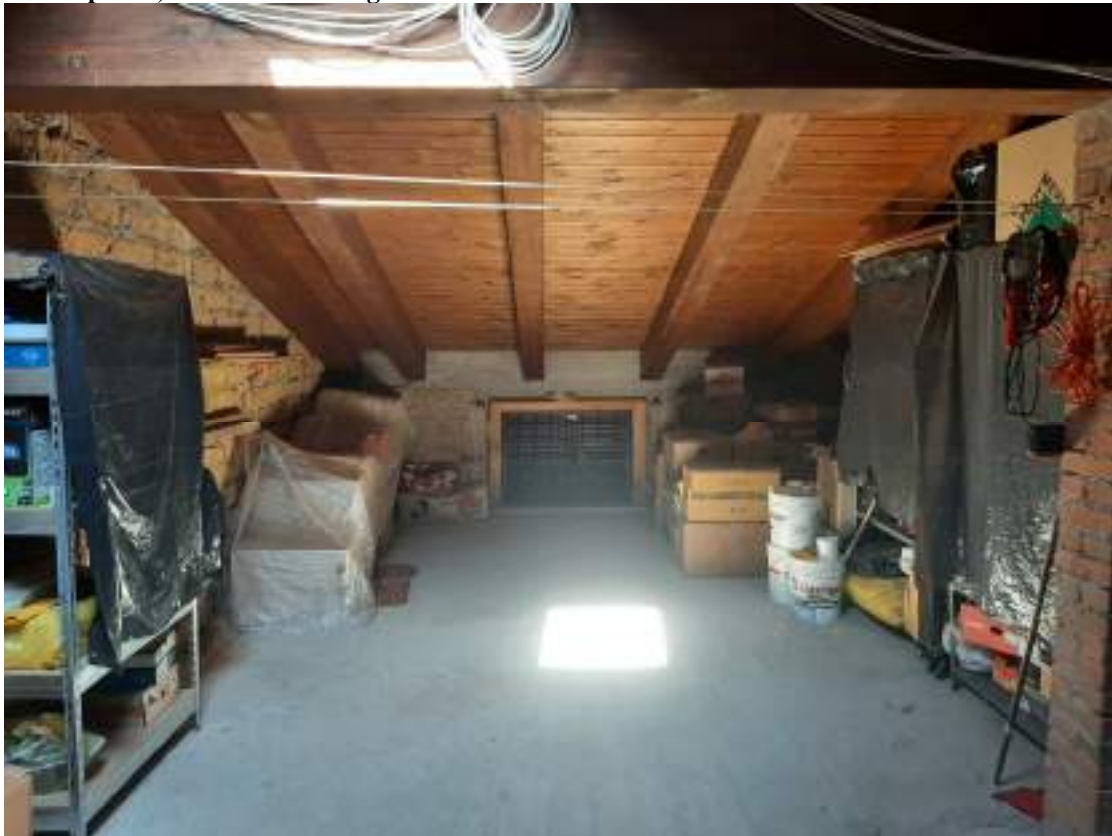
Foto n. 23. Vista interno unità immobiliare B (Lotto n. 1), Comune di Perugia, Foglio n. 174, Part. n. 122 Sub 6, (piano: T-1). Piano primo, soffitta allo stato grezzo
