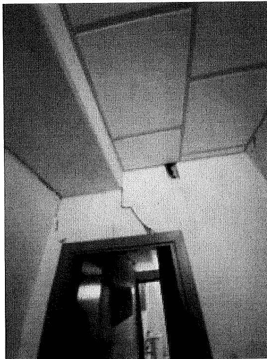
Fessurazioni nell'interfaccia tra i travi e l'appoggio sui pilastri.
