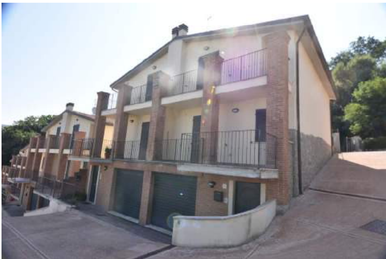
FOTO PROSPETTO FRONTALE ACCESSO PIANO 1° SOTTOSTRADA
