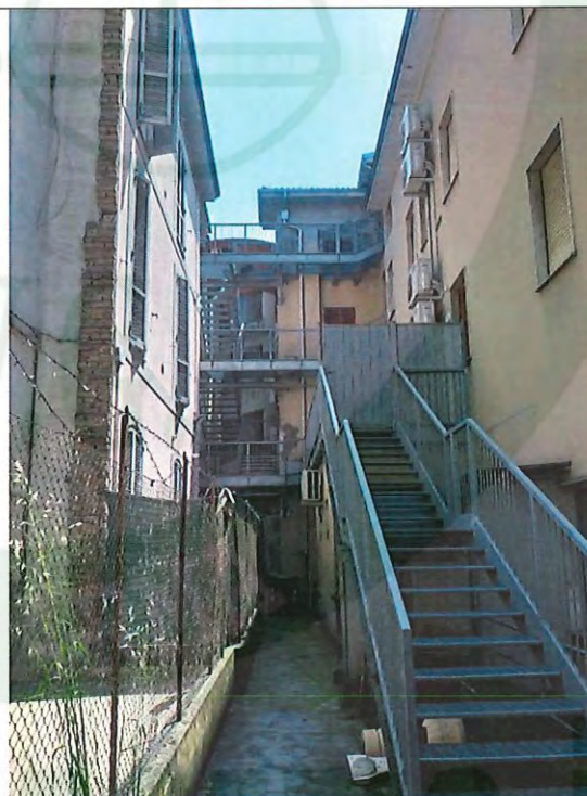
Vista scala antincendio
