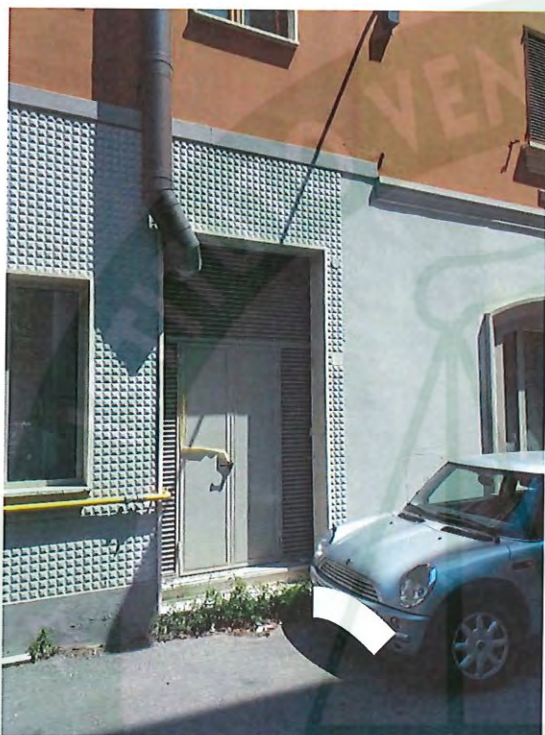
Vista locale tecnico accessibile da Via Riva
