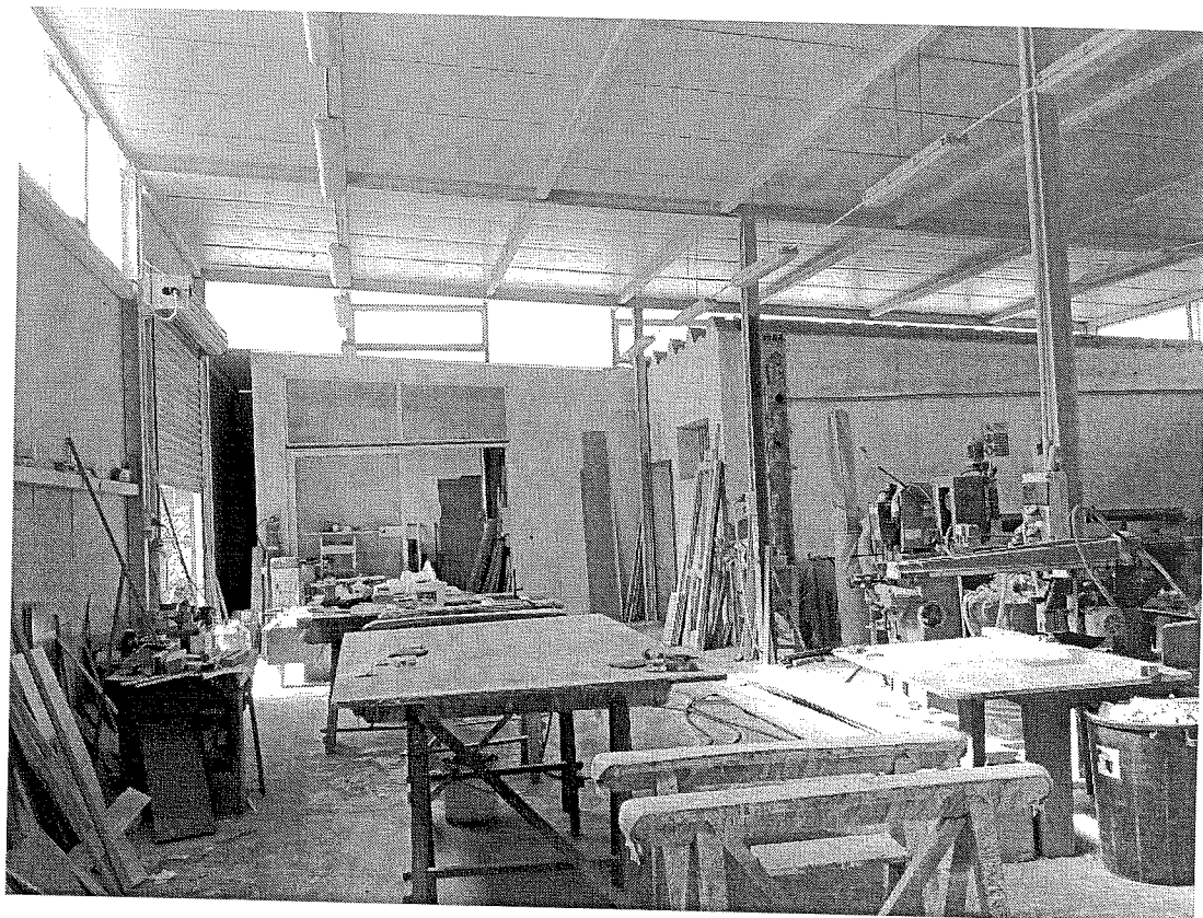
INTERNO ZONA LAVORAZIONE
