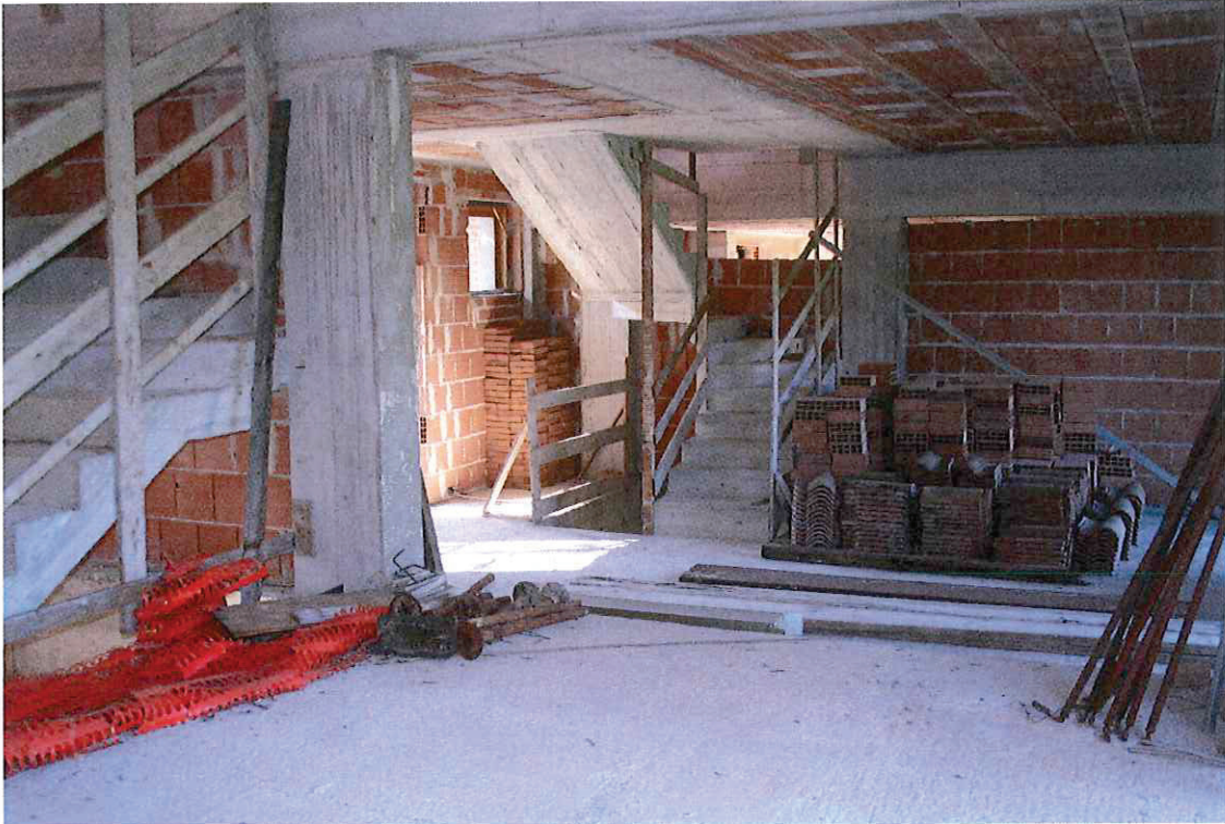
FOTO N° 9 Foto interna – Piano Primo
