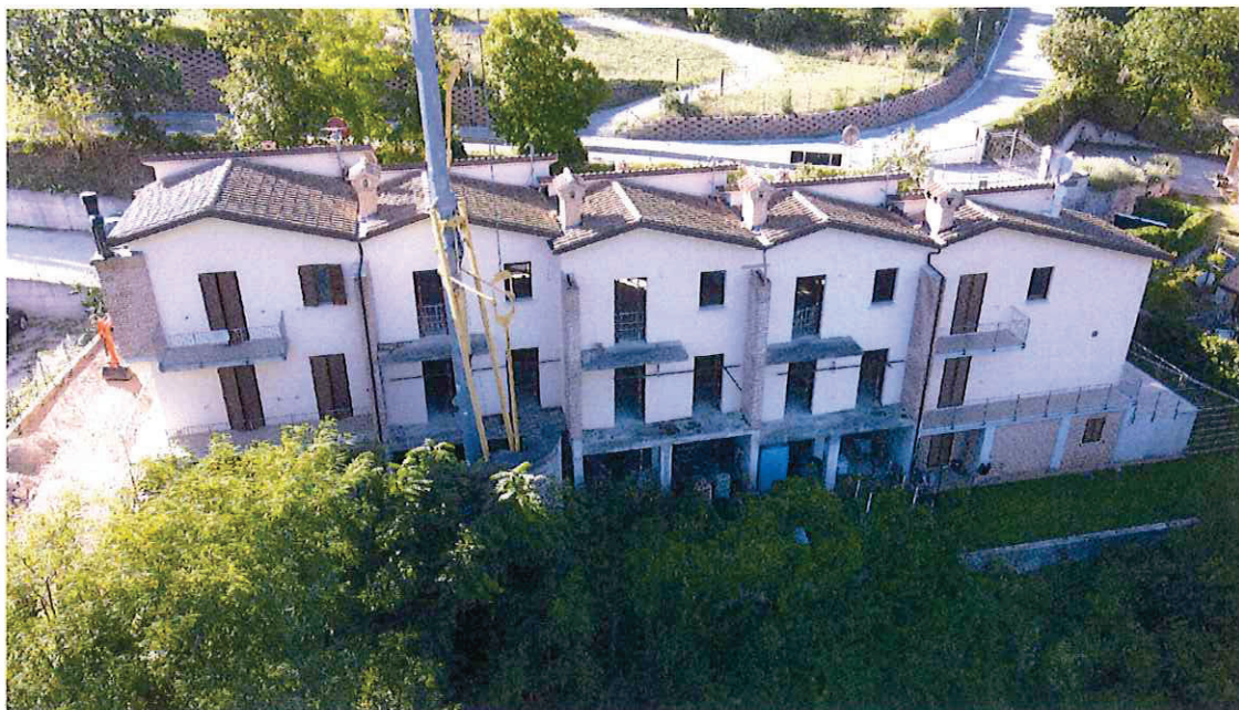
FOTO N° 1 Vista esterna – Lato Nord
