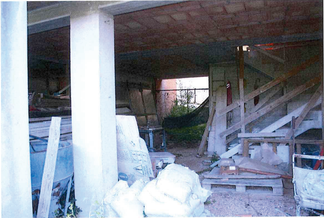
FOTO N° 7 Vista Interna - Piano Terra
