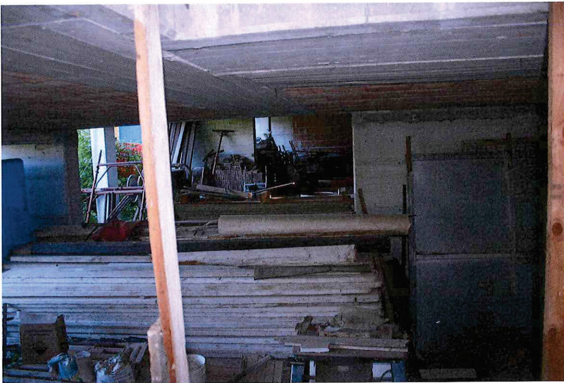
FOTO N° 8 Vista interna – Piano Terra
