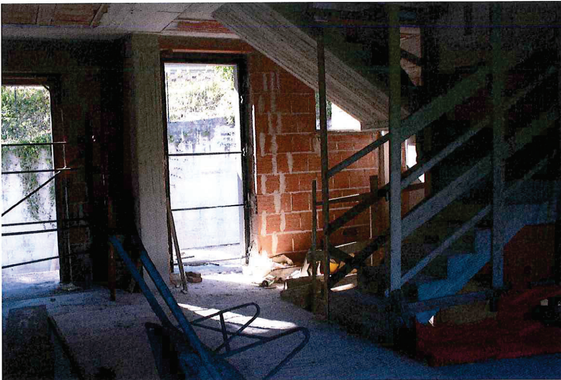
FOTO N° 10 Foto interna – Piano Primo
