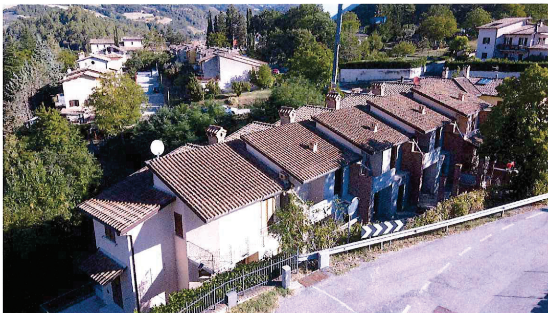
FOTO N° 2 Vista esterna – Lato Sud
