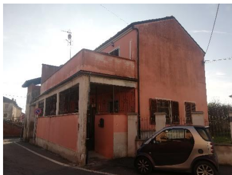
Particolare fronte nord-est – Via Roma n. 5
