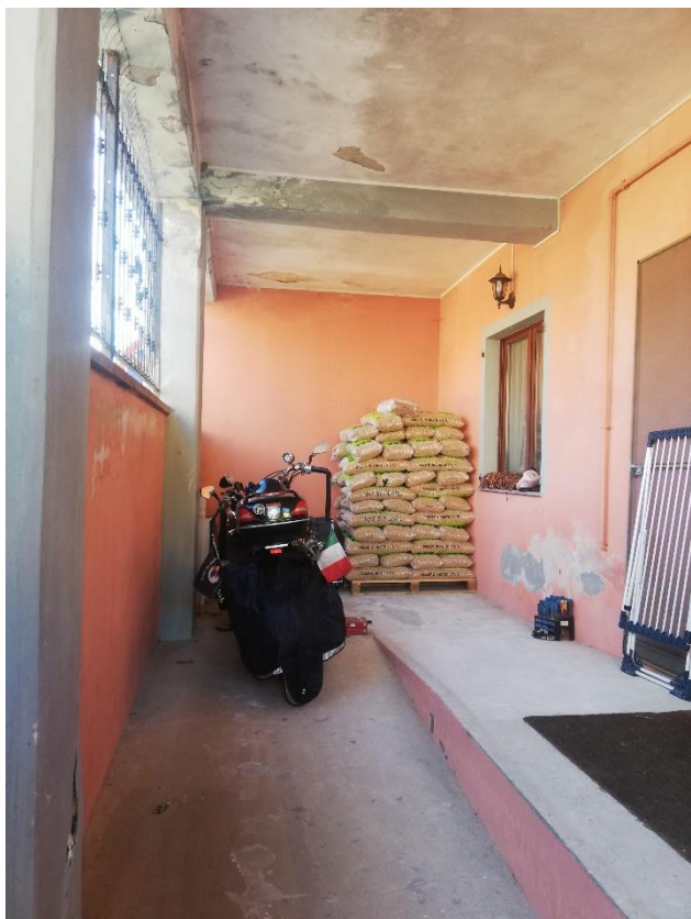
Ripresa fotografica n. 05 Particolare portico-rampa accesso
