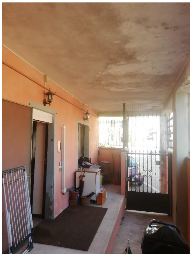
Ripresa fotografica n. 04 Particolare ingresso pedonale esclusivo
