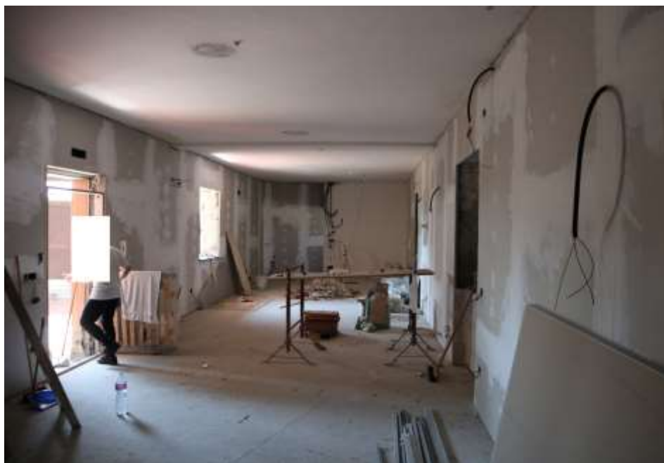
PORZIONE AL PIANO TERRA OVE ERANO IN CORSO LAVORI DI MANUTENZIONE
