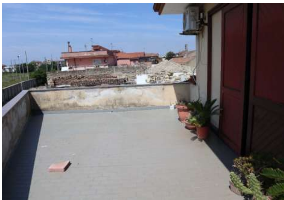
BALCONE AL PRIMO PIANO
