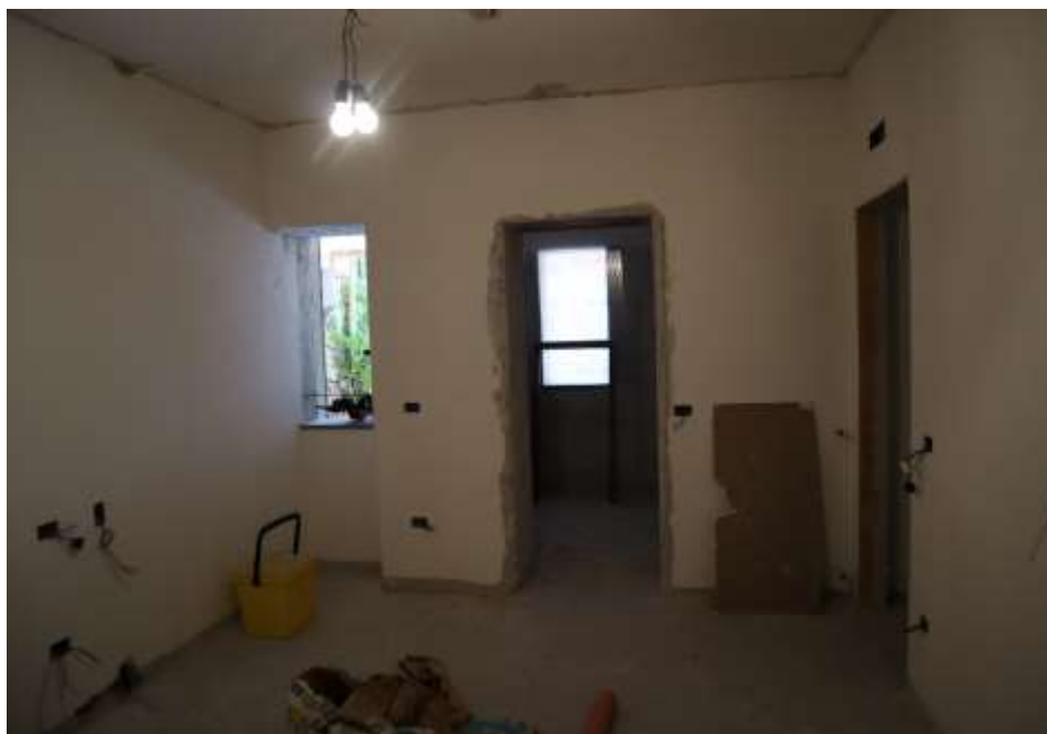
VANO AL PIANO TERRA
