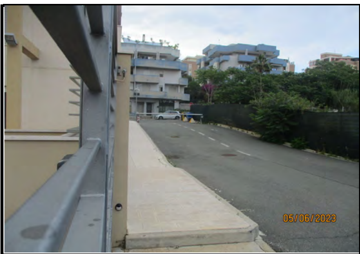
Foto n°7 - Lotti da n°1 a n°140 Esterni
