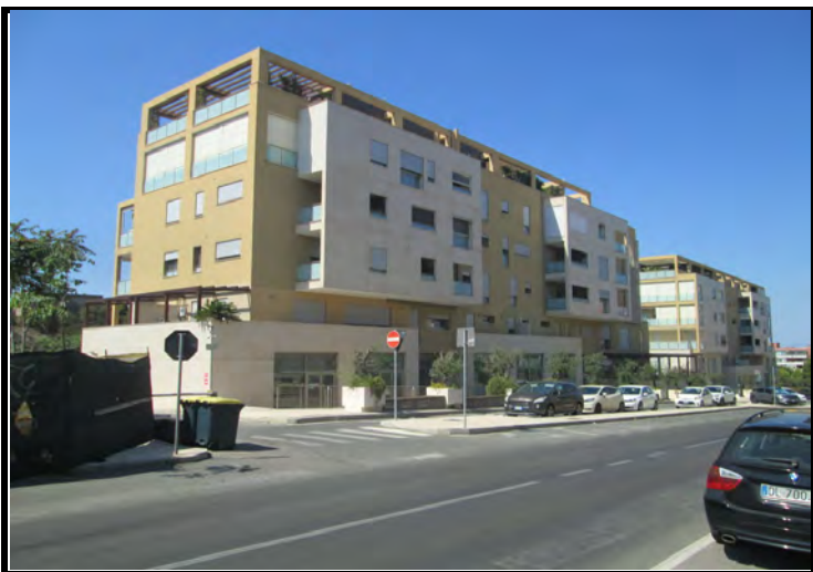
Foto n°1 - Lotti da n°1 a n°140 Esterni
