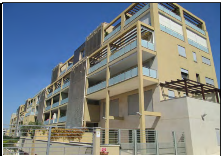
Foto n°3 - Lotti da n°1 a n°140 Esterni
