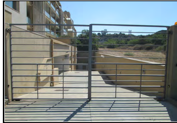
Foto n°10 - Lotti da n°1 a n°140 Esterni
