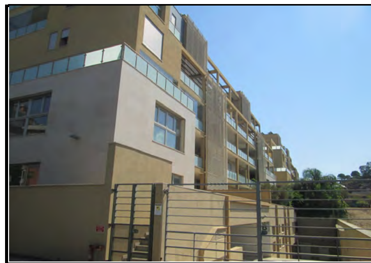
Foto n°4 - Lotti da n°1 a n°140 Esterni
