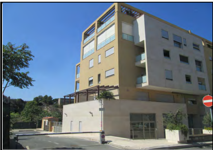
Foto n°5 - Lotti da n°1 a n°140 Esterni
