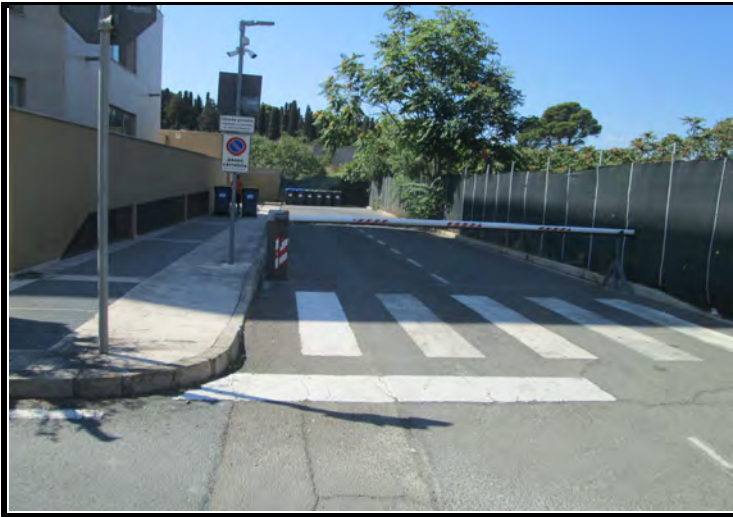
Foto n°9 - Lotti da n°1 a n°140 Esterni
