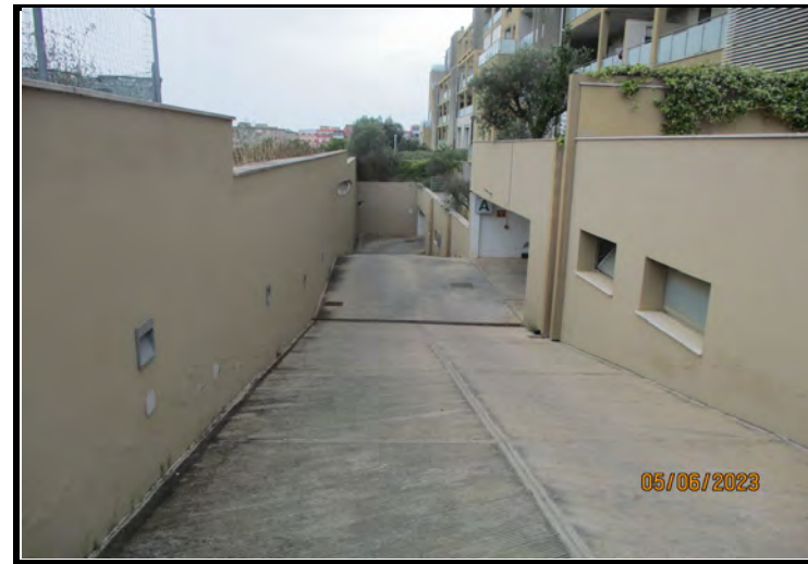
Foto n°12 - Lotti da n°1 a n°140 Esterni
