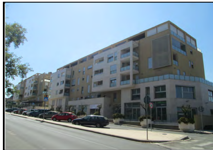
Foto n°2 - Lotti da n°1 a n°140 Esterni
