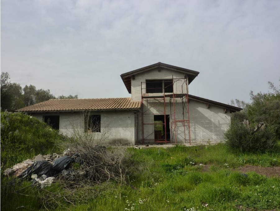
ESTERNO FABBRICATO LATO EST
