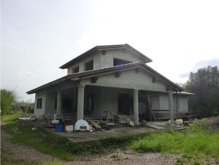
ESTERNO FABBRICATO LATO OVEST
