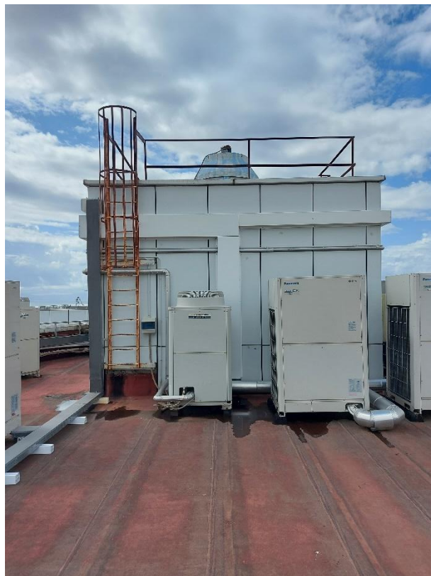
Scala di accesso al lastrico solare bene 4
