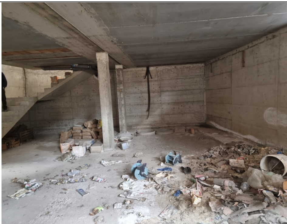
Foto 10 : Vista scala cantina locale commerciale (10/11/23)
