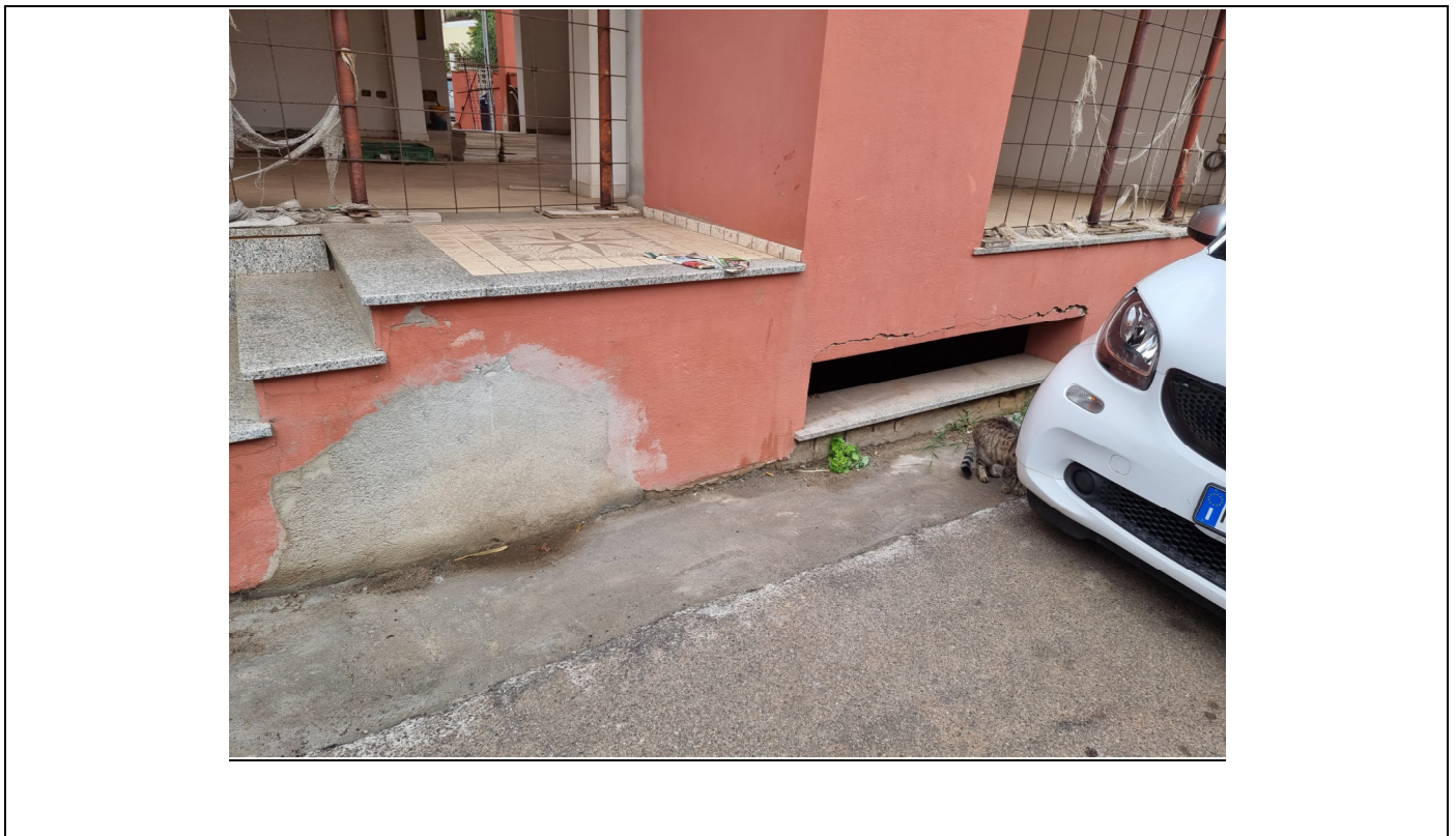
Foto 12 : Vista ingresso lato Via Olbia Capoterra (10/11/23)
