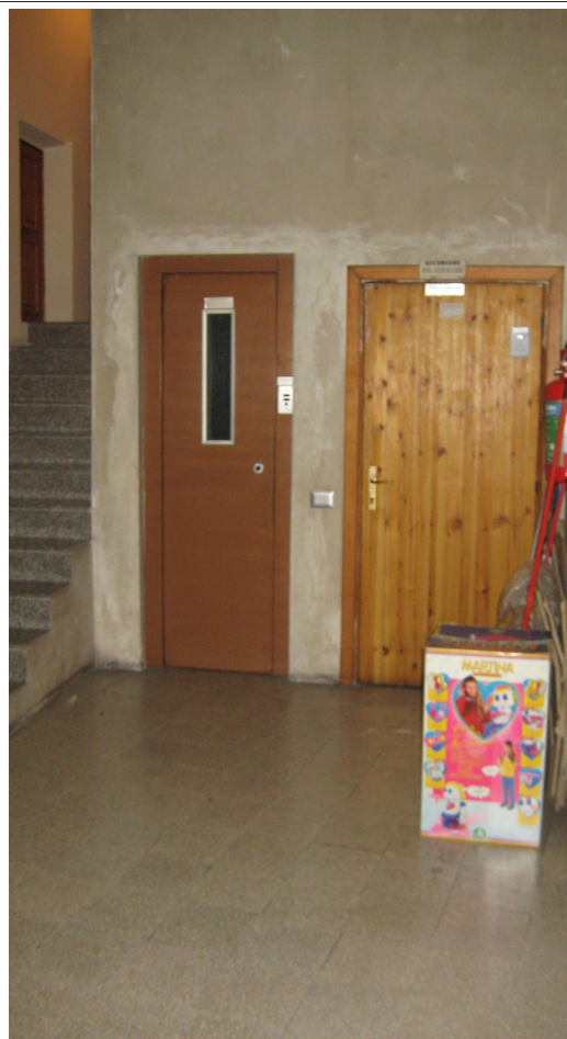
Scala e ascensore interno
