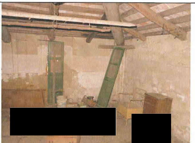
Foto n°248: Interni del sub 2 al P.1° fronte strada.
