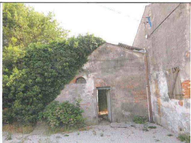
Foto n°217: Fronte nord est
