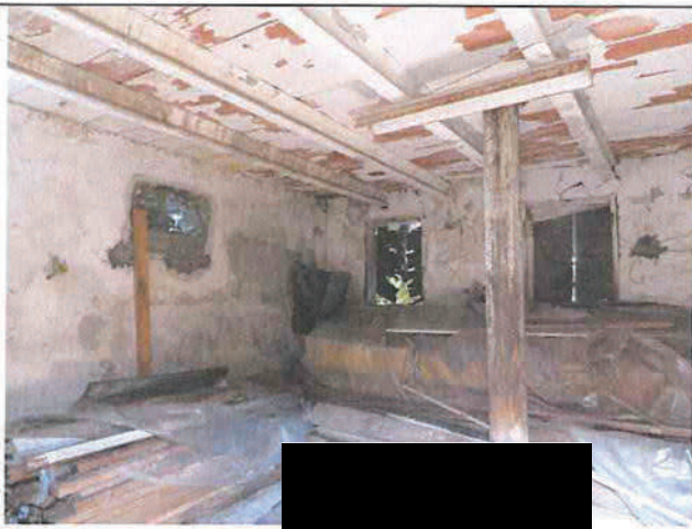
Foto n°239: Interni del sub 2 al P.T.
