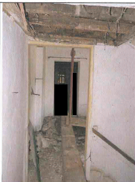
Foto n°246: Interni del sub 2 al P.1° fronte strada.
