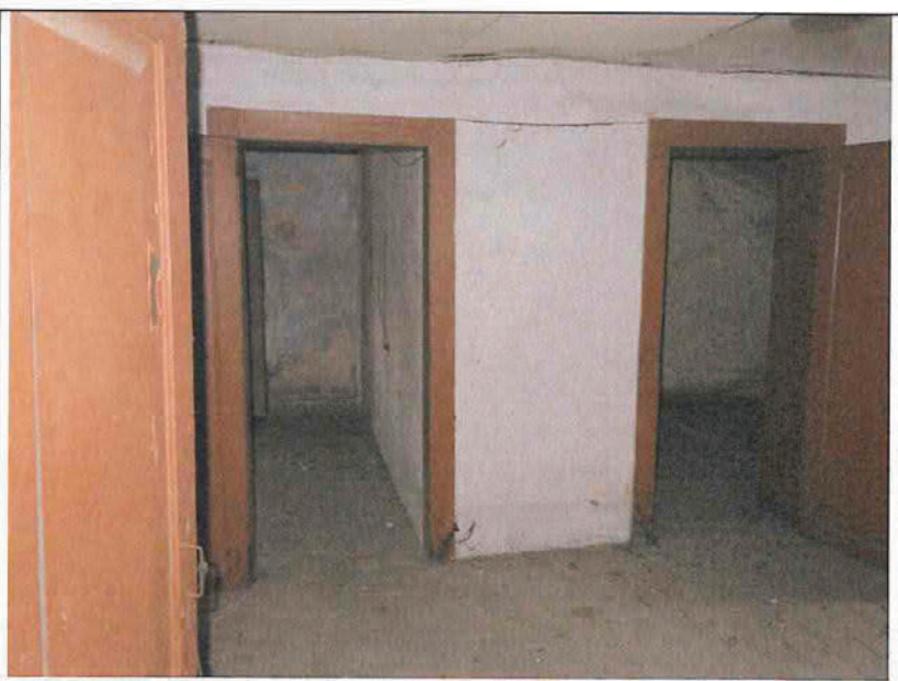
Foto n°242: Interni del sub 2 al P.1° fronte strada.
