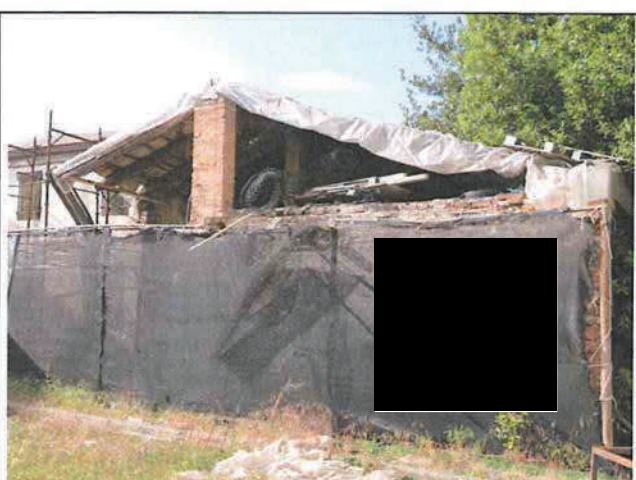
Foto n°216: Fronte sud parzialmente demolito
