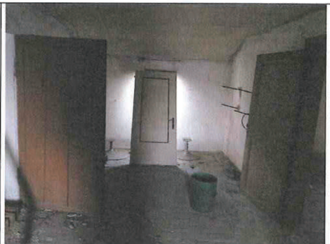
Foto n°244: Interni del sub 2 al P.1° fronte strada.
