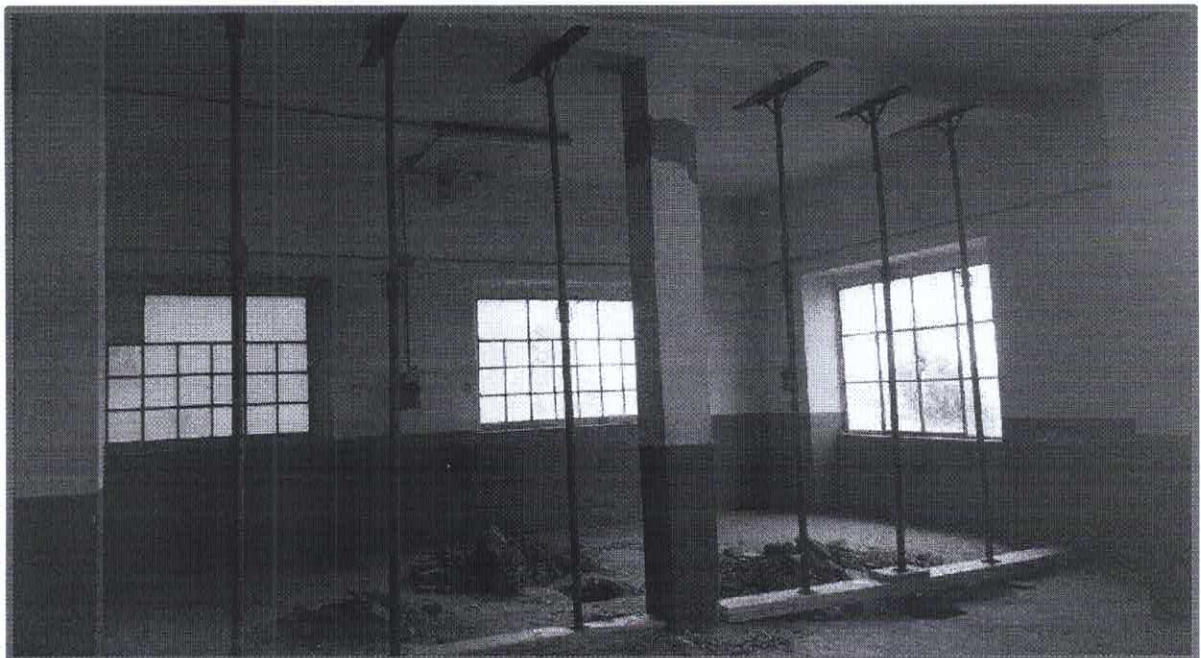
Intervento di puntellatura provvisoria della trave
