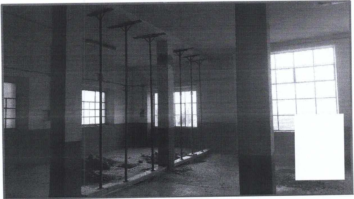
Intervento di puntellatura provvisoria della trave
