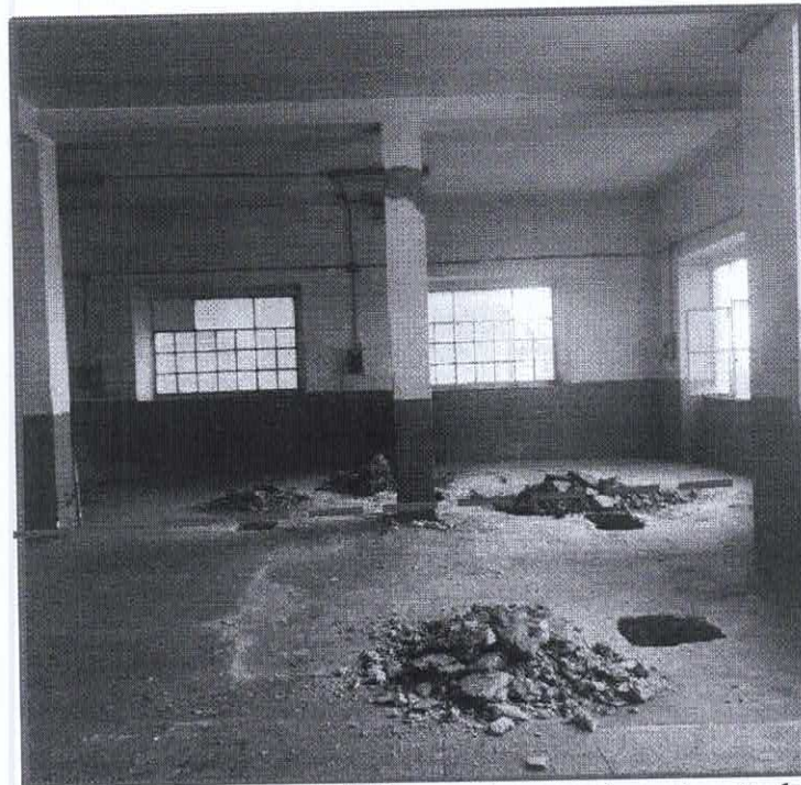
Foto con evidenza della posizione della trave trasversale posta sotto la pilastrata.
