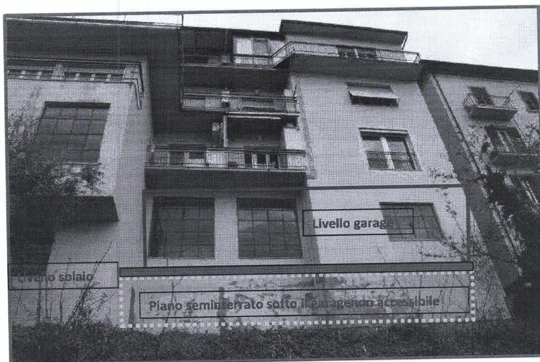
Vista dell'immobile dalla strada sottostante
