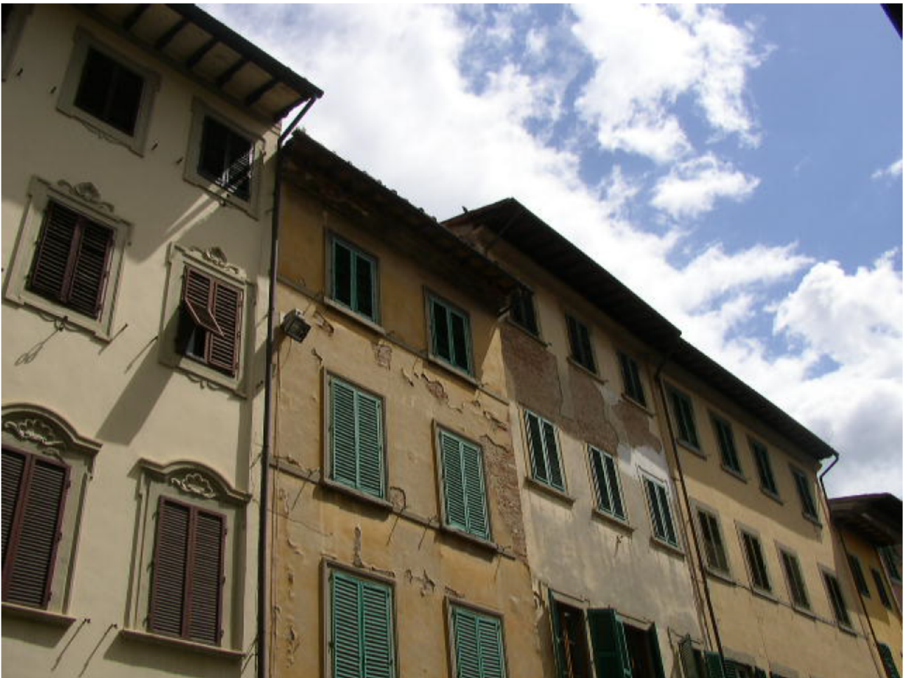
Particolare facciata fabbricato
