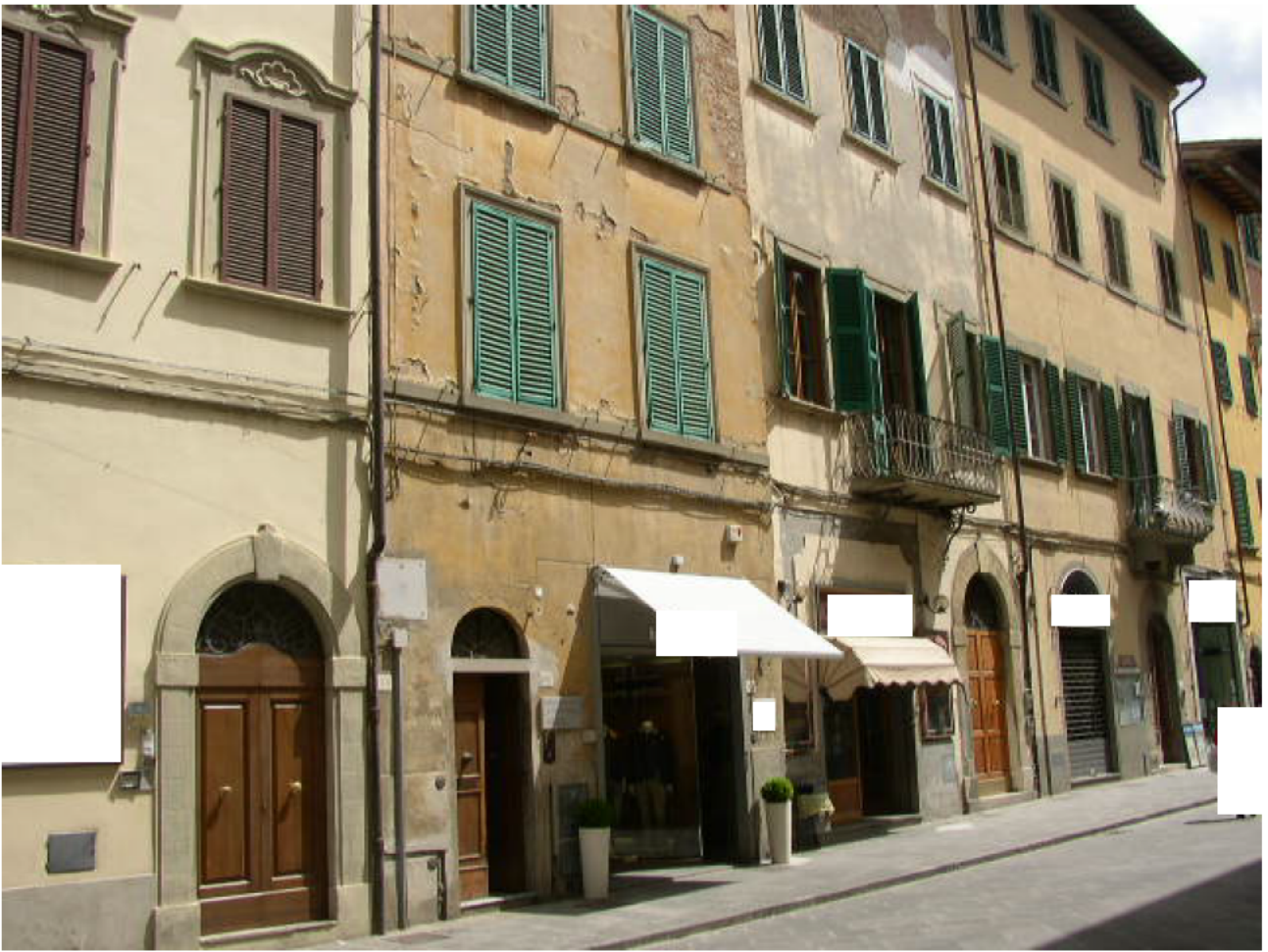
Particolare facciata fabbricato
