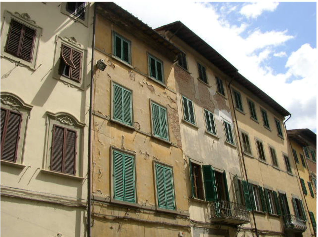
Particolare facciata fabbricato
