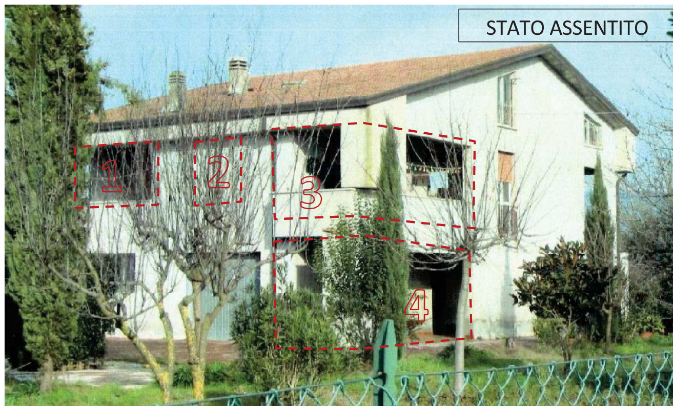
Foto 1 e 2 – Abusi prospetti SUD – EST: 1) Chiusura terrazzo e apertura nuova finestra; 2) Nuova apertura; 3) Chiusura terrazzo e apertura nuova finestra; 4) Chiusura portico, cambiamento di destinazione d'uso, apertura nuove luci.
