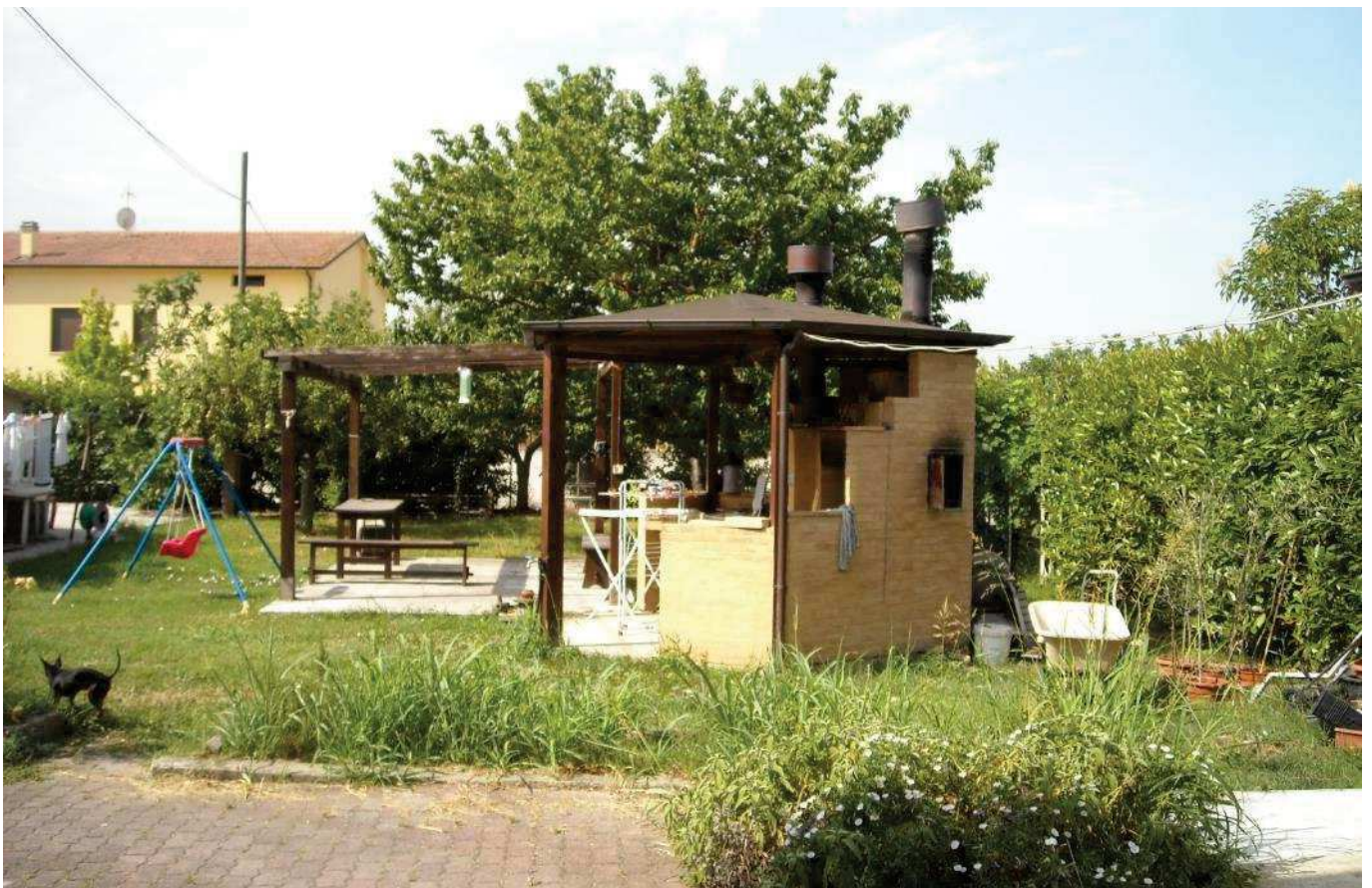
Foto 10 – Pergola con forno in muratura (Nuova costruzione).
