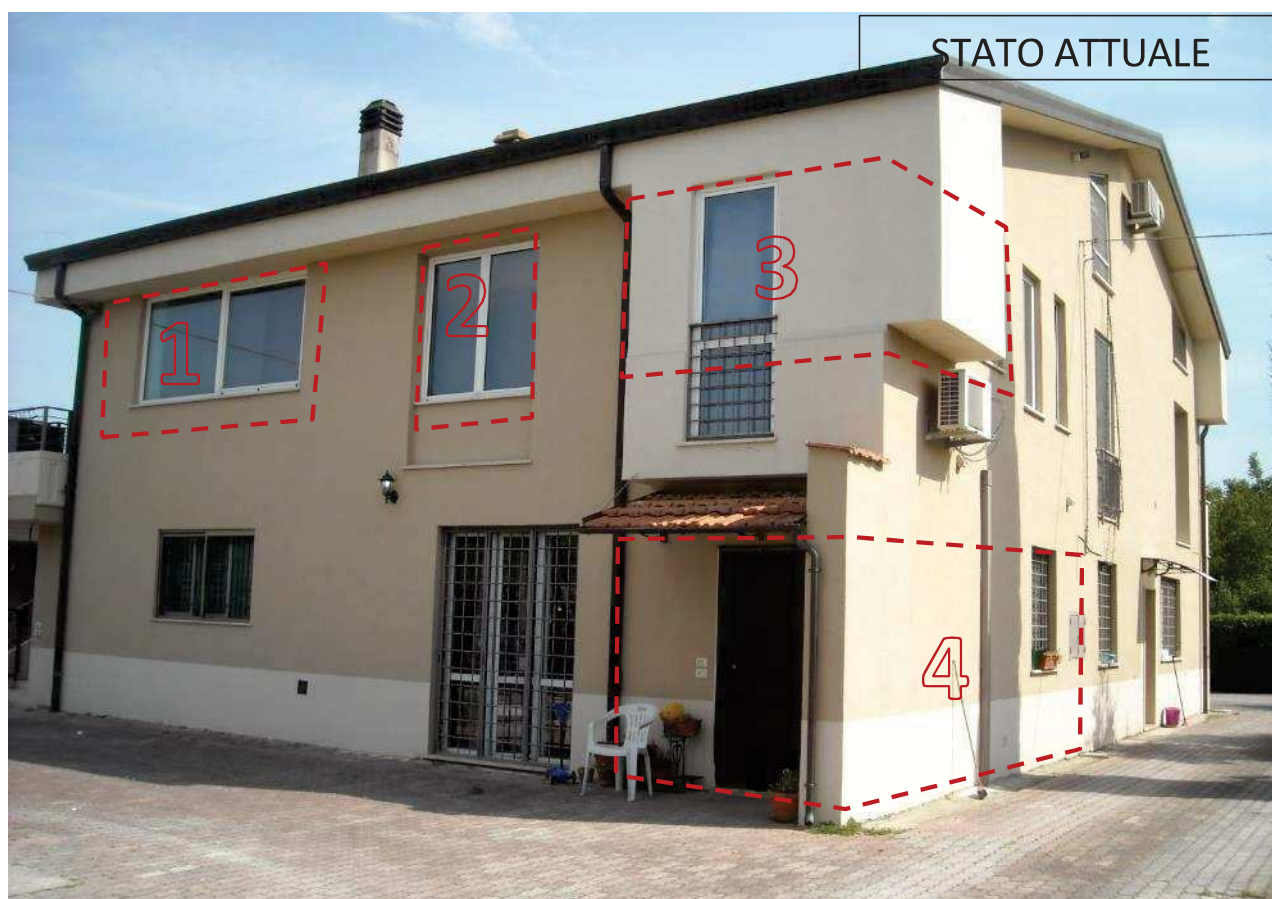
Foto 1 e 2 – Abusi prospetti SUD – EST: 1) Chiusura terrazzo e apertura nuova finestra; 2) Nuova apertura; 3) Chiusura terrazzo e apertura nuova finestra; 4) Chiusura portico, cambiamento di destinazione d'uso, apertura nuove luci.
