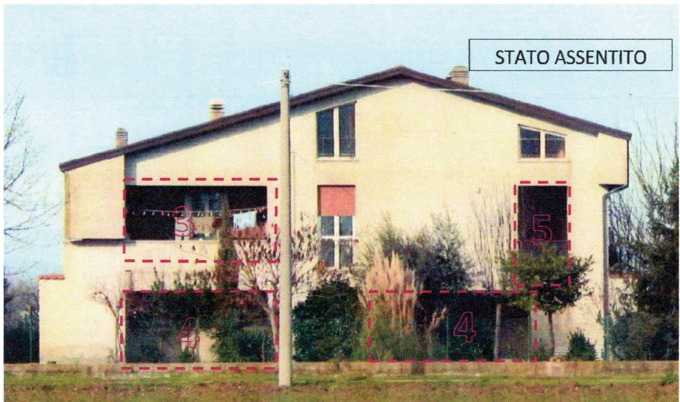
Foto.3 e 4 – Abusi prospetto EST: 3) Chiusura terrazzo e apertura nuova finestra ; 4) Chiusura portico, cambiamento di destinazione d'uso, apertura nuove luci; 5) Chiusura terrazzo e apertura nuova finestra.
