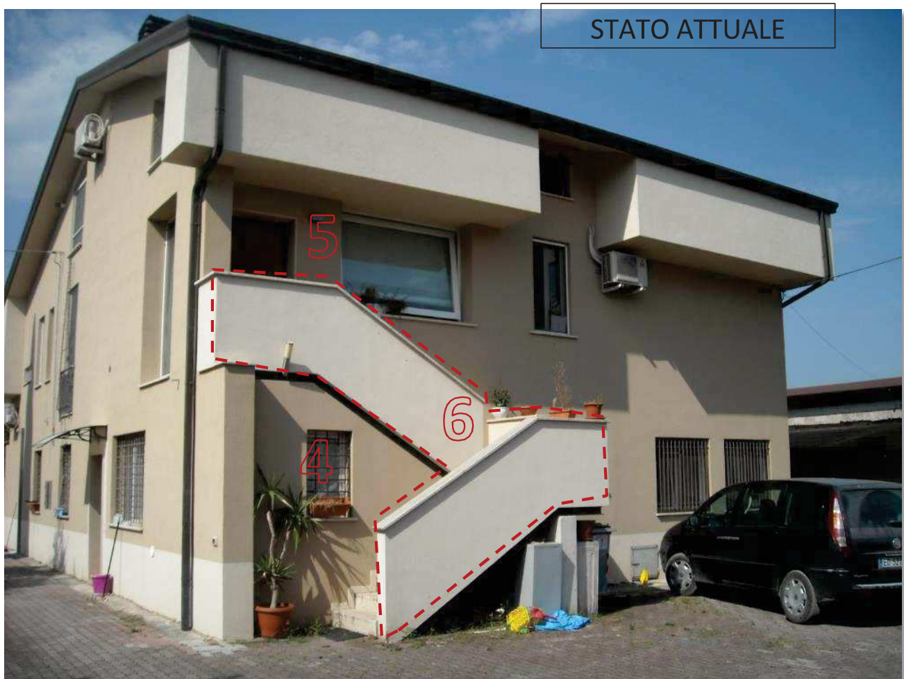
Foto.5 e 6 – Abusi prospetto NORD: 4) Chiusura portico, cambiamento di destinazione d'uso, apertura nuove luci; 5) Chiusura terrazzo e apertura nuova finestra. 6) Realizzazione scala esterna
