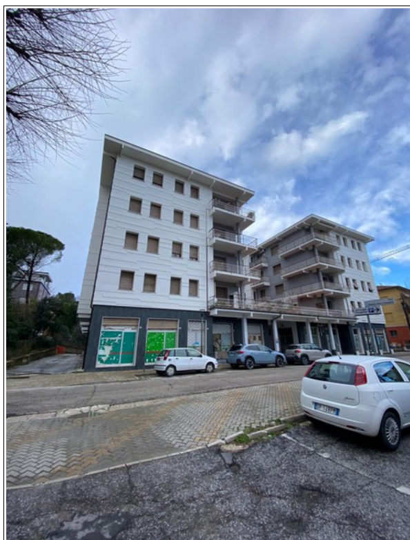
foto n. 2 – panoramica intera palazzina civico 57
