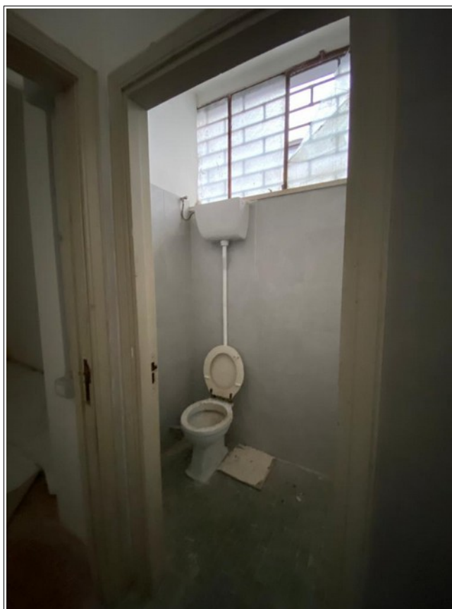
foto n. 13 – locale wc a servizio sub. 1 e 57
