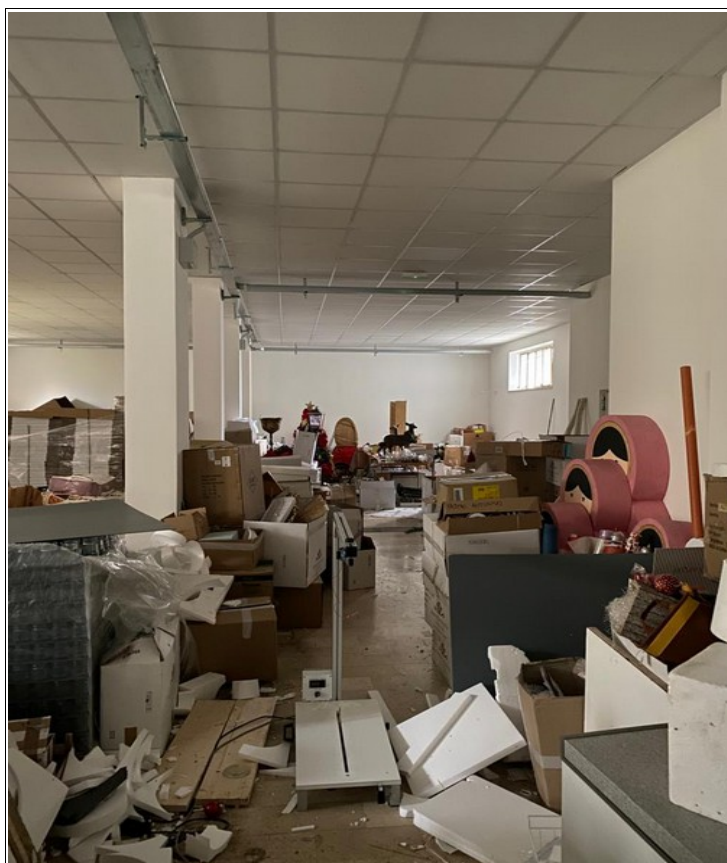
foto n. 7 – sub. 57 lato est
