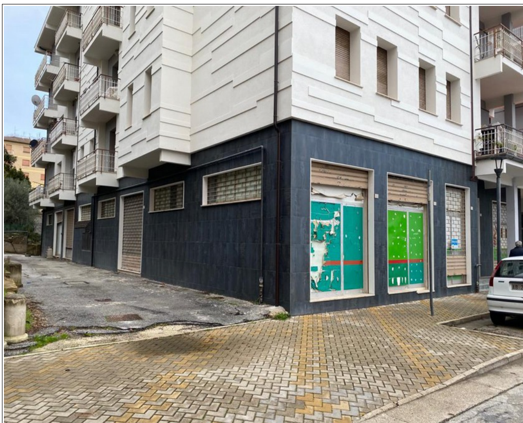
foto n. 3 – uu.ii. al PT in esecuzione
