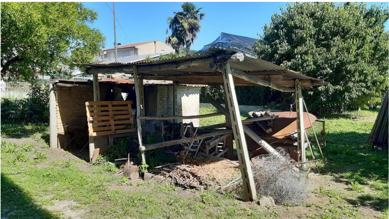
forno e tettoia
