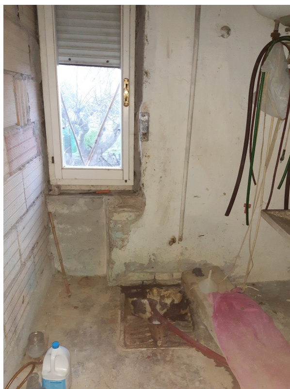
w.c. rimessa sub 4
