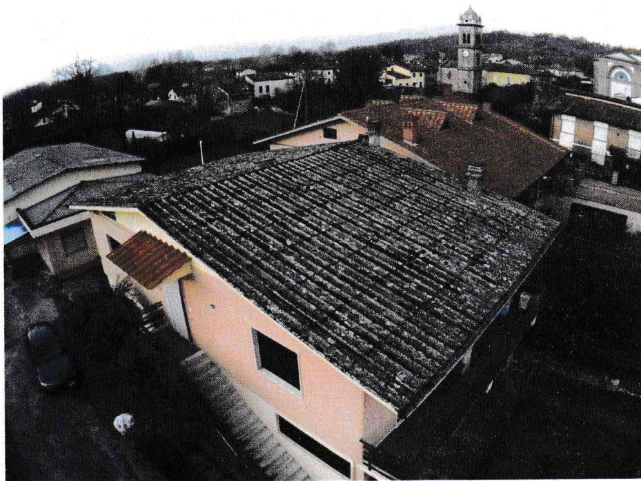
Foto 3 – Vista generale copertura
