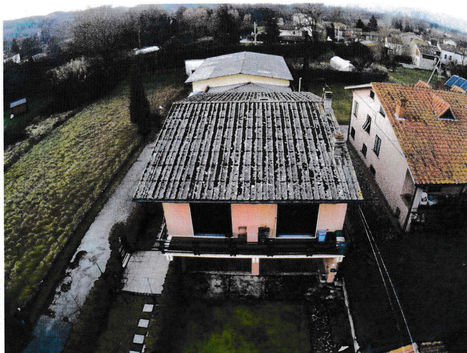
Foto 2 – Vista generale copertura
