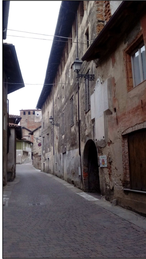
facciata su via
