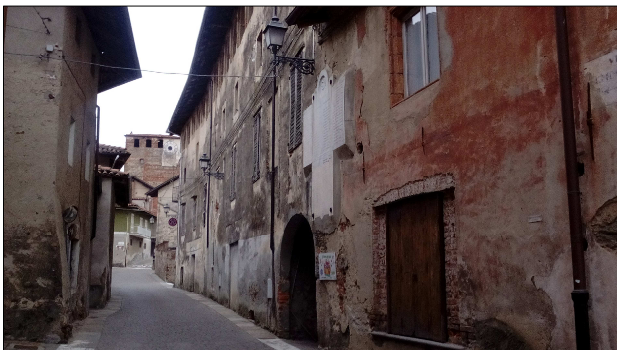
facciata su via
