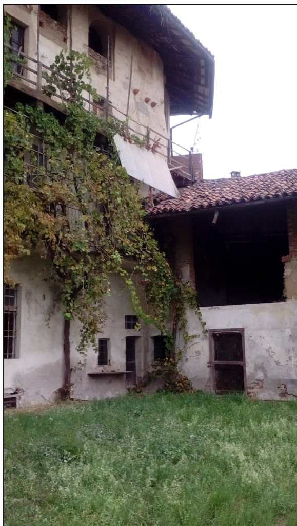
facciata su cortile
