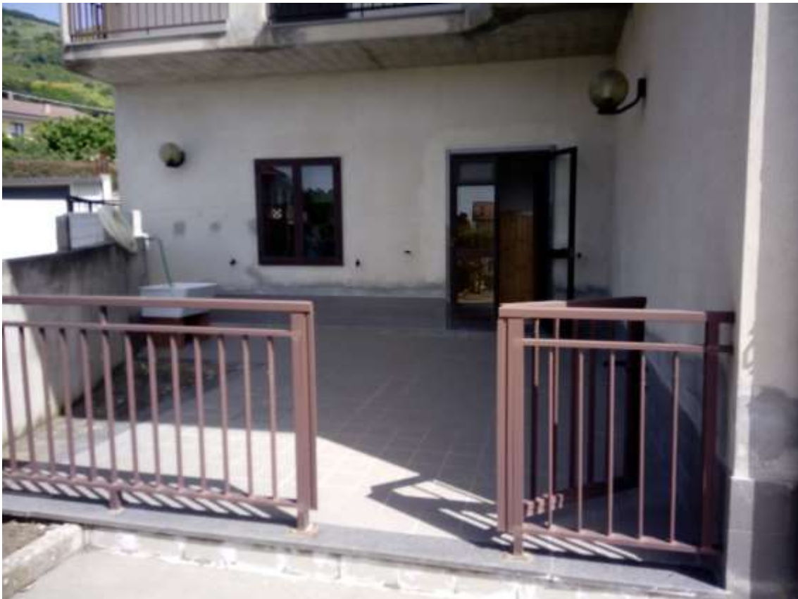
Foto 8) Veduta esterna ingresso Sub 2
