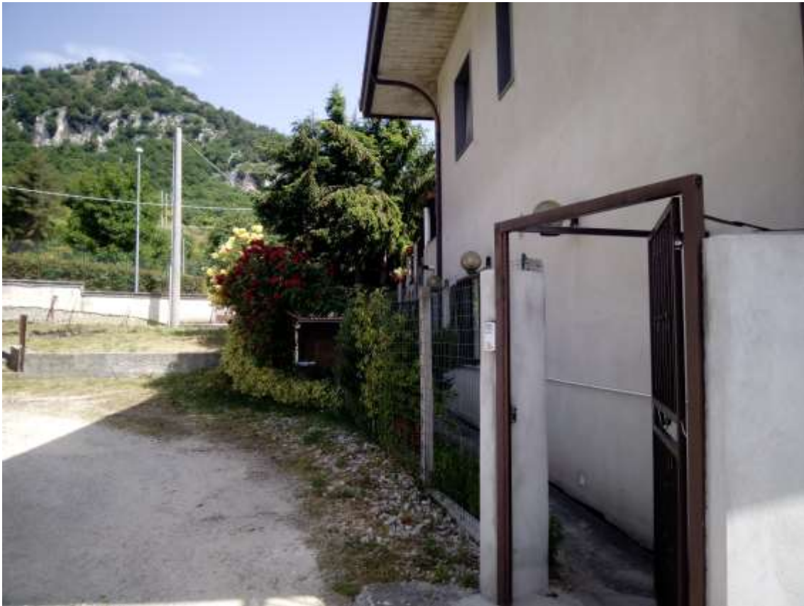
Foto 7) Veduta esterna lato ovest
