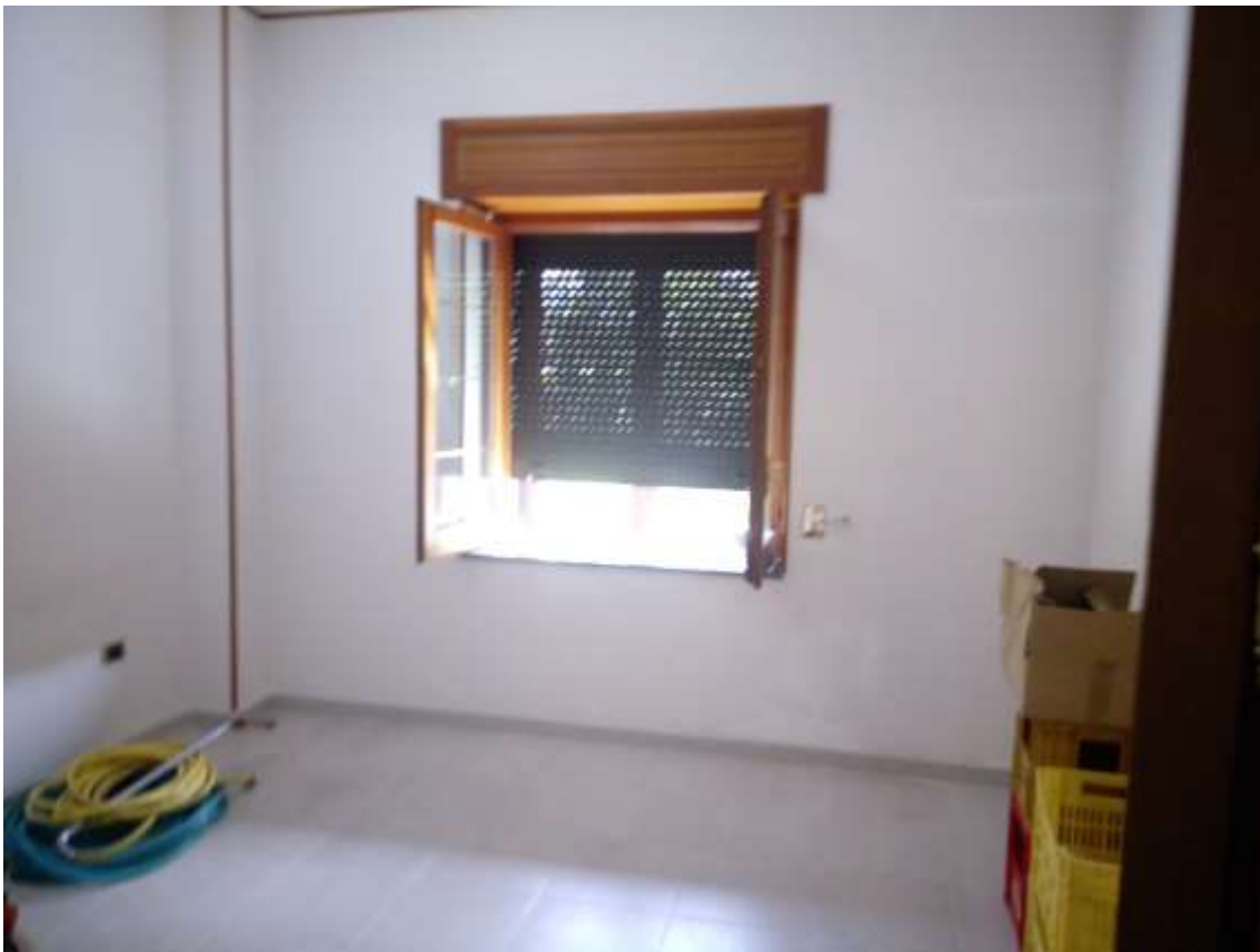
Foto 9) camera piano terra sub 2
