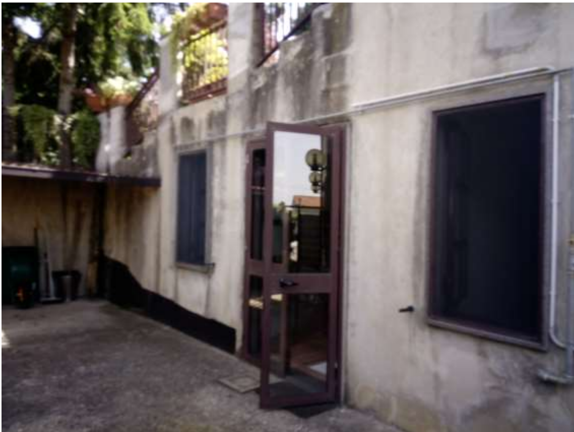
Foto 16) Ingresso Cantina piano terra sub 1
