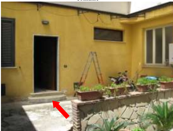
Figura 10 facciata nord/est del fabbricato
