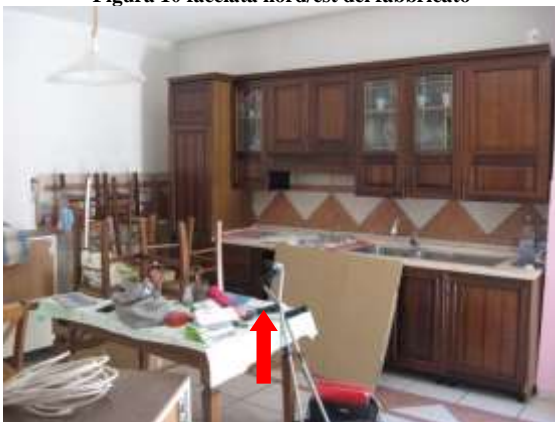
Figura 12 cucina dell'appartamento al piano terra
