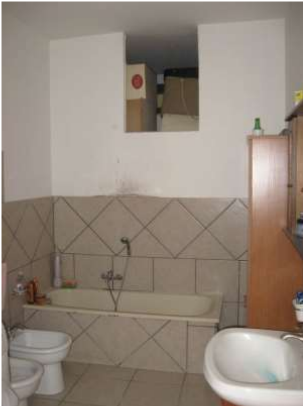
Figura 20 bagno dell'appartamento al piano terra
