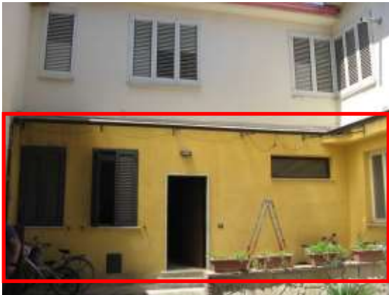
Figura 8 facciata est del fabbricato prospiciente il cortile comune
