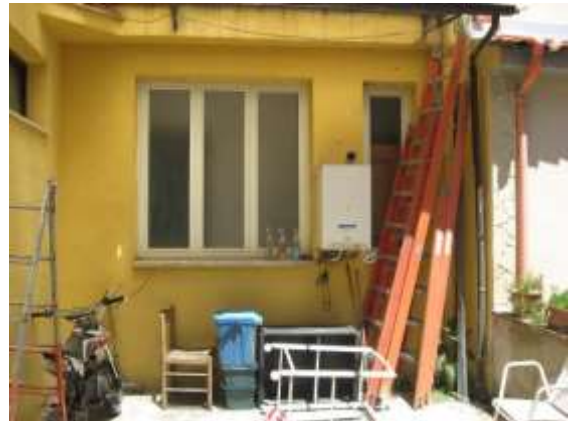
Figura 9 facciata nord del fabbricato prospiciente il cortile comune
