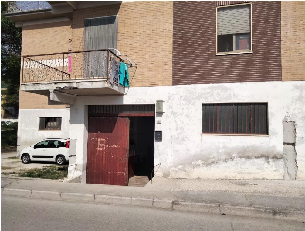
Foto n. 1 –vista esterna palazzina e accesso locale
