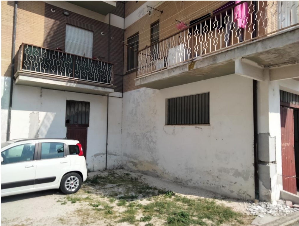
Foto n. 3 –vista esterna palazzina
