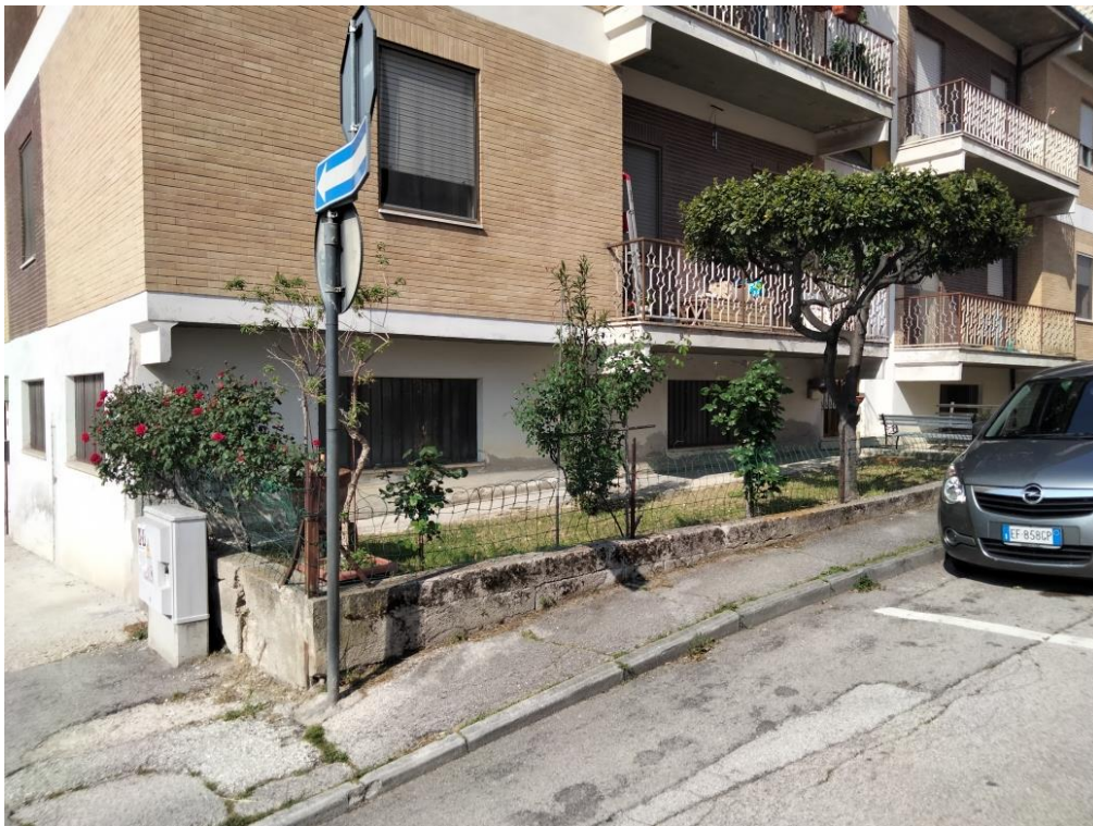
Foto n. 2 –vista esterna palazzina
