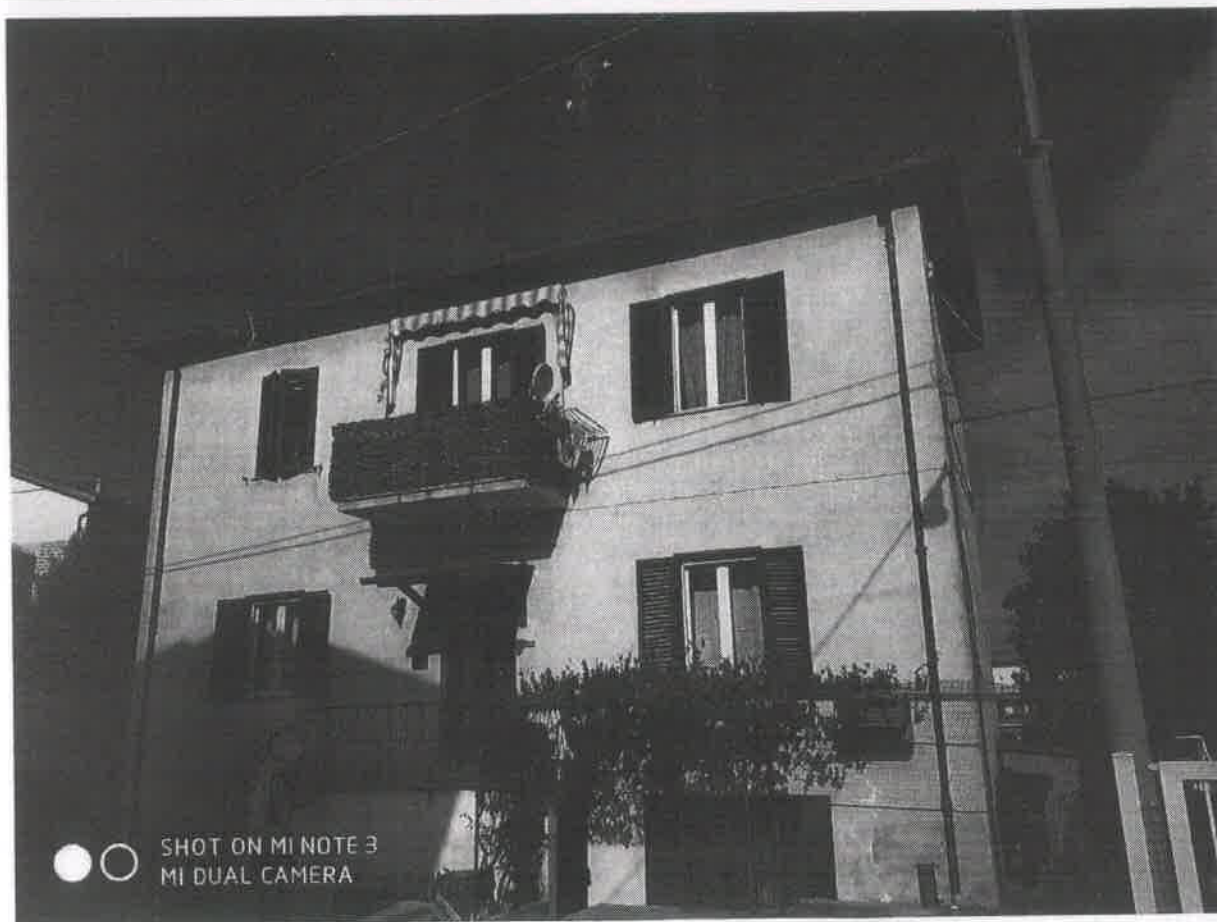
Prospetto lato strada comunale
