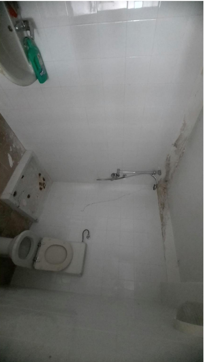
foto 22 - Servizio igienico garage al piano secondo sotto-strada
