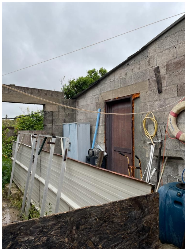
Foto 18_ Vista particolare magazzino
