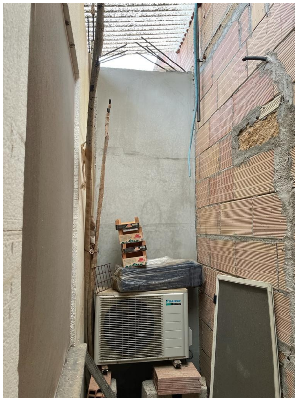
Foto 10_ Vista pozzo luce
