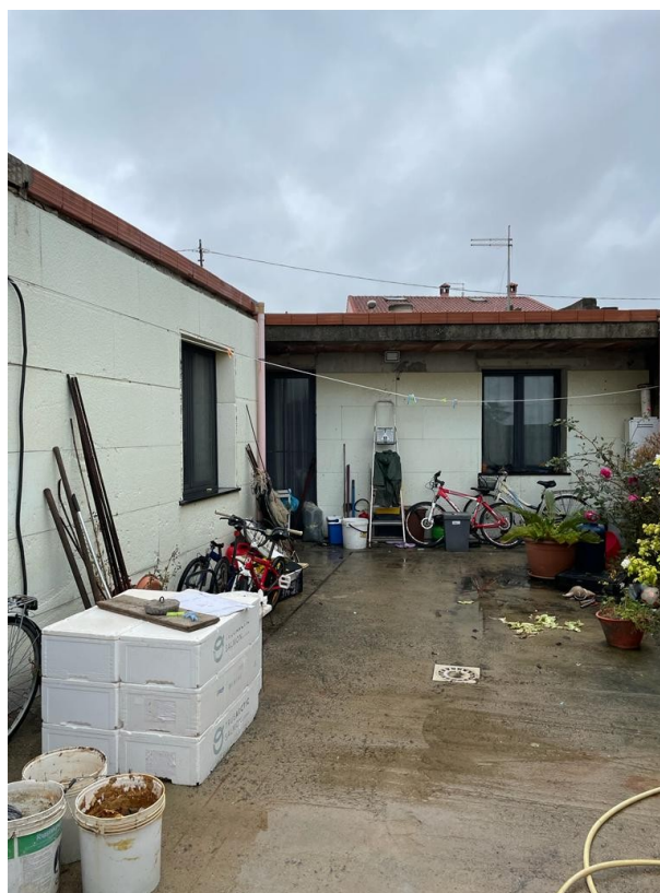
Foto 16_ Prospetto interno da cortile
