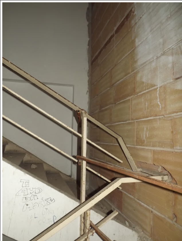
Particolare rampe a salire con muro di interdizione al pianerottolo
