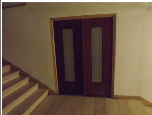
Disimpegno piano ammezzato (Asur)
