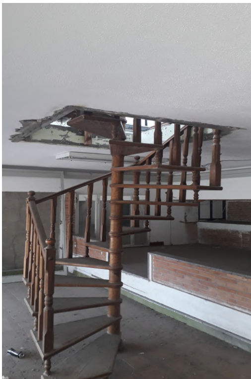
Scala a chiocciola interna accesso sub 188
