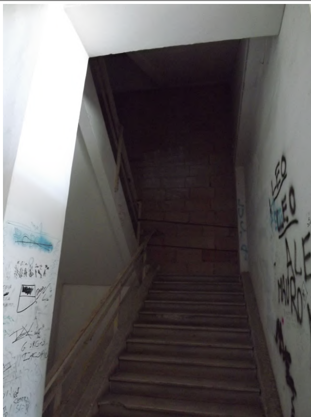
Rampa a salire con muro in laterizio su pianerottolo
