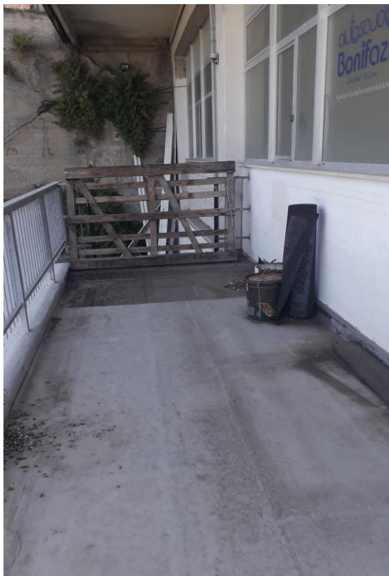
Terrazzo verso scala estera sub 189-190
