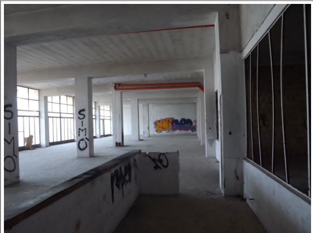
Vista interno sub 88 da area di disimpegno secondo livello est
