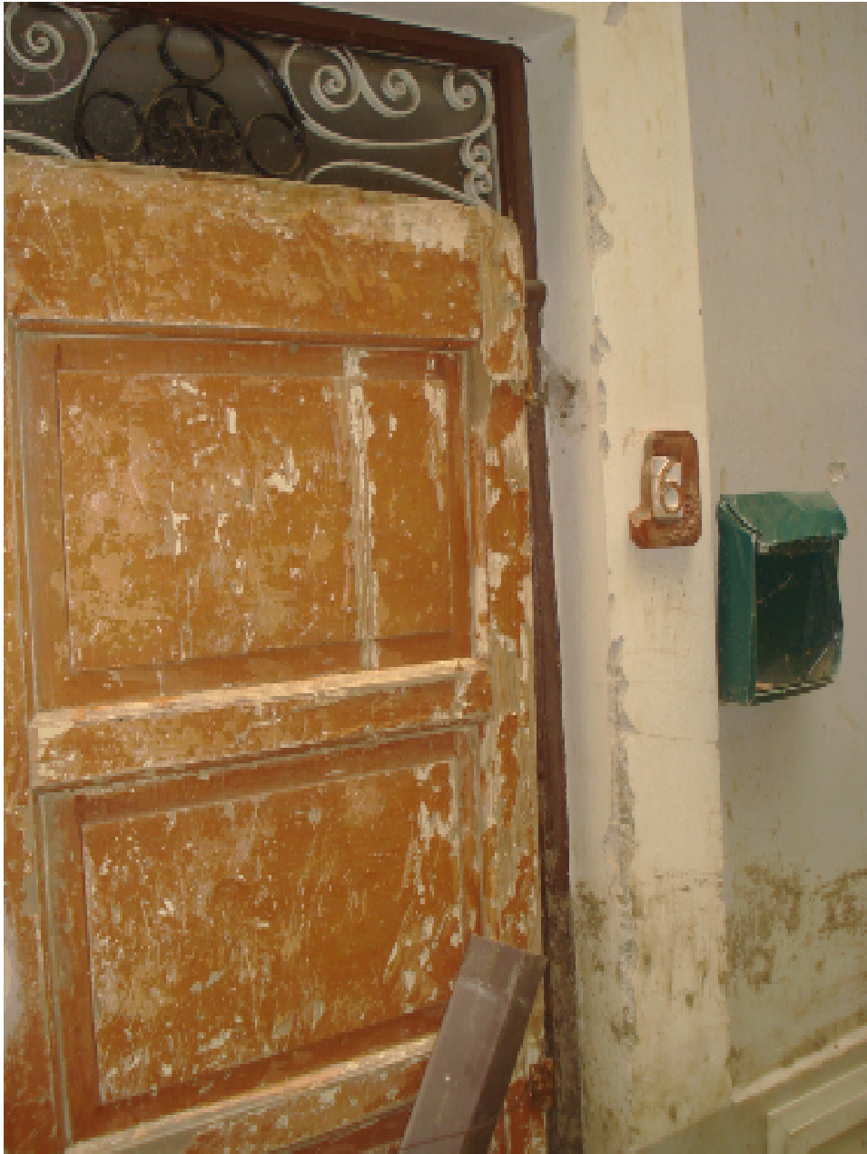
Foto n° 1 Particolare del portoncino di ingresso al fabbricato su via Lena n° 6
