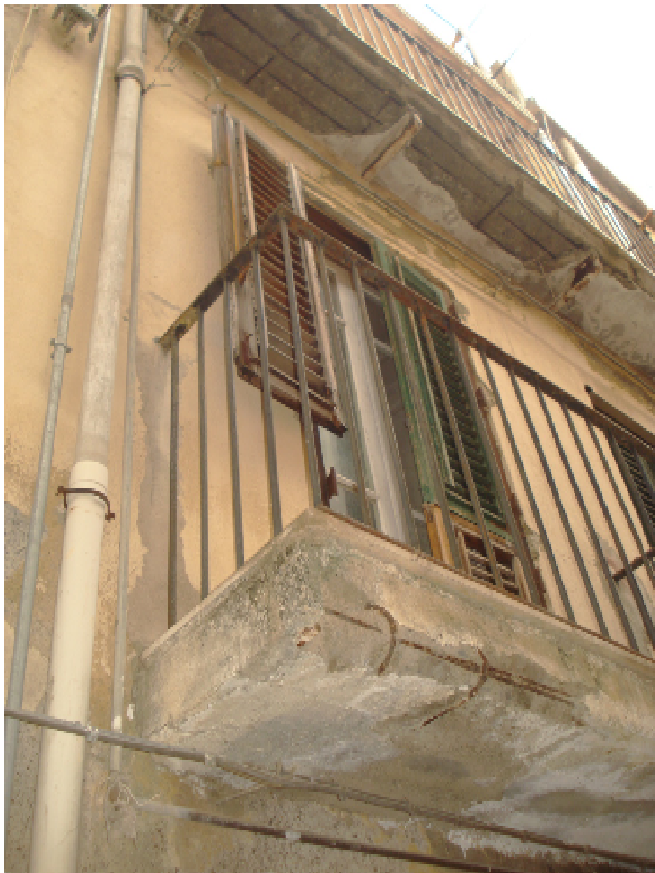
Foto n° 3 Prospetto del fabbricato lato sud (vico Lena)
