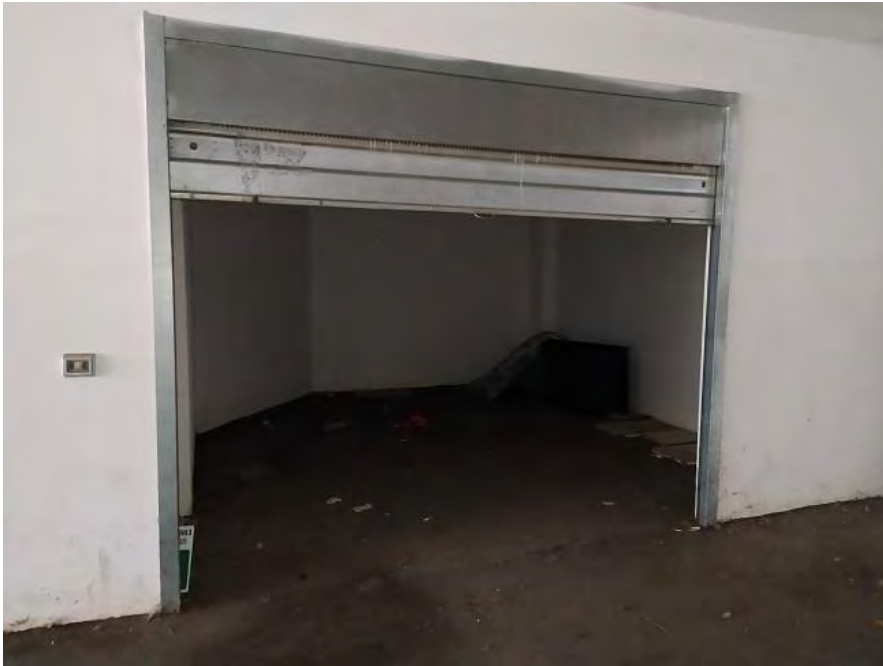
FOTO N. 34 – Interno del box auto sub. 39
