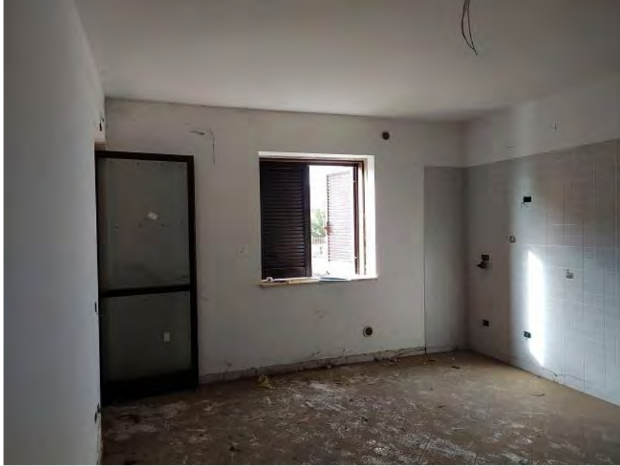
FOTO N. 21 – Cucina/soggiorno dell'appartamento sub. 11
