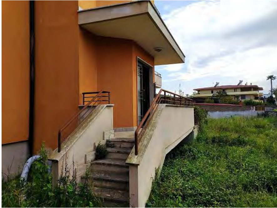
FOTO N. 3 – Accesso al fabbricato dal cortile comune
