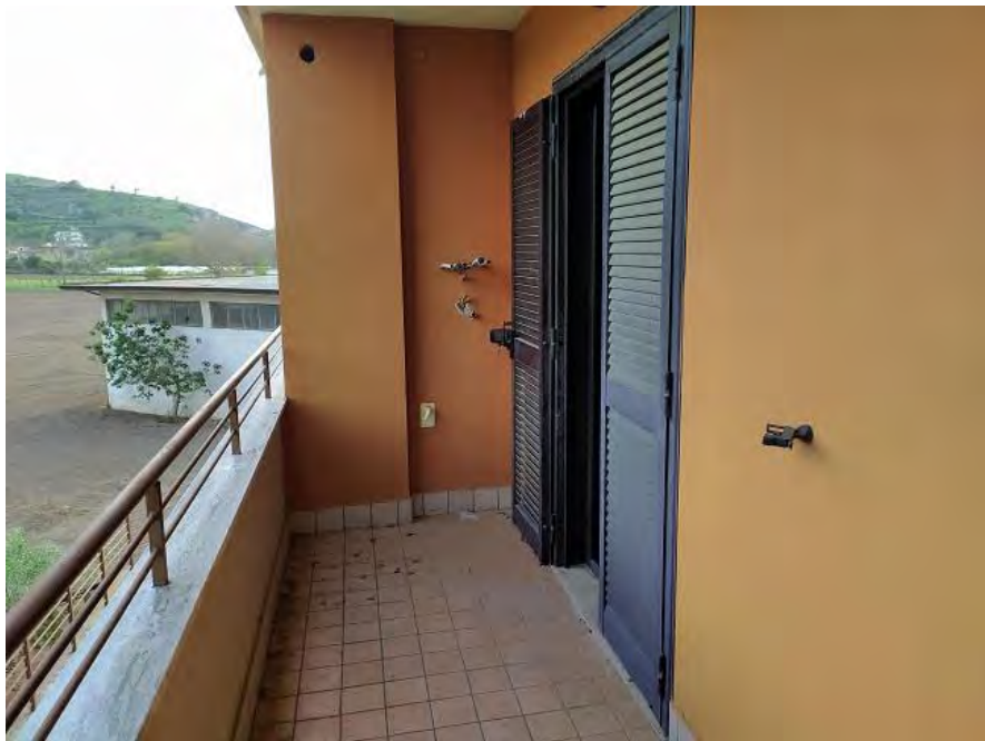
FOTO N. 12 – Balcone dell'appartamento sub. 23
