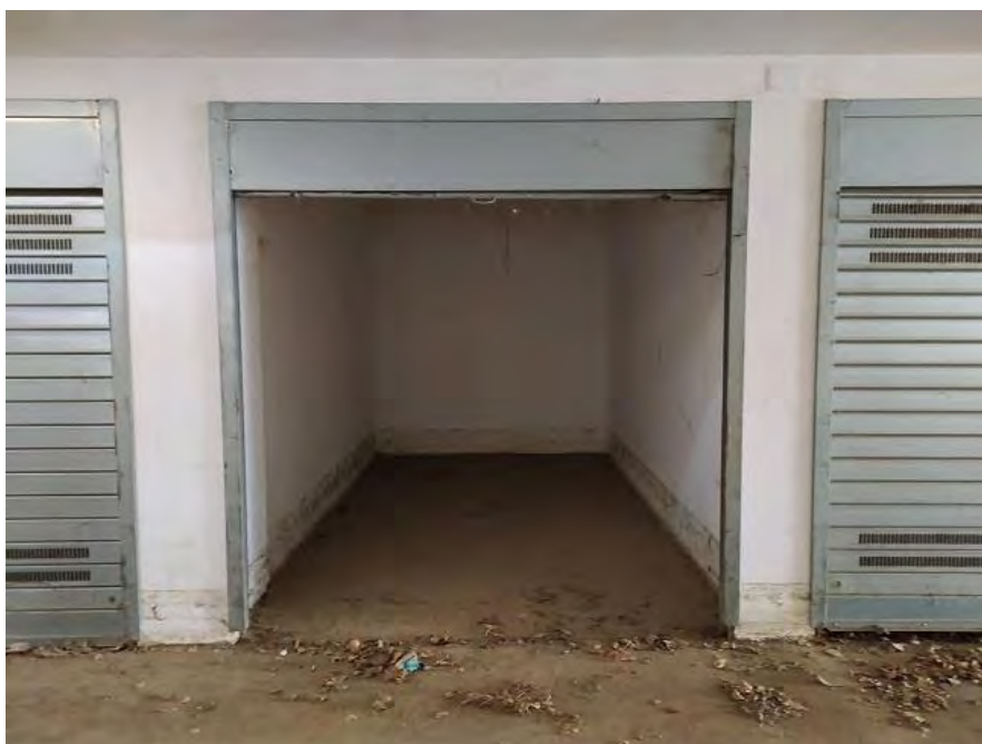
FOTO N. 16 – Interno del box auto sub. 36
