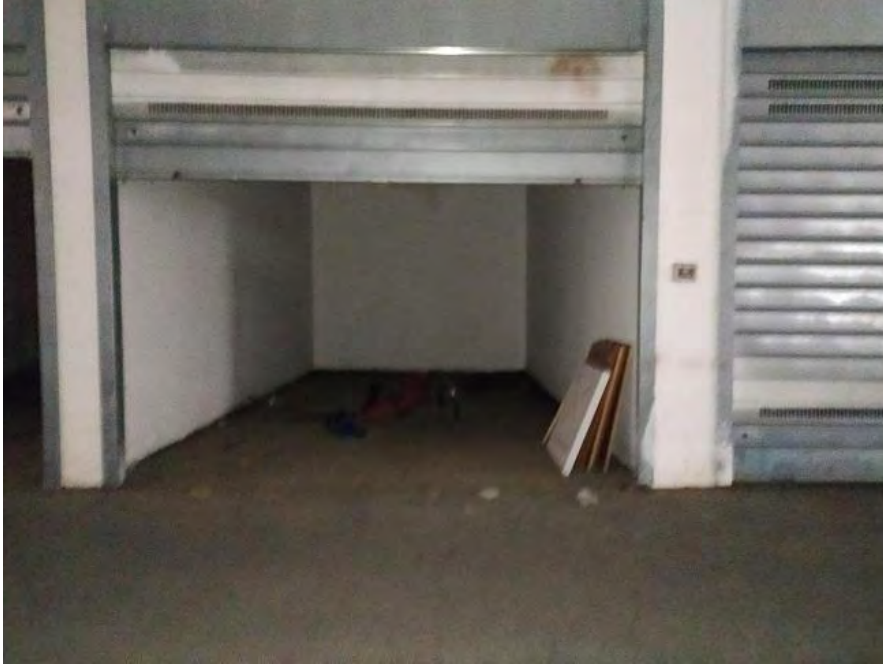
FOTO N. 31 – Interno del box auto sub. 42
