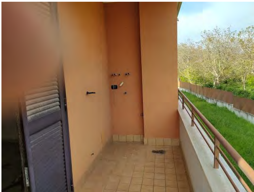
FOTO N. 27 – Balcone dell'appartamento sub. 11
