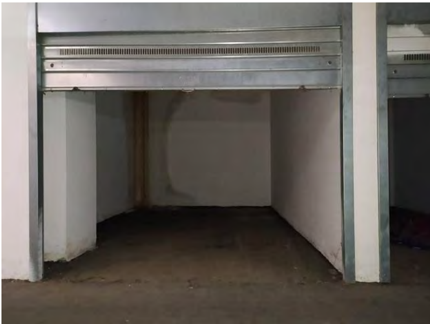
FOTO N. 32 – Interno del box auto sub. 43
