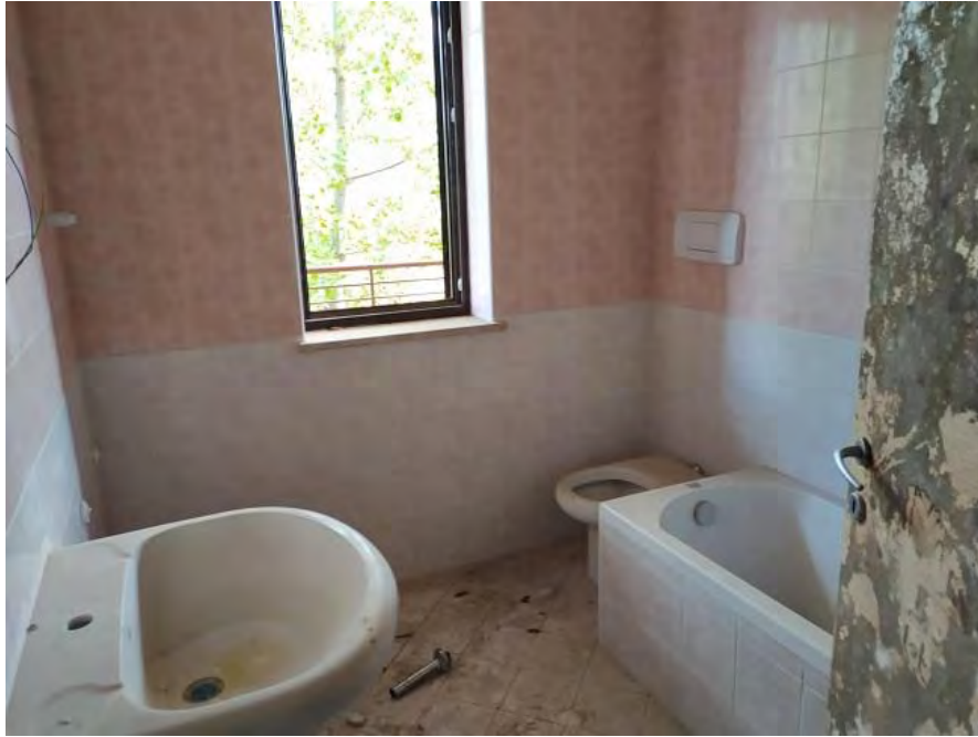
FOTO N. 9 – Bagno dell'appartamento sub. 23
