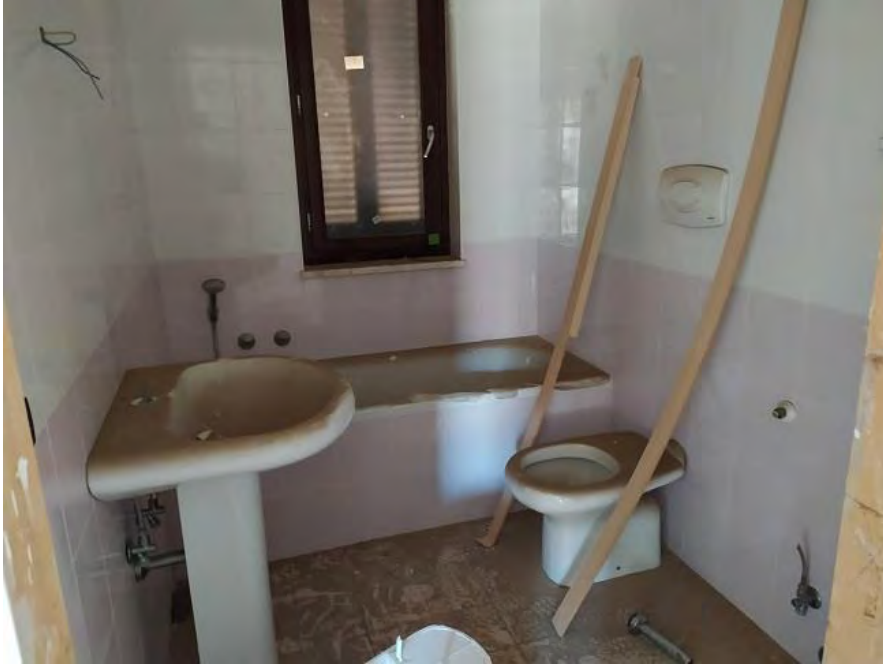
FOTO N. 25 – Bagno dell'appartamento sub. 11
