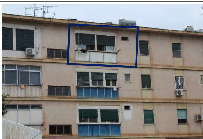
Foto n°19: Balcone di retro-prospetto
