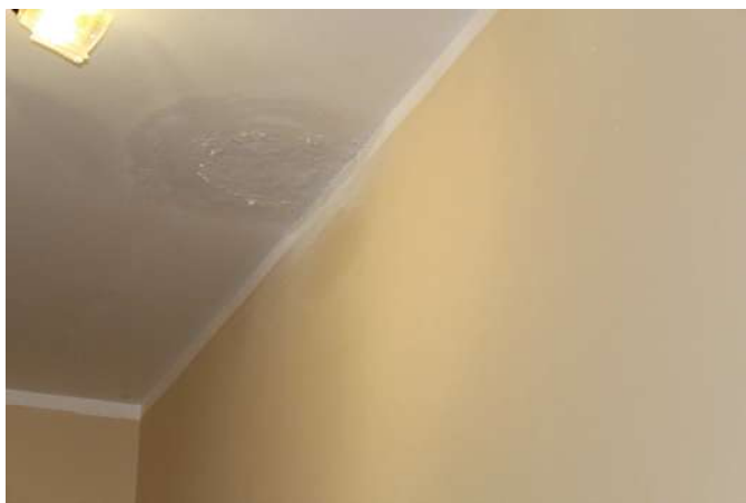
Foto n°20: Intradosso solaio w.c.
