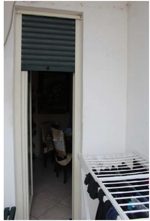
Foto n°18: Balcone su Via Barisano da Trani
