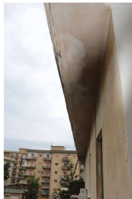
Foto n°23: Cornicione di copertura condominiale
