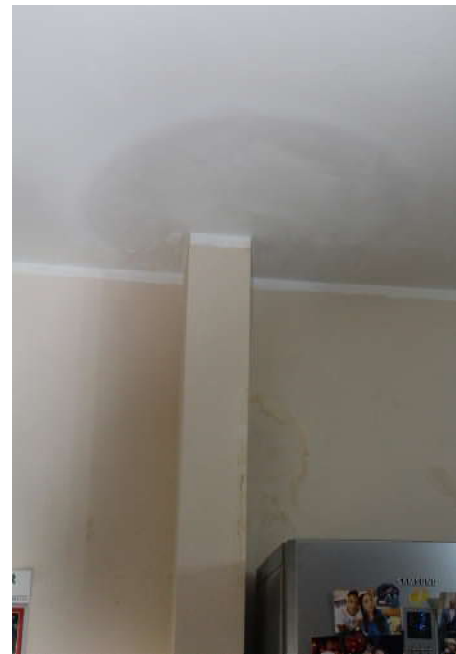
Foto n°21: Intradosso e muratura verticale cucina
