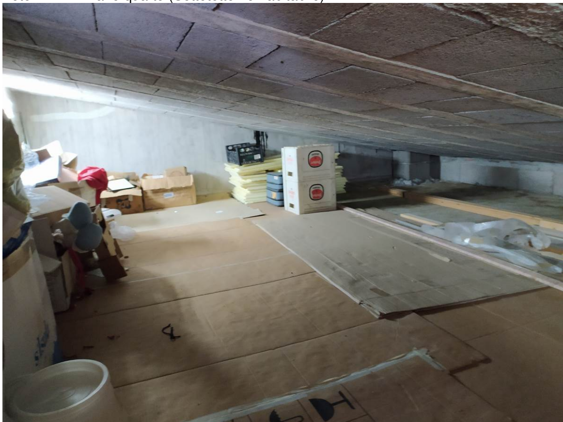
Foto n. 24 – Piano quarto (Sottotetto non abitabile)
