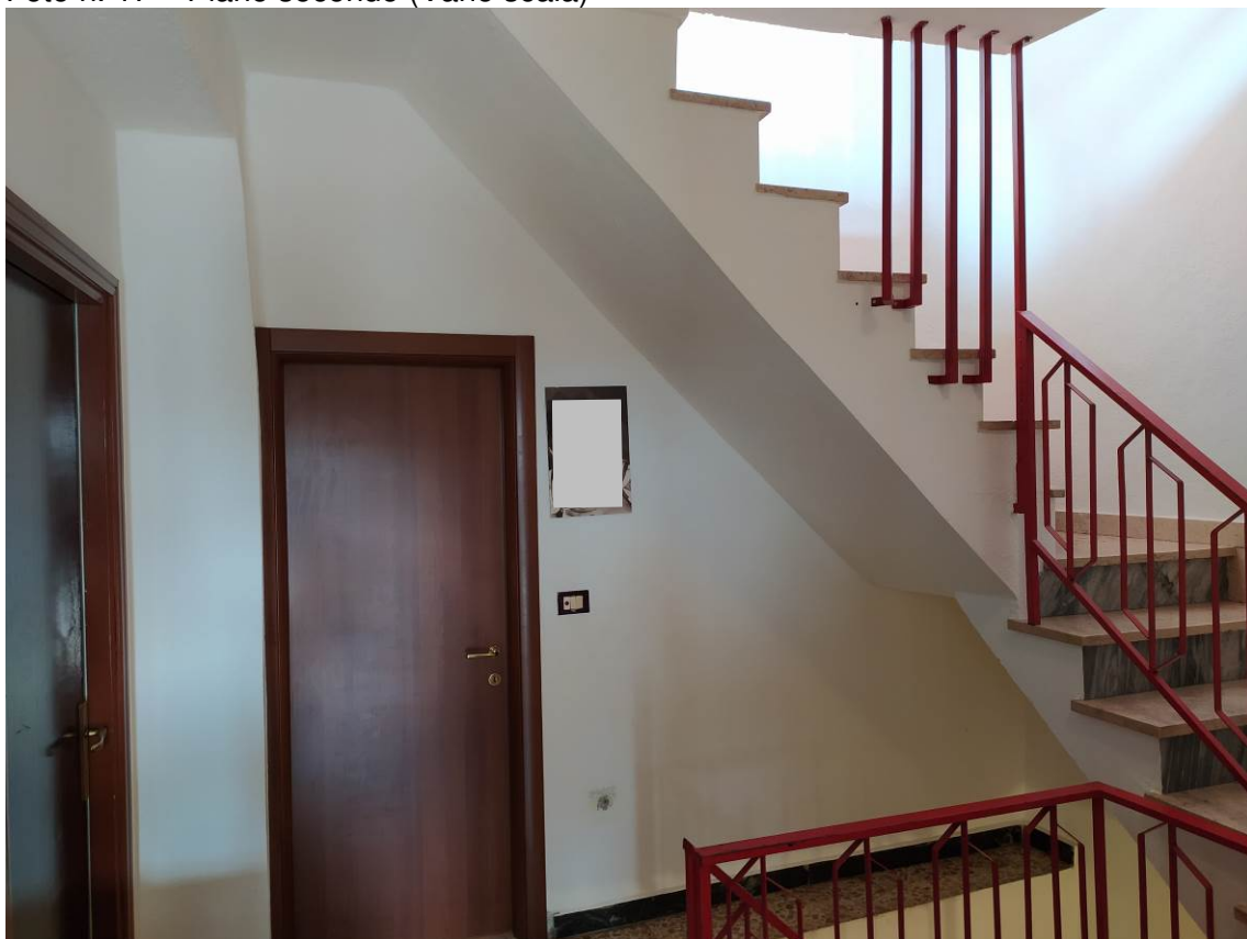
Foto n. 17 – Piano secondo (Vano scala)
