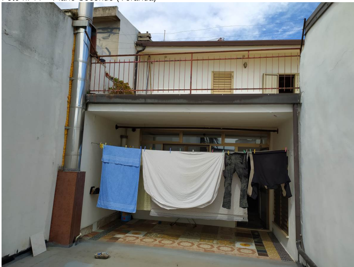
Foto n. 11 – Piano Secondo (Veranda)
