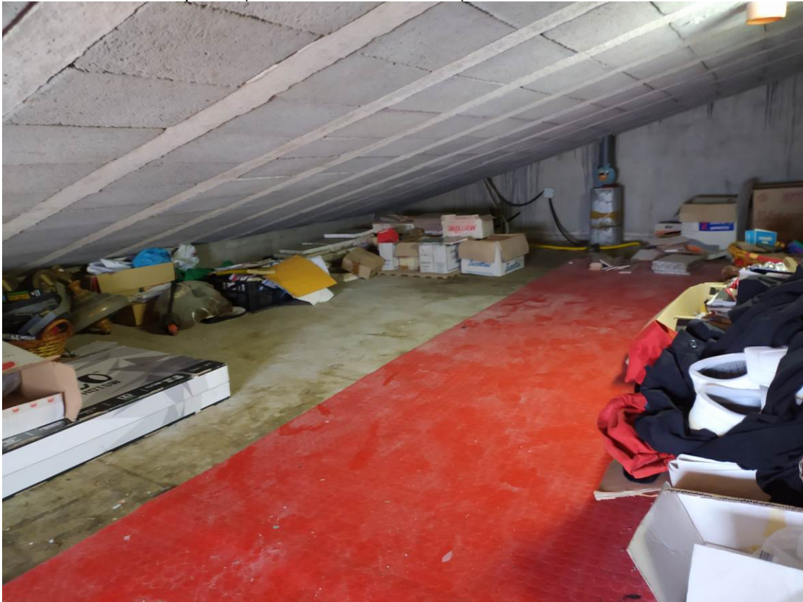
Foto n. 23 – Piano quarto (Sottotetto non abitabile)
