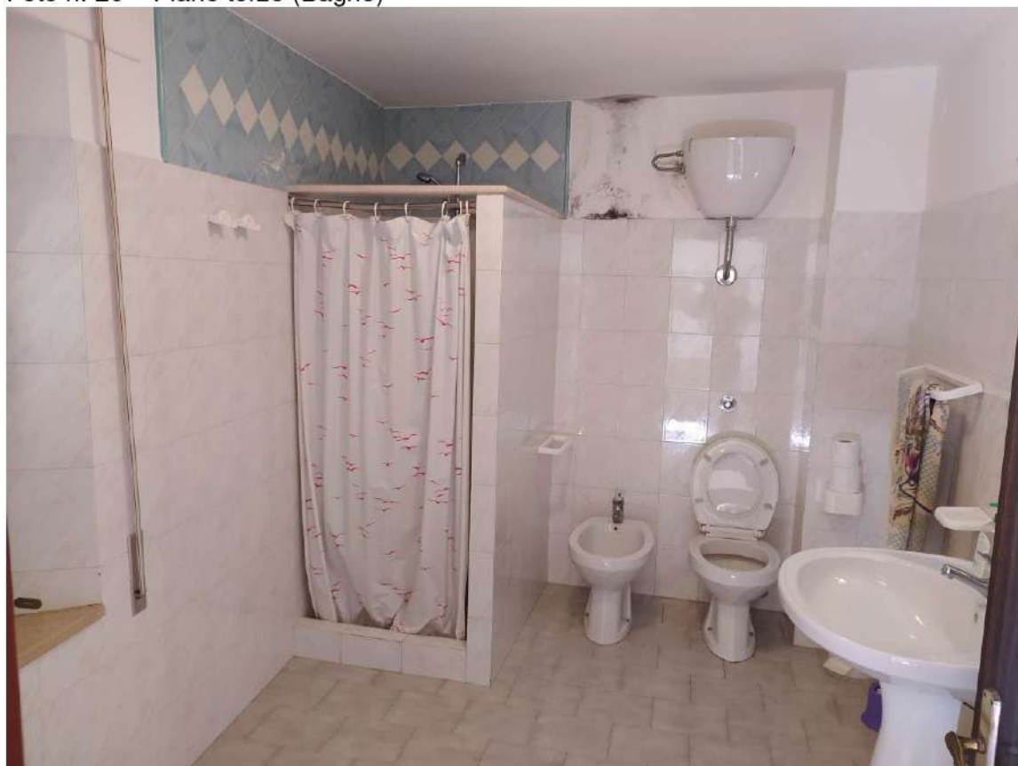
Foto n. 20 – Piano terzo (Bagno)
