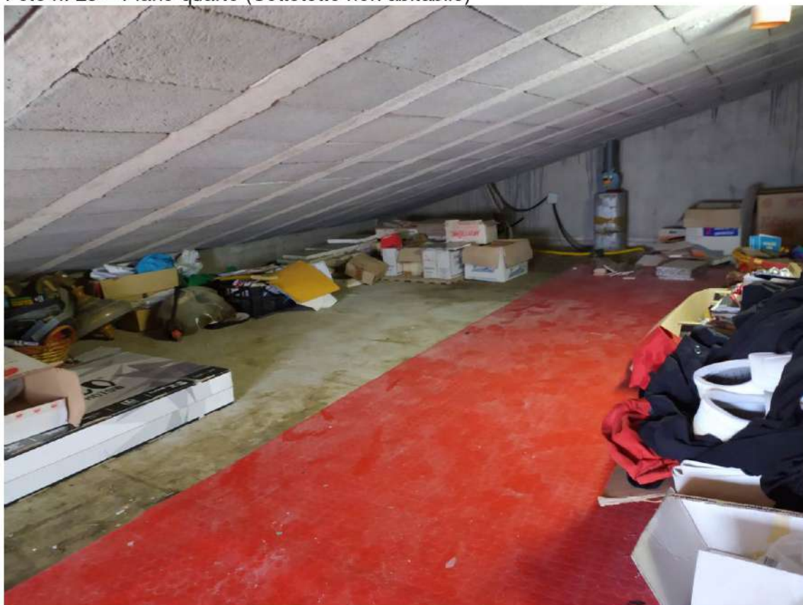
Foto n. 23 – Piano quarto (Sottotetto non abitabile)
