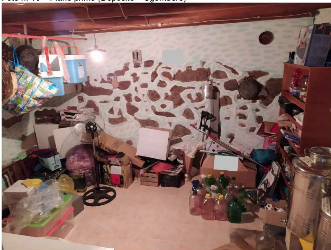
Foto n. 10 – Piano primo (Deposito – Sgombero)
