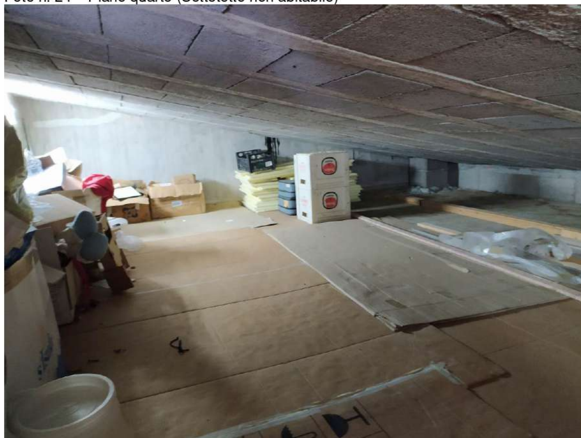
Foto n. 24 – Piano quarto (Sottotetto non abitabile)
