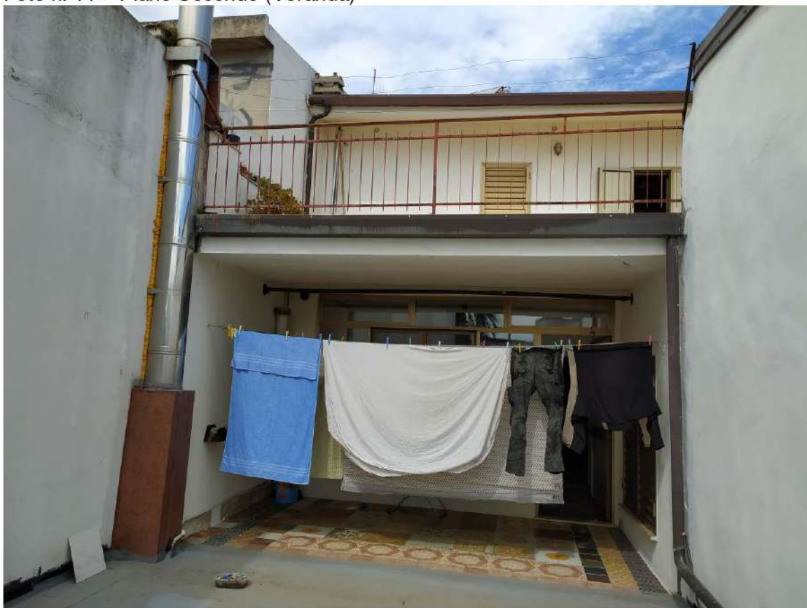
Foto n. 11 – Piano Secondo (Veranda)
