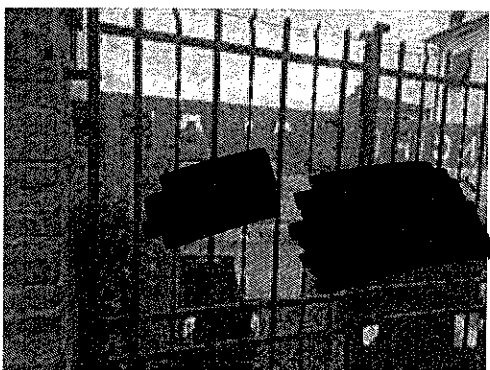
Particolare del cancello di accesso al resede posteriore
