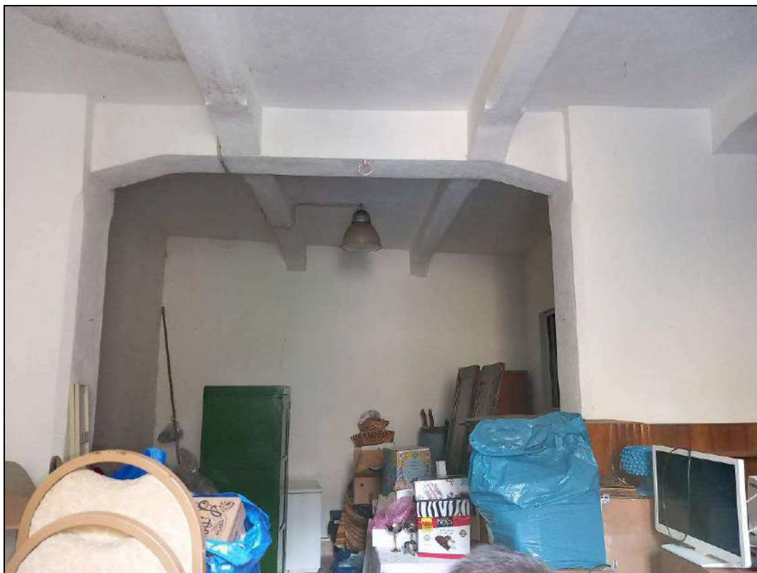
Foto 15: Vista del magazzino di cui agli immobili nn. 5 e 6, interni C e D
