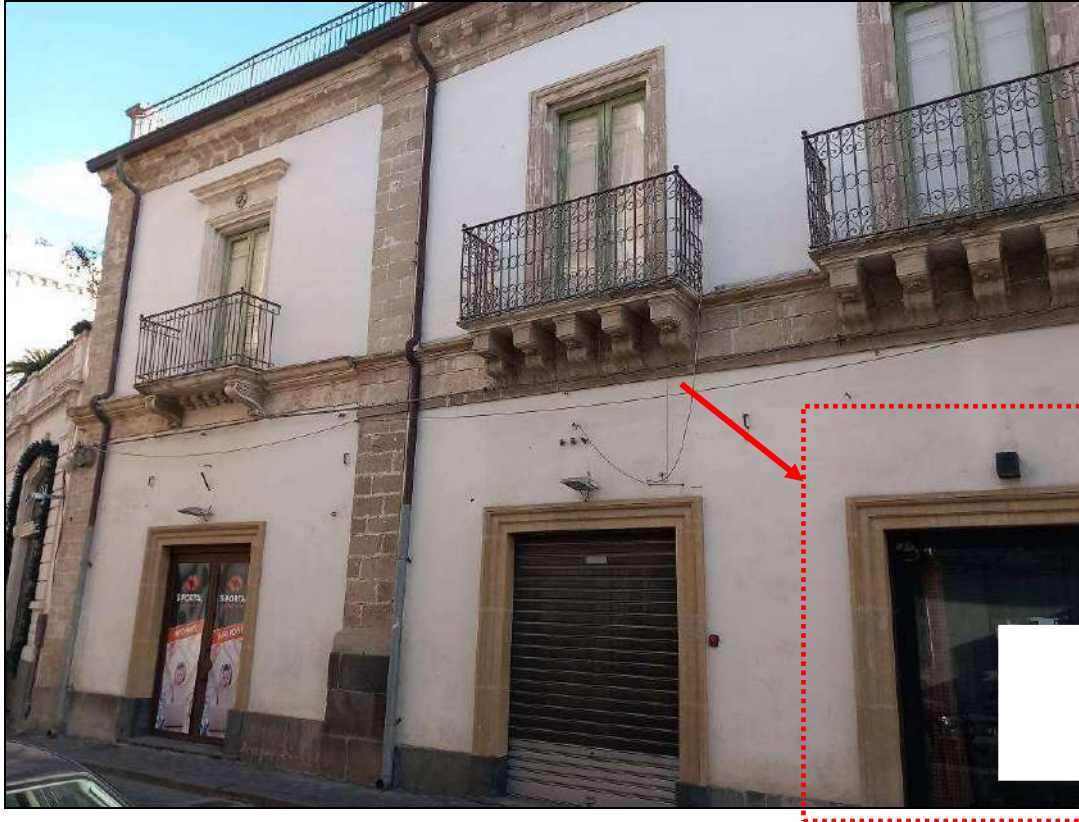
Foto 1: Vista del locale bottega dalla Via Garibaldi
