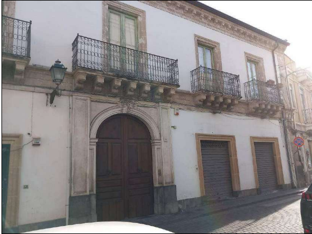
Foto 1: Vista del locale bottega dalla Via Garibaldi
