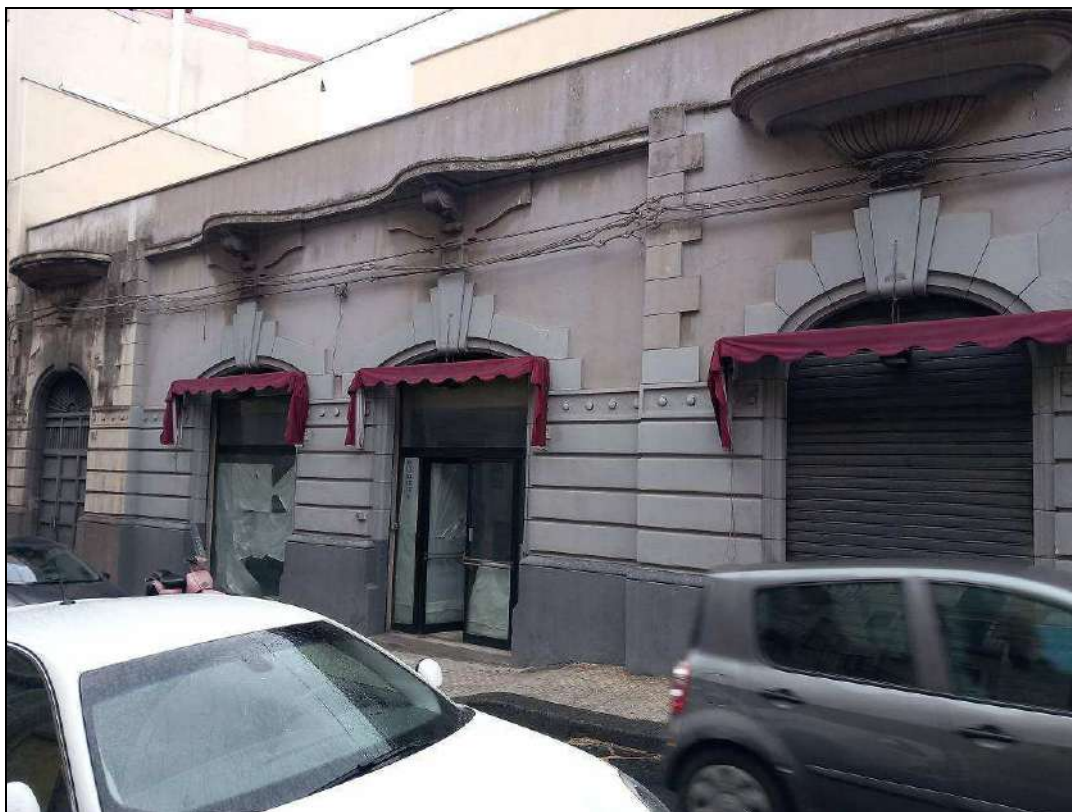
Foto 1: Vista del locale bottega dalla Via Murganzio
