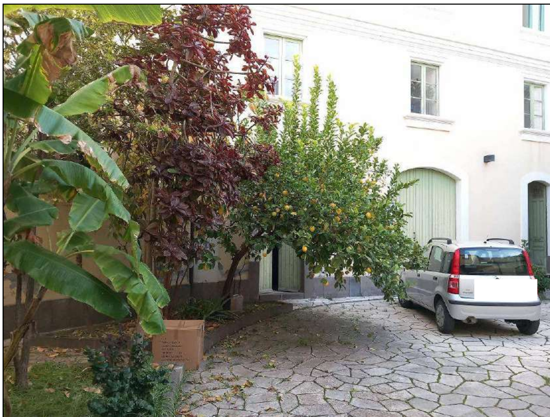
Foto 13: Vista della parte nord del cortile con individuazione degli accessi agli immobili nn. 5 e 6
