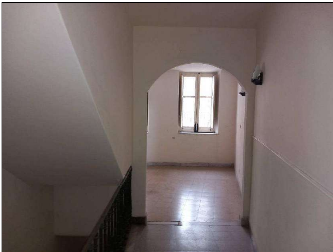
Foto 3: Vista del corridoio al primo piano
