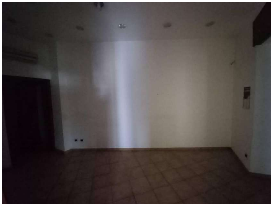
Foto 3: Vista dell'ambiente di cui al civico n. 16 della Via Garibaldi
