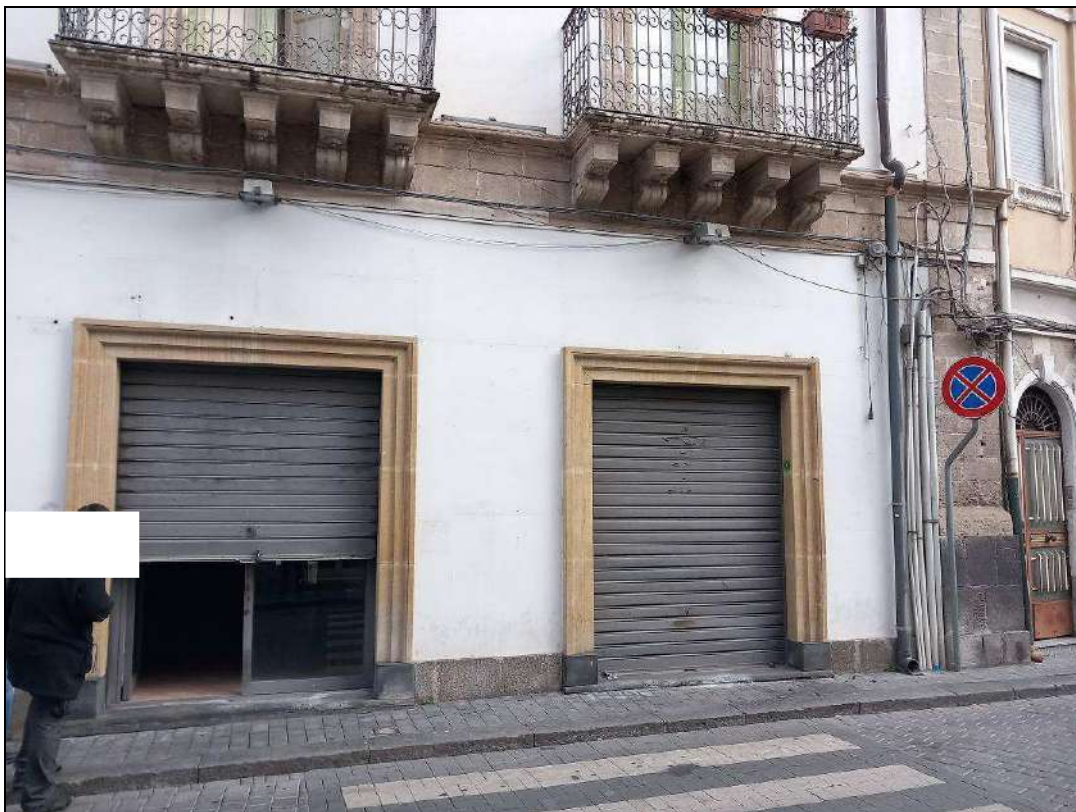
Foto 2: Vista delle due vetrine del locale commerciale in questione
