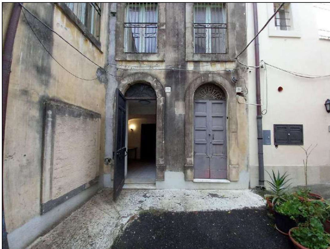
Foto 1: Vista del cortile interno sulla Via Murganzio e accesso a dx all'immobile di cui al lotto 6
