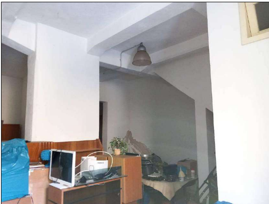
Foto 14: Vista del magazzino di cui agli immobili nn. 5 e 6, interni C e D
