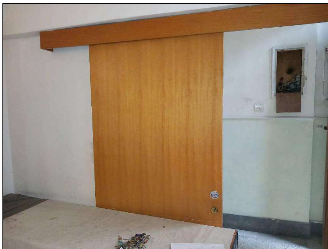
Foto 2: Vista del collegamento realizzato tra l'immobile n. 2 e il cespite in oggetto
