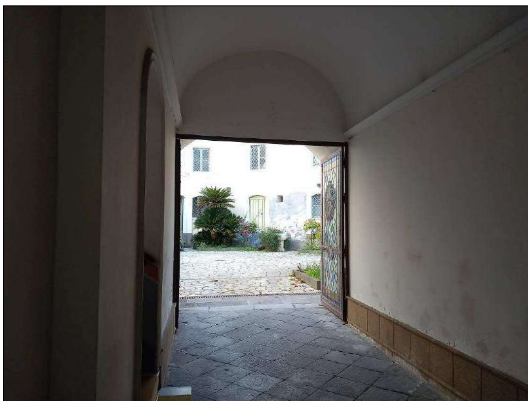
Foto 2: Vista del portico con ingresso dal civico n. 20 della Via Garibaldi che immette nella proprietà
